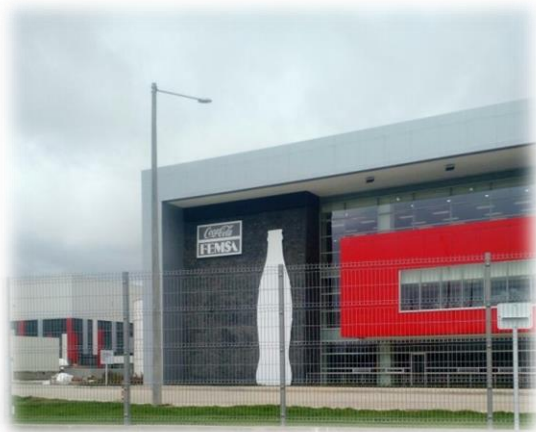
Imagen 12. Entrada Megaplanta Tocancipá
