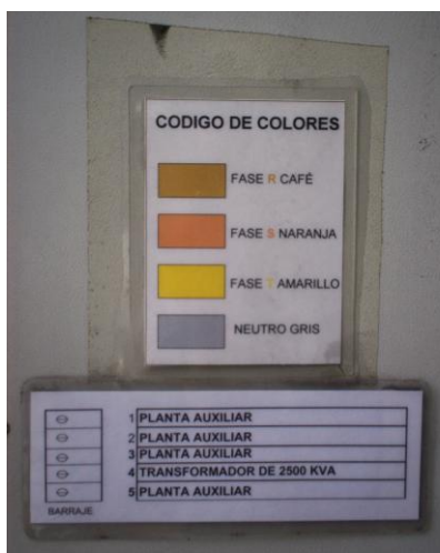
Figura 14. Identificación de circuitos y equipos en barrajes y conductores de distribución de circuitos.
