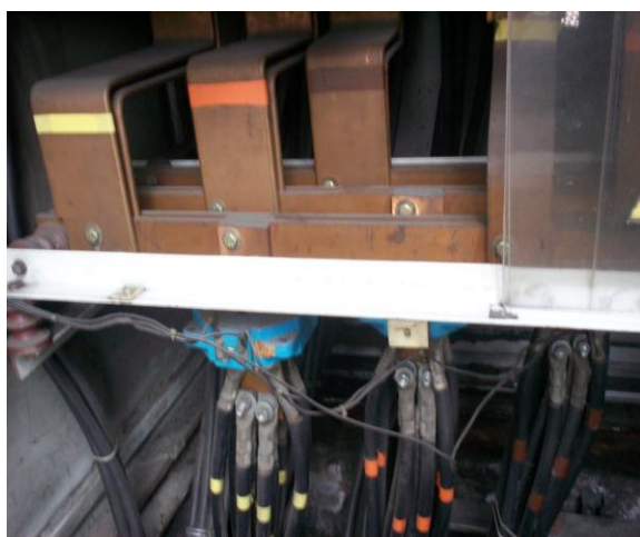
Figura 14. Identificación de circuitos y equipos en barrajes y conductores de distribución de circuitos.
