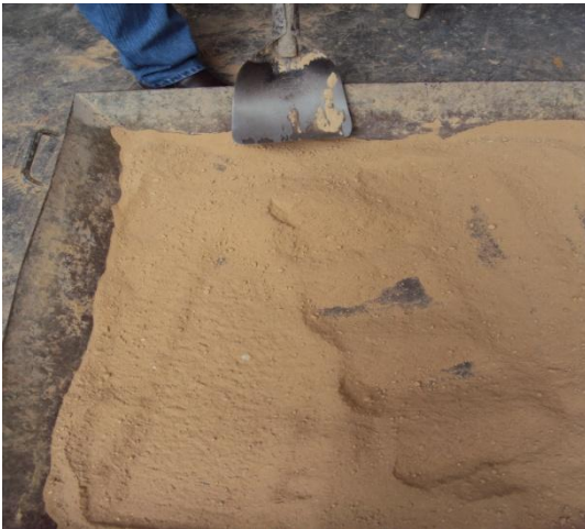
Figura 9. Material seleccionado y mezclado con humedad específica.
