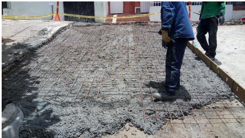
Ilustración 43 - Capa de concreto de 10 cm para colocación de la malla electrosoldada
