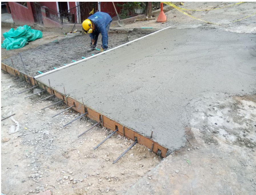
Ilustración 44 - Primera losa en concreto terminada (sin rayar)
