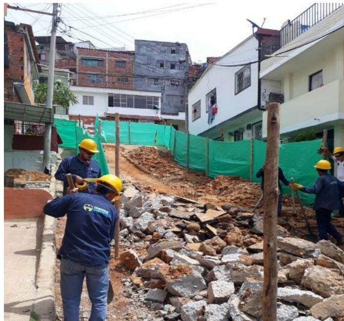
Ilustración 25 - Demolición de pavimento y concreto en el barrio Bucaramanga, Bucaramanga
