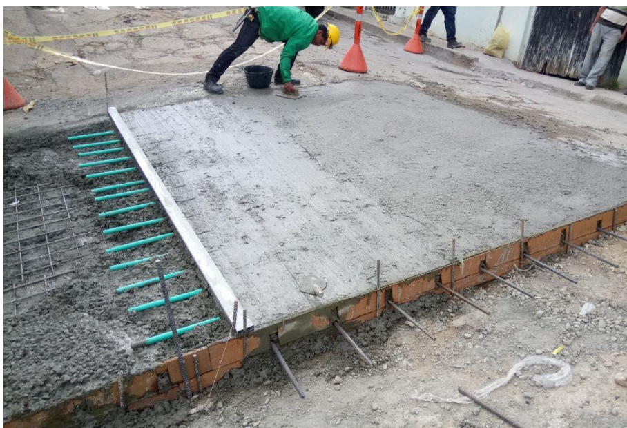
Ilustración 40 - Colocación de las juntas entre losas en el barrio Bucaramanga, Bucaramanga
