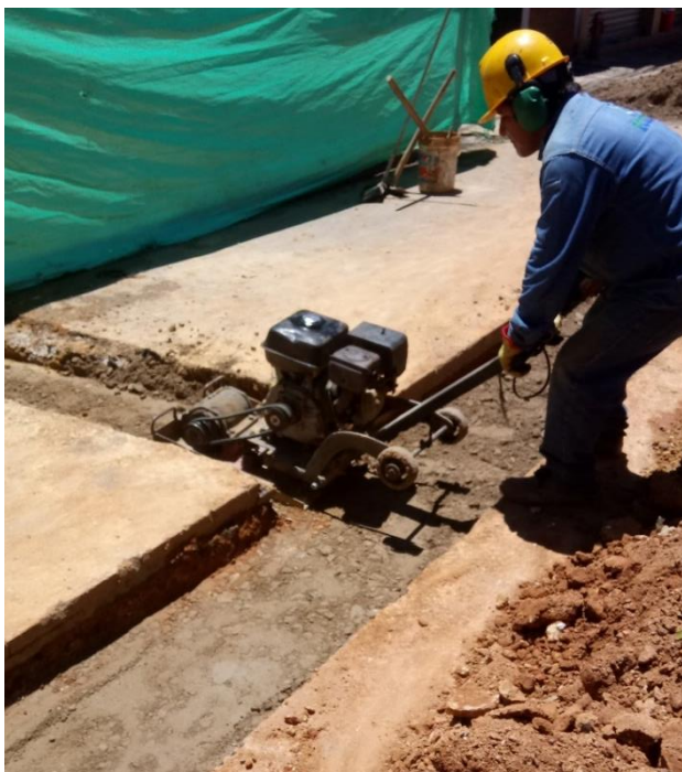
Ilustración 35 - Compactación de la rasante de la red principal y domiciliarias en el barrio El Poblado, Girón
