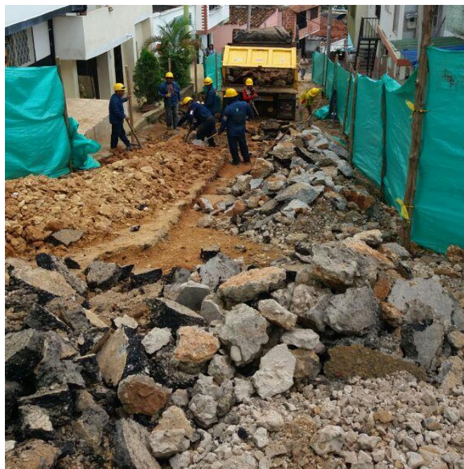
Ilustración 26 - Demolición de pavimento y concreto en el barrio Bucaramanga, Bucaramanga
