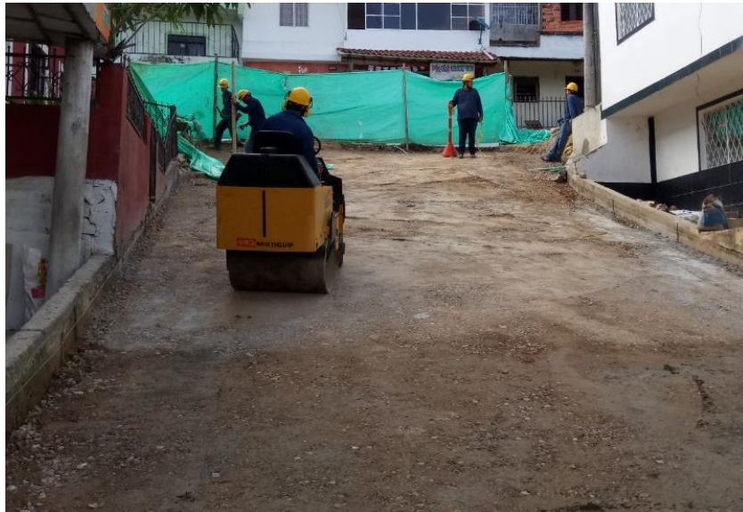
Ilustración 34 - Compactación base granular en el Barrio Bucaramanga, Bucaramanga
