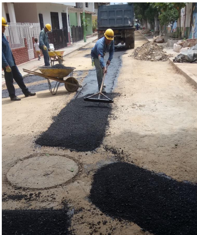
Ilustración 38 - Pavimentación espina de pescado barrio Santa Cruz, Girón
