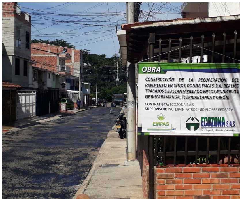
Ilustración 47 - Riego de impregnación asfáltica en el barrio El Poblado, Girón
