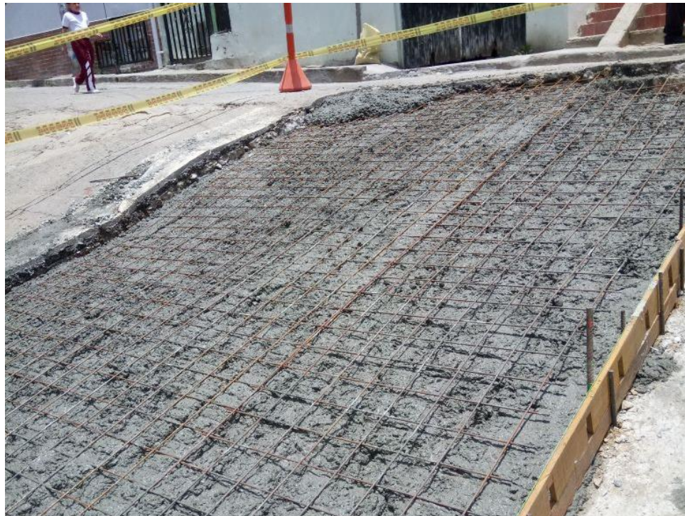
Ilustración 39 - Colocación de la malla electrosoldada barrio Bucaramanga, Bucaramanga
