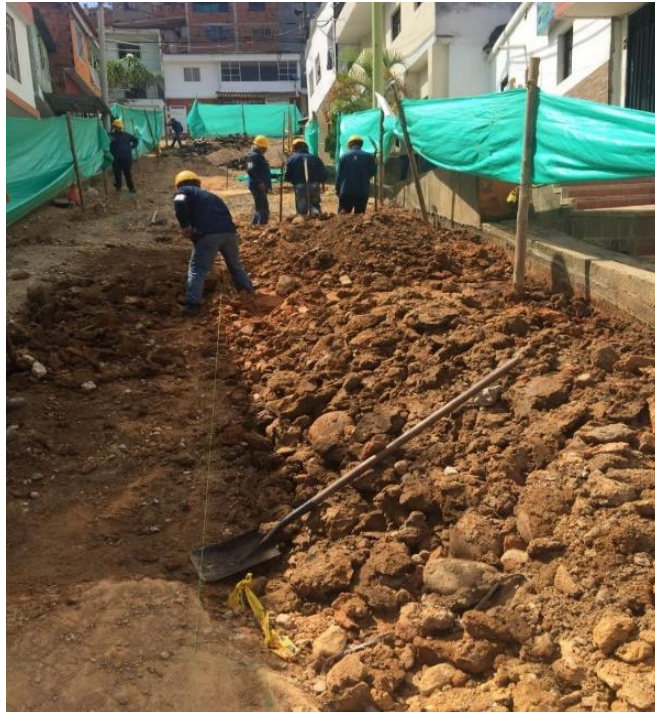
Ilustración 24 - Excavación barrio Bucaramanga, Bucaramanga
