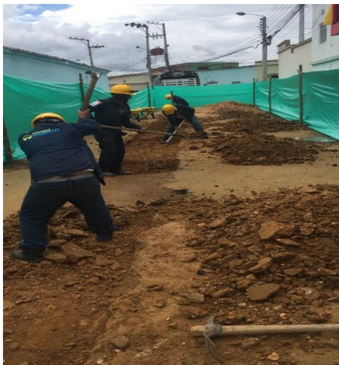
Ilustración 22 - Excavación barrio Nariño, Bucaramanga
