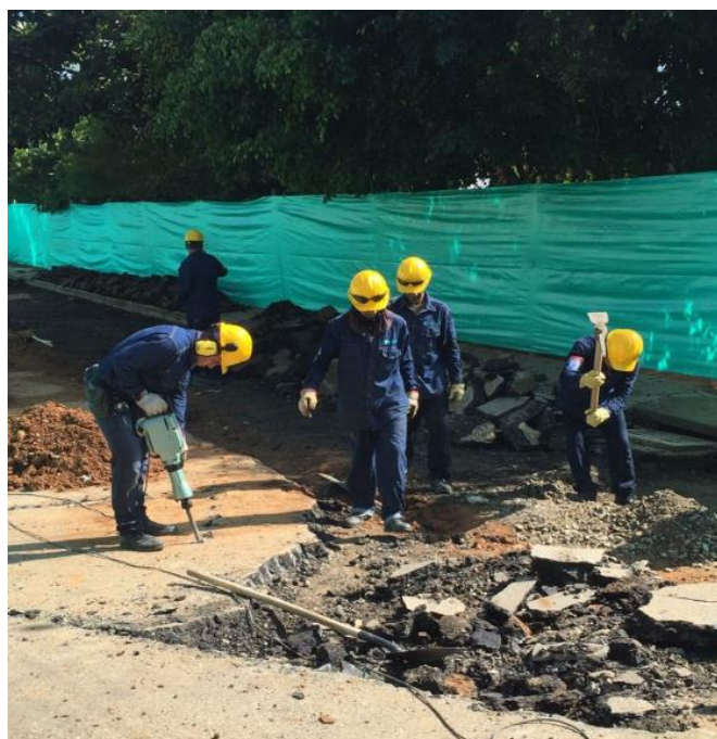
Ilustración 27 - Demolición de pavimento en el barrio Nariño, Bucaramanga
