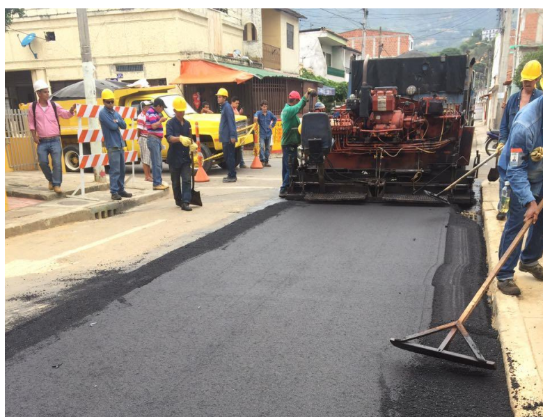
Ilustración 48 - Sello asfáltico en el barrio El Población, Girón.
