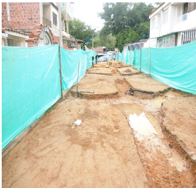
Ilustración 21 - Excavación barrio El Poblado, Girón
