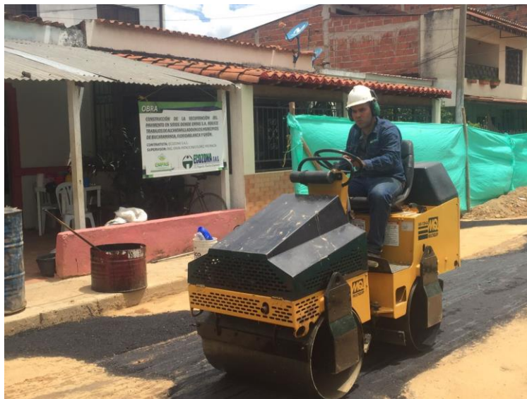
Ilustración 36 - Compactación pavimento red principal y domiciliarias en el barrio El Poblado, Girón
