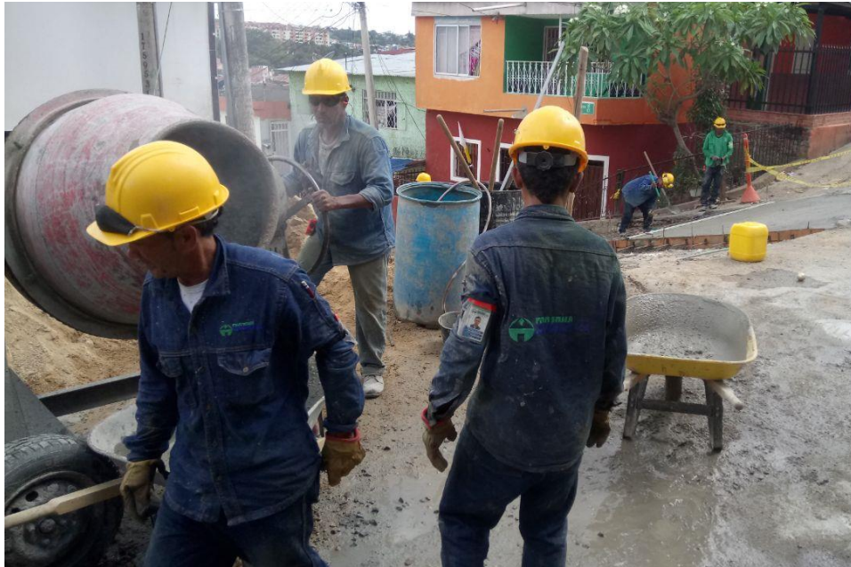
Ilustración 42 - Preparación del concreto en obra
