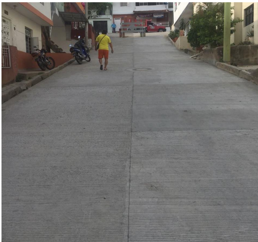
Ilustración 46 - Pavimento en concreto terminado en el barrio Bucaramanga, Bucaramanga
