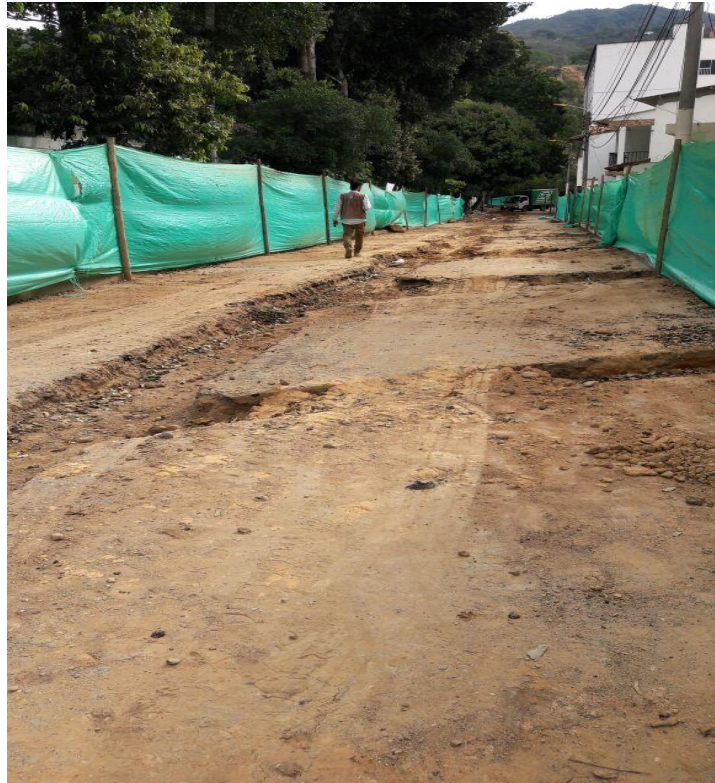
Ilustración 17 - Cerramiento en el barrio Santa Cruz, Girón
