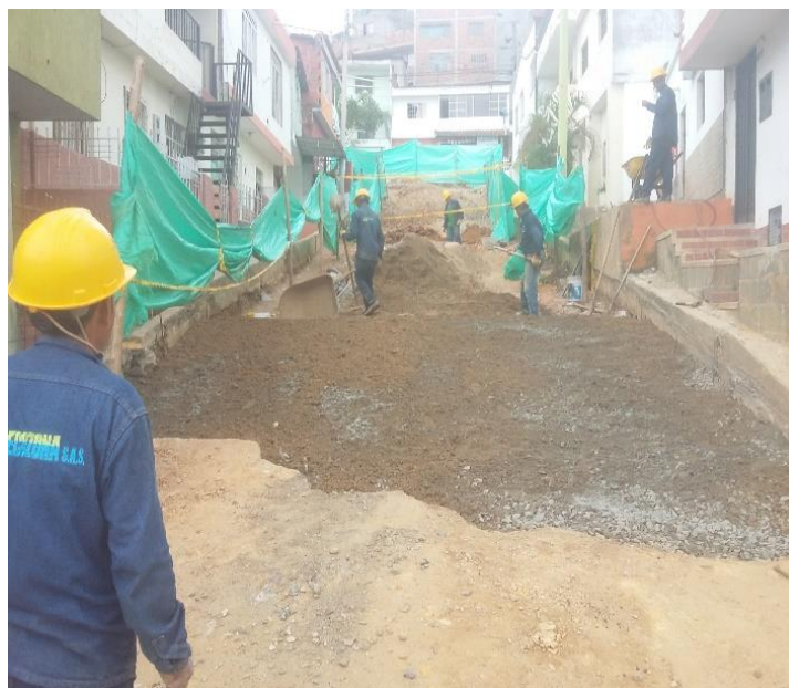
Ilustración 32 - Base en suelo cemento barrio Bucaramanga, Bucaramanga
