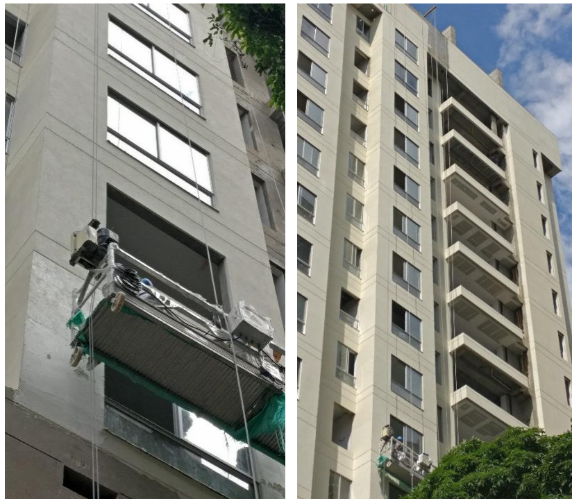
Figura 16, Aplicación nueva textura aprobada por la obra, Moratto 44
