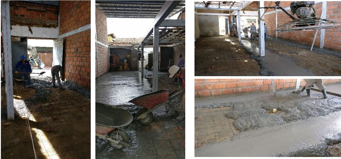
Figura 5, Fundicion de placa e=8cm concreto 3000 psi, Bodega Calle 52.
