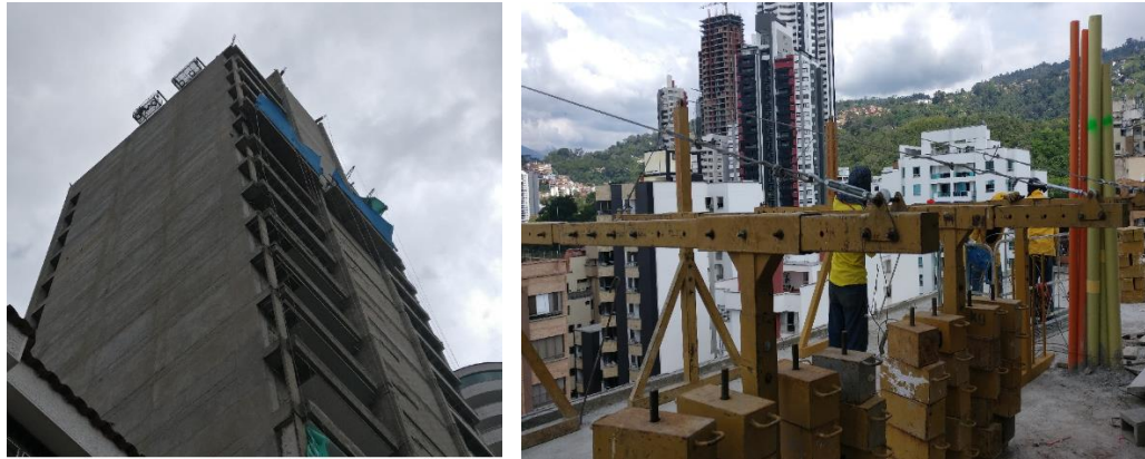
Figura 10, Instalación de andamios manuales, culata norte, Moratto 44
