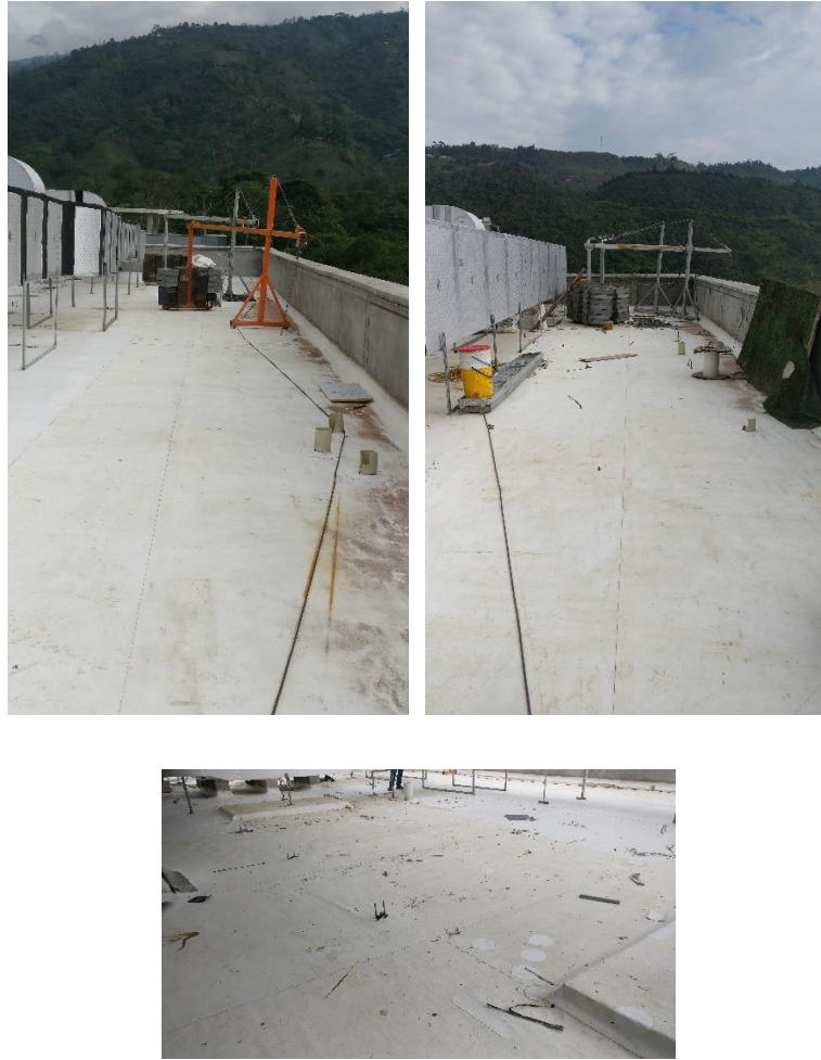
Figura 21. Reparación impermeabilización sobre terrazas HIC, tramo 1, Nivel 38
