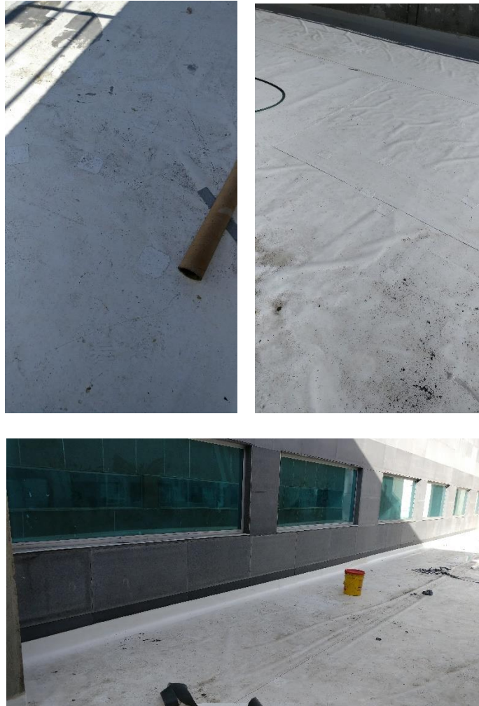
Figura 20. Reparación Jardines internos HIC, tramo 2, Nivel 13.65
