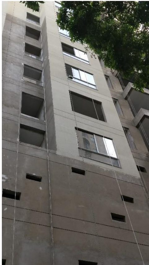
Figura 15, Aplicación con agua adicional, Moratto 44
