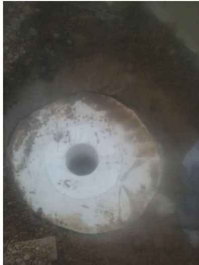
Figura 22, Impermeabilización sifones Healing Garden, HIC Fuente: Autor
