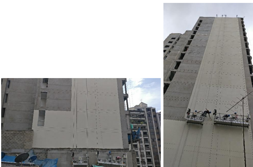
Figura 14, registro fotografico, unificacion de textura al inicio de la obra, Moratto 44 Fuente: Autor
