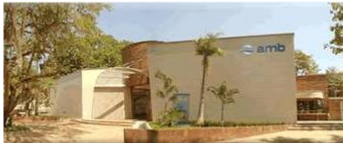
Figura 6. Acueducto Metropolitano de Bucaramanga.
