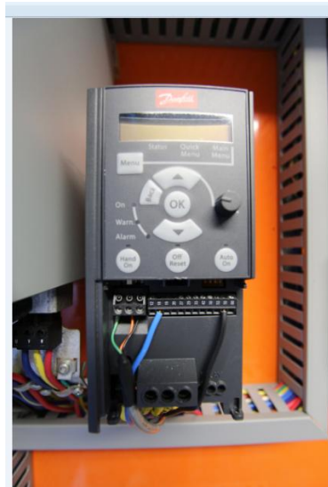
Figura 34. Conexión del Variador de Frecuencia FC 51
