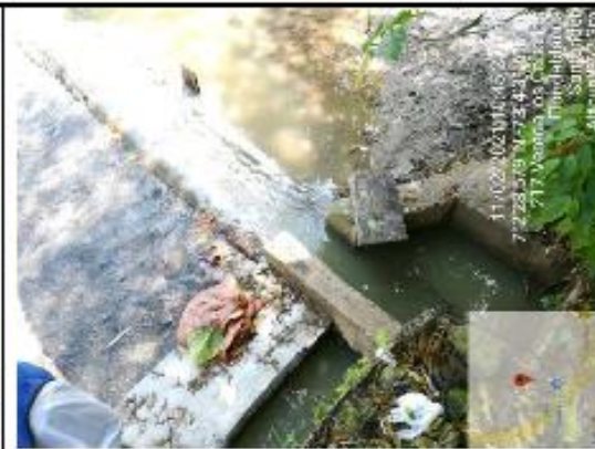
Imagen 6. Canal de Aduccion – Antigua Bocatoma.
