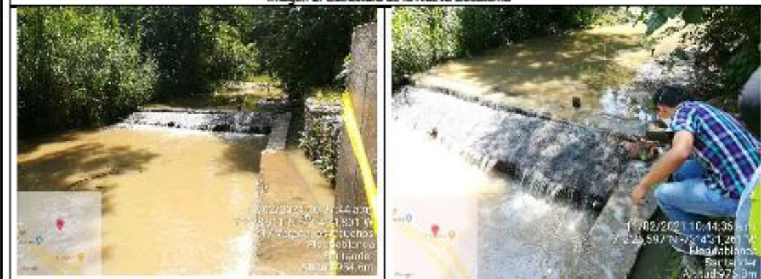
Imagen 3. Dique y Canal de Aduccion, antigua Bocatoma
