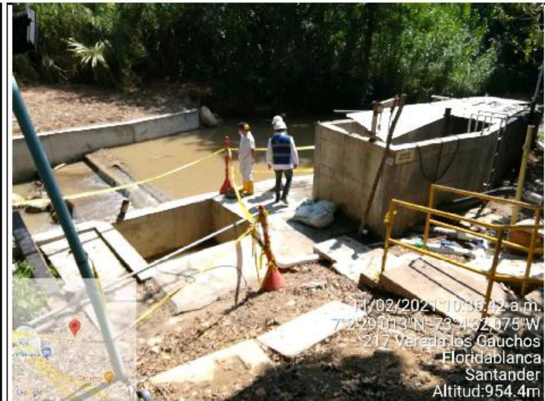
Imagen 2. Estructura de la Nueva Bocatoma
