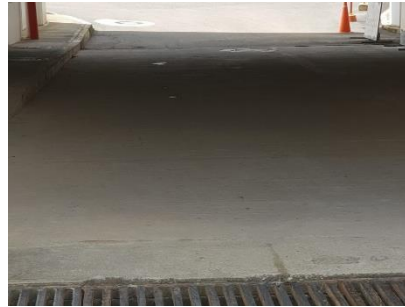
Imagen 6. Tramo en concreto. Fuente: Elaboración propia
