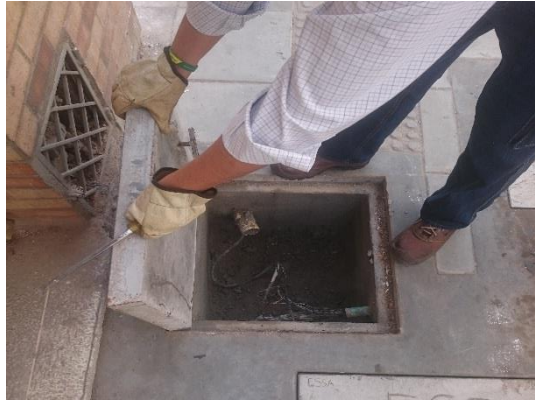
Figura 32. Cámara 0.60 x 0.60m Fuente: Autor
