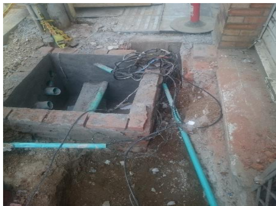
Figura 31. Construcción cámara
