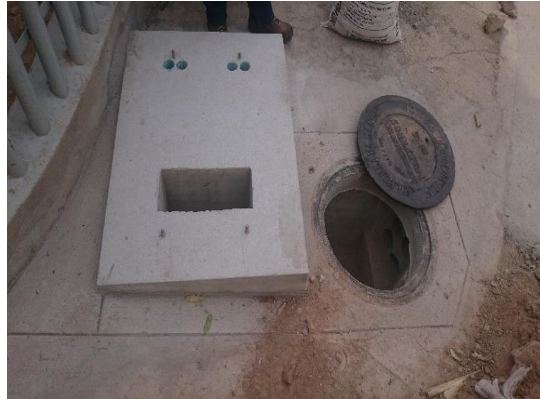
Figura 18. Base y cámara de AFO – 4649 Fuente: Autor
