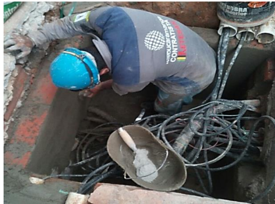
Figura 6. Mampostería y friso de cámara Fuente: Autor
