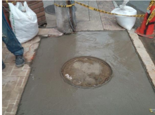
Figura 11. Fundida de placa superior Fuente: Autor
