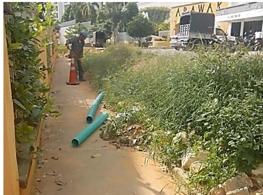
Figura 8. Localización y replanteo Fuente: Autor
