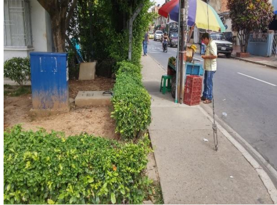
Figura 21. Andén intervenido en AFO 3640
