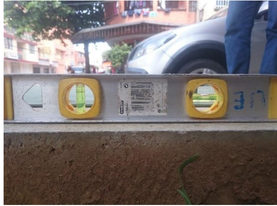
Figura 23. Base nivelada
