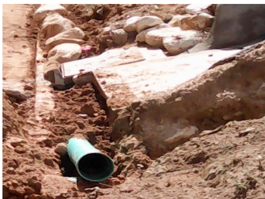
Figura 9. Compactación de la canalización Fuente: Autor
