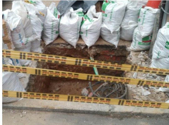
Figura 10. Demolición de cámaras Fuente: Autor
