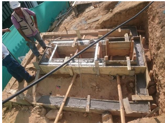
Figura 27. Viga para el equipo RSU Fuente: Autor
