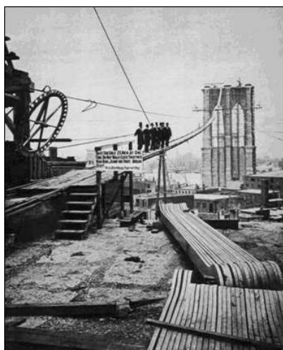
6.14. Fotografía sobre el anclaje de Brooklyn.
