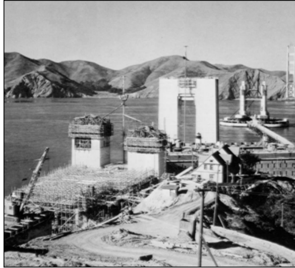
6.27. Construcción de anclajes
