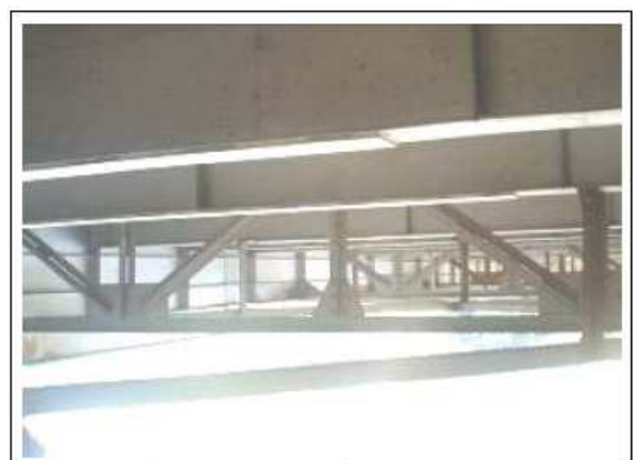
9.6. Detalle de las vigas transversales principales
