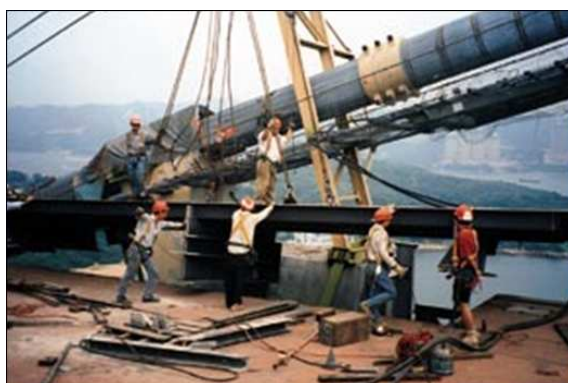
6.45. Colocación de las unidades más pequeñas del tablero.
