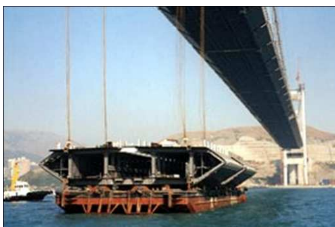
6.43. Dos uniones típicas del tablero de 41m x 18m x 7,8m.
