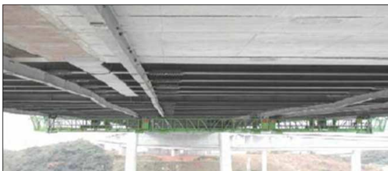
6.47. Plataforma móvil bajo la cubierta de la carretera.
