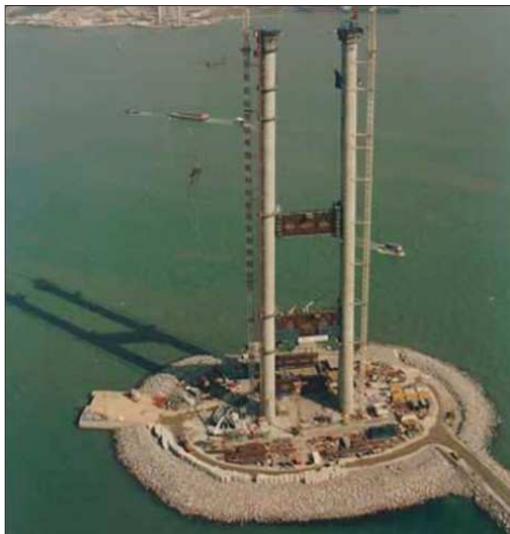
6.37. Construcción de la torre.
