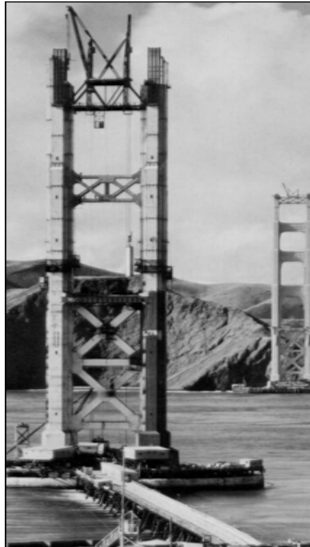
6.28. Construcción de torre
