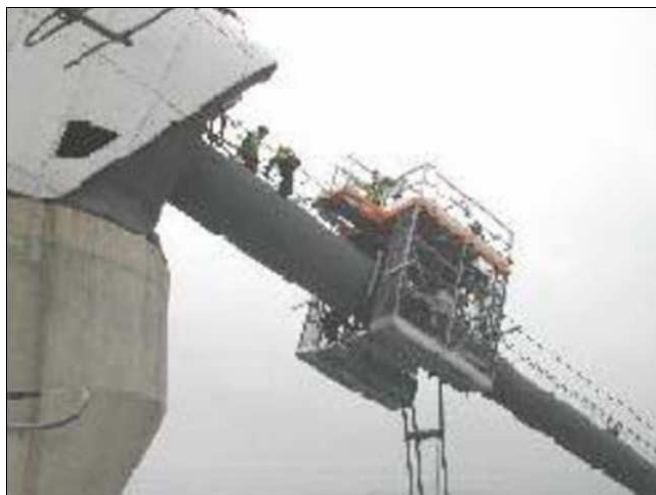
6.48. Andamio móvil de inspección
