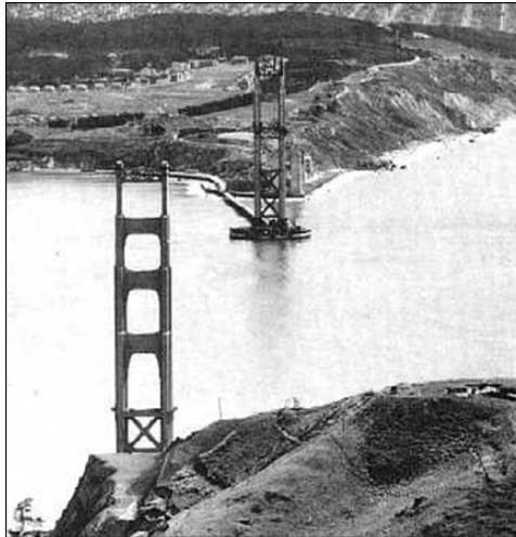
6.30. Vista de las torres
