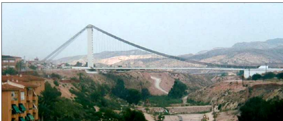
10.6. Puente sobre el río Vinalopó
