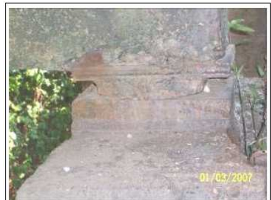
9.18. Detalle del apoyo de la viga de concreto longitudinal en la pila de concreto.
