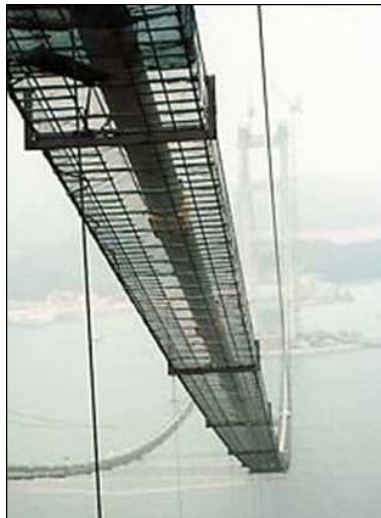
6.38. Pasarela suspendida en el cable principal, visto desde la parte inferior.
