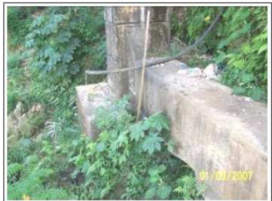
9.12. Parte inferior de la pila de concreto, sobre el terreno.
