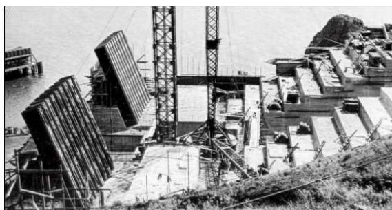
6.23. Construcción anclajes (primera sección)
