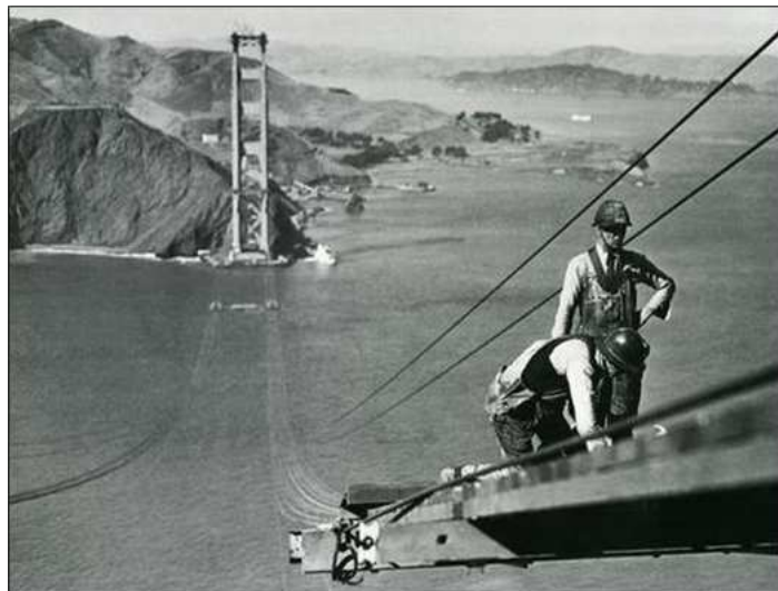
6.32. Hombres arreglando los cables
