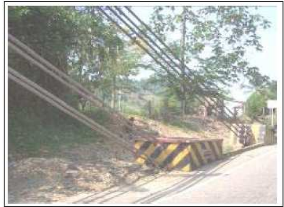
9.10. Vista general del anclaje de los cables.
