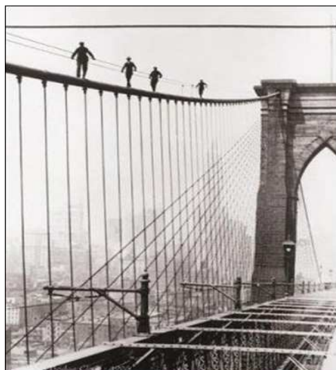
6.19. Hombres trabajando en los cables.
