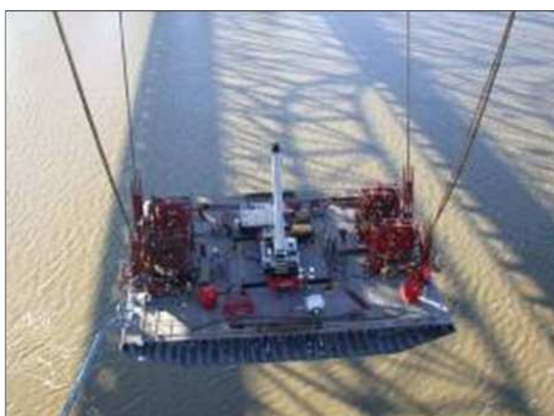
6.57. Detalle de la viga cajón.
