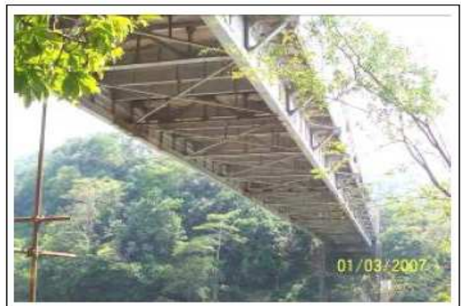
9.2. Vista inferior del tablero de la luz principal en estructura metálica.
