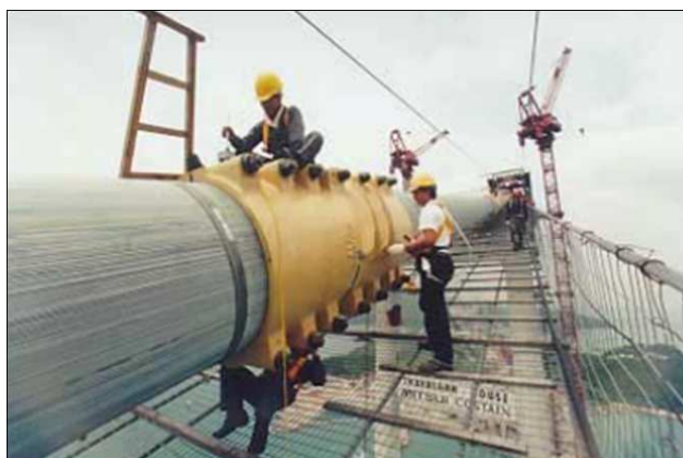
6.41. Posicionamiento del cable principal.
