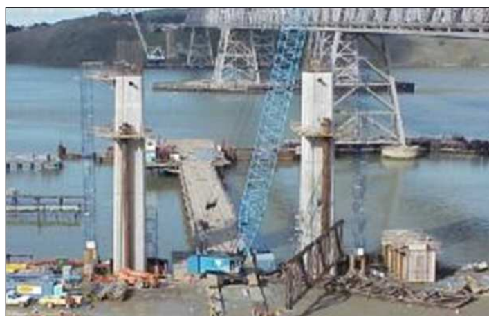
6.55. Construcción de la torre.
