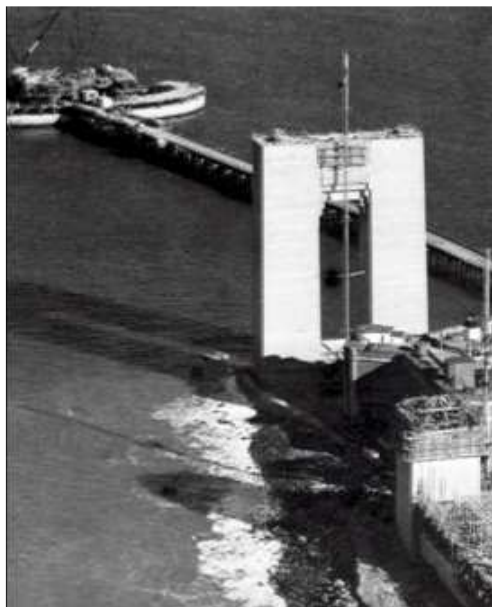
7.26. Construcción de anclajes
