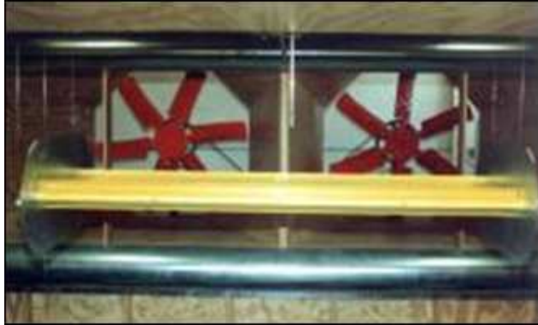
5.5. Cuello del túnel.
