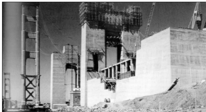
6.25. Construcción de anclajes
