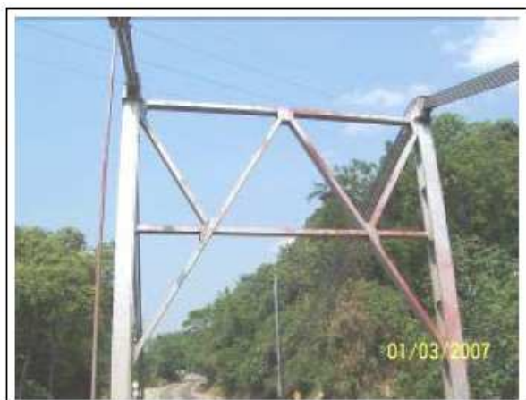
9.3. Vista general de las columnas de la torre y los arriostramientos.
