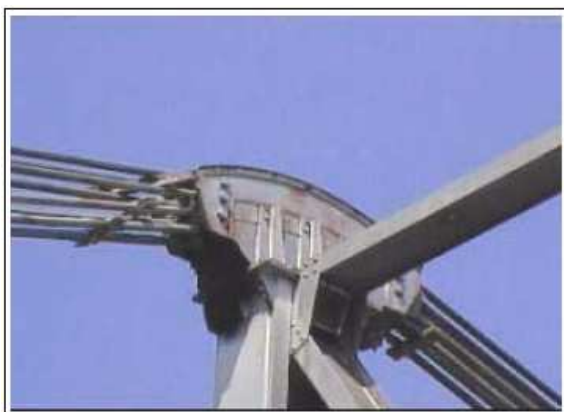
9.9. Detalle del galápago o silla en las columnas de la torre.
