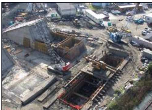
6.55. Detalle del anclaje
