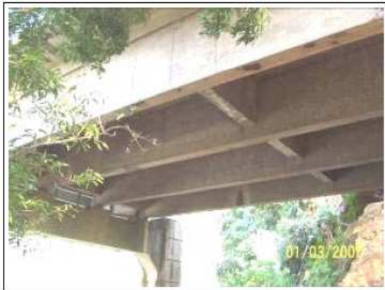
9.11. Vista general del apoyo de la estructura de concreto de uno de los apoyos sobre la pila.
