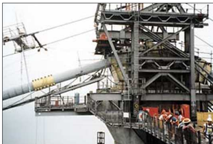
6.39. Cable principal a través de la silla en la cima de la torre.
