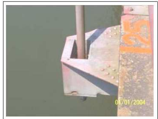
9.8. Detalle del apoyo del pendolón en la viga longitudinal
