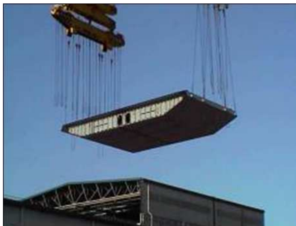
6.56. Detalle de la viga cajón.
