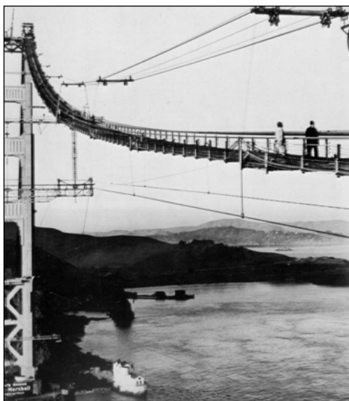
6.34. Levantamiento de los cables
