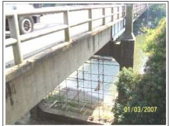
9.14. Vista inferior del tablero en uno de los apoyos de concreto reforzado.
