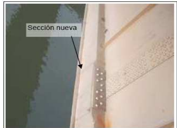
9.16. Viga longitudinal reforzada con sección en cajón.
