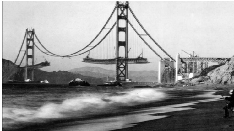
6.35. Puente Golden Gate en construcción.
