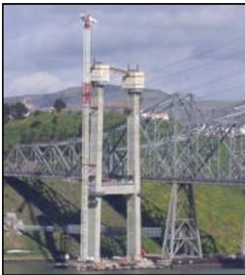
6.52. Construcción de la torre
