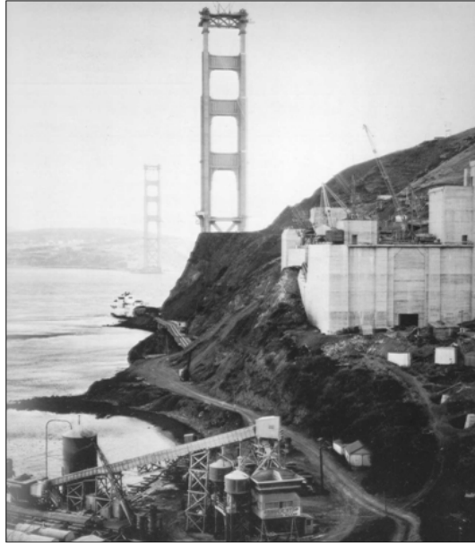
6.24. Construcción de las torres
