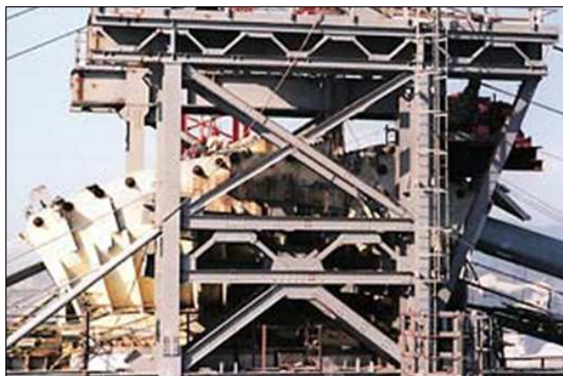
6.40. Vista cercana de la silla que mantiene el cable en posición curva.
