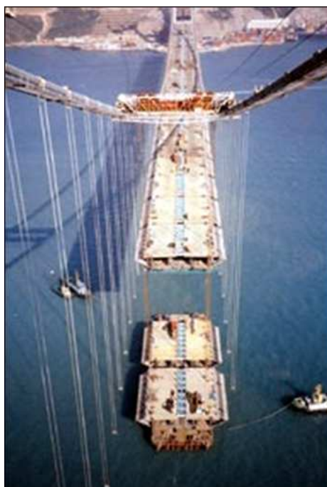
6.42. El dispositivo de elevación visto desde la torre del puente
