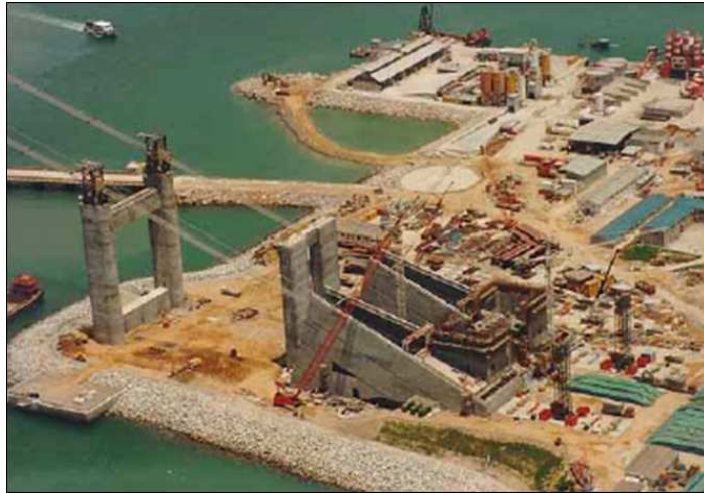
6.36. Anclaje en construcción.
