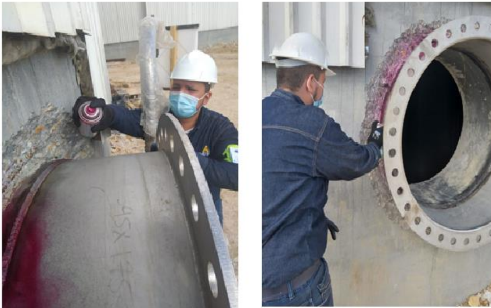
Ilustración 6: Aplicación de líquidos penetrantes
