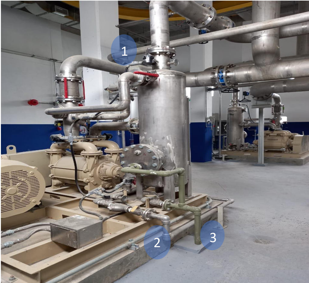
Ilustración 9: Montaje tubería para compresores de biogás
