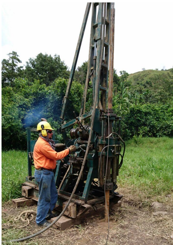
Figura 13. Trabajos de perforación en PP1-21
