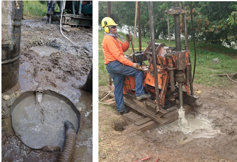
Figura 6. Lodos preparados y retorno durante la perforación.
