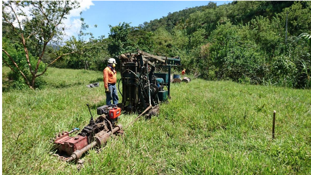
Figura 4. Trabajos de traslado de equipos
