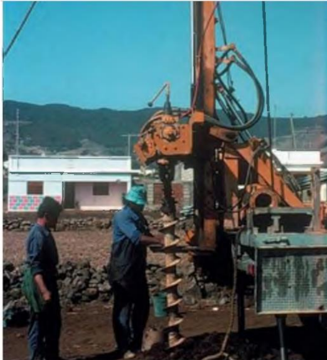
Figura 17. Sondeo Helicoidal
