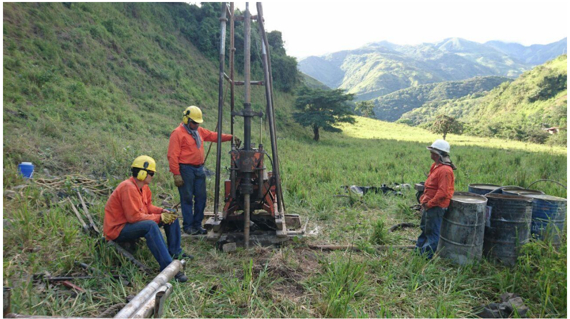
Figura 12. Trabajos de perforación en PZ1-20PC
