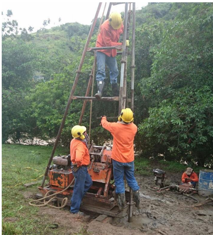
Figura 11. Trabajos de perforación en PP1-59NV
