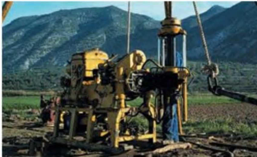
Figura 16. Sondeo a Rotación, equipo ligero sobre patines
