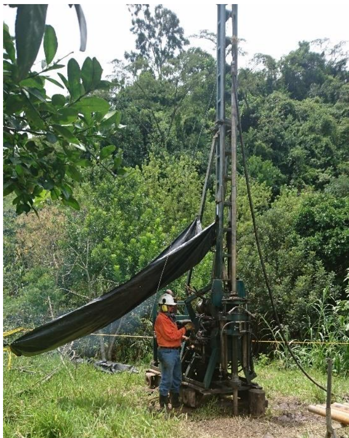
Figura 14. Trabajos de perforación en PP1-20
