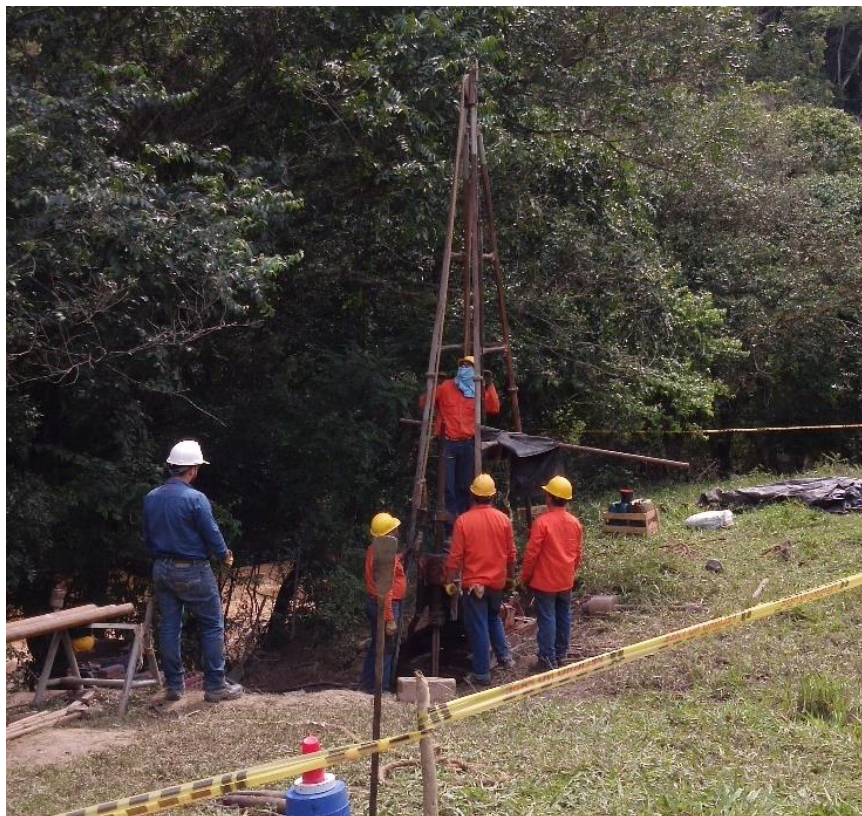
Figura 10. Trabajos de perforación en PP1-47
