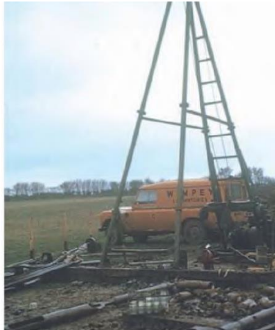
Figura 18. Sondeo a percusión, cuchara y trepado en primer plato
