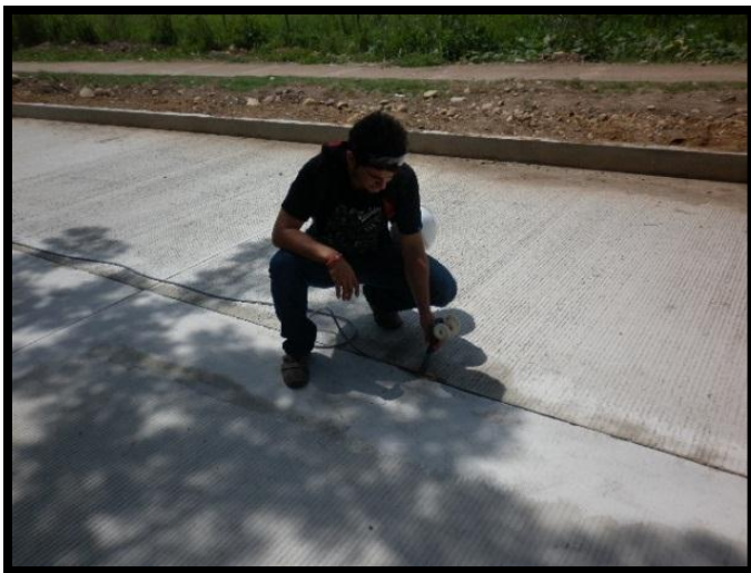
Fg29. Introducción del cordón de respaldo
