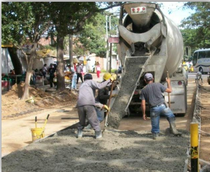
Fg11. Descargando concreto de la mixer
