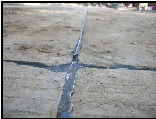
Fg30. sikaflex® pro-2HP ya instalada
