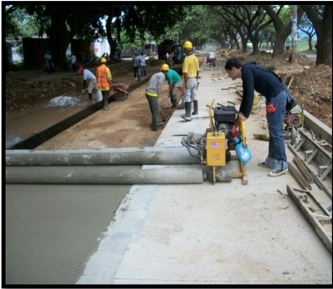
fg13. Extendiendo el concreto con el rodillo vibratorio
