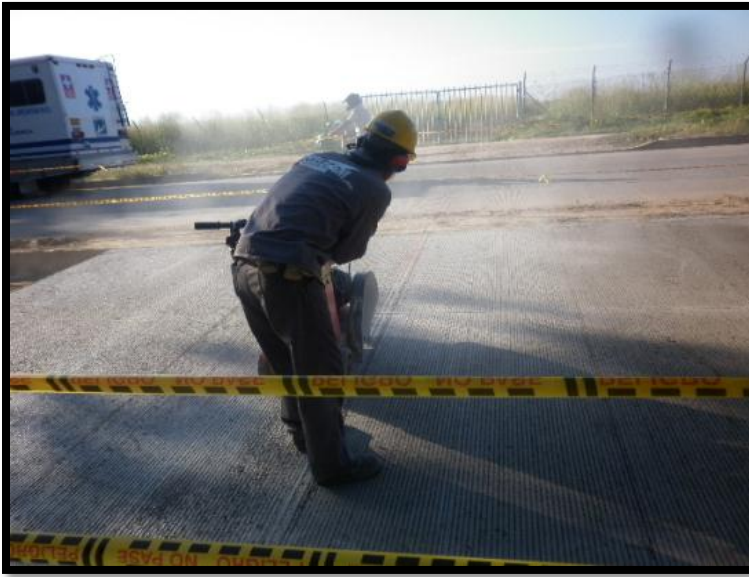
fg26. Corte superficial de concreto en un intersección
