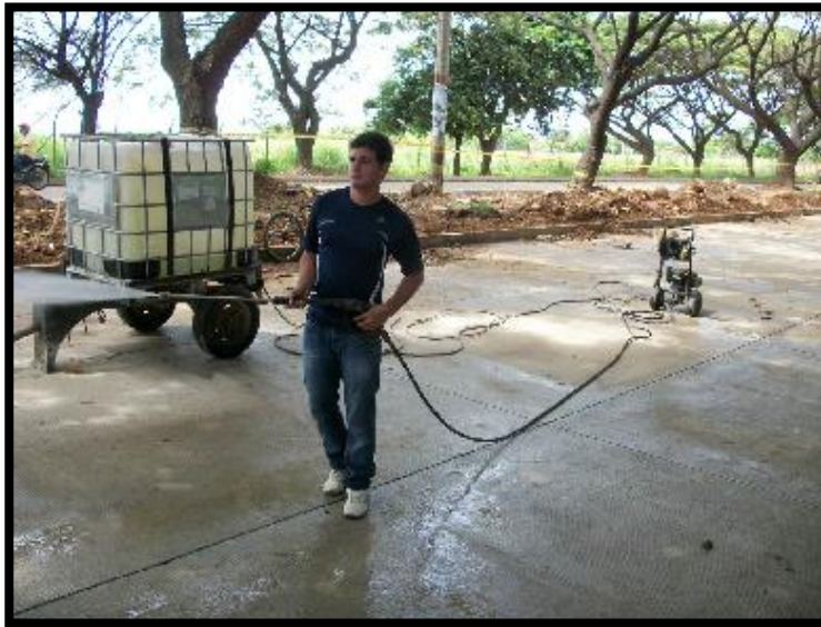
Fg28. Lavado de las juntas con la hidrolavadora
