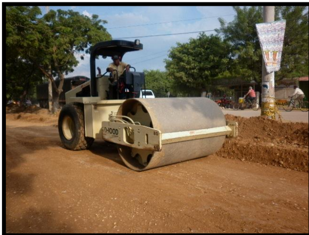
Fg2. Compactación de la sub base por medio del vibro compactador
