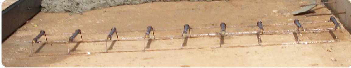
Fg7. Canastilla anclada a la sub base y lista para fundir el concreto
