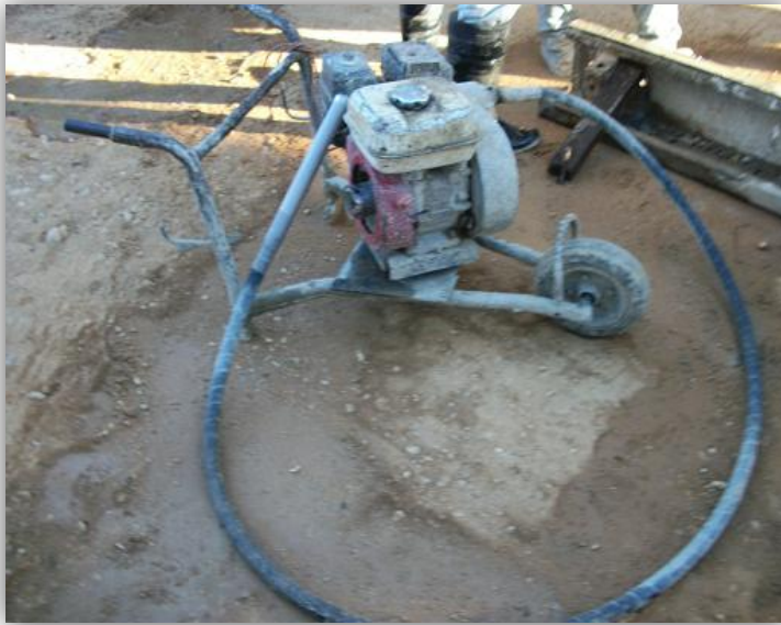
Fg10. Vibrador de la obra
