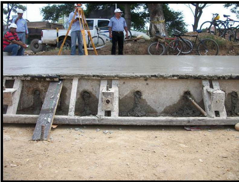
Fg6. formaleta acuñada por un listón de madera
