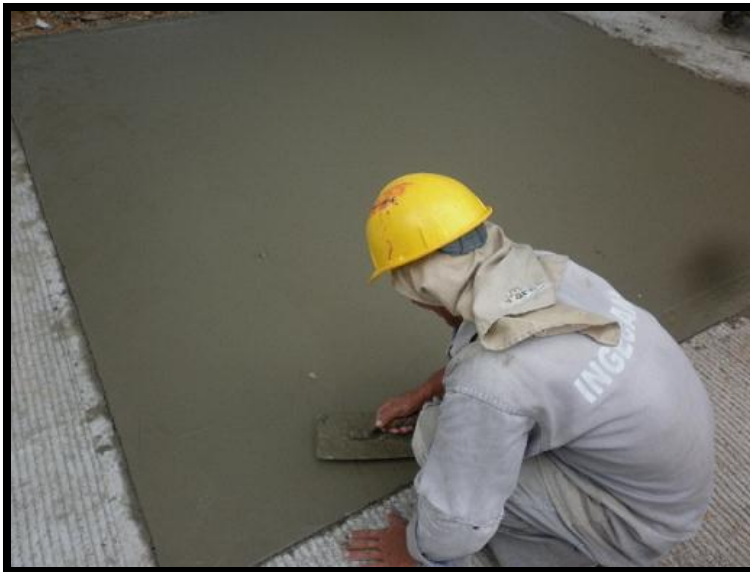
Fg17. Puliendo el borde de la losa con una llana
