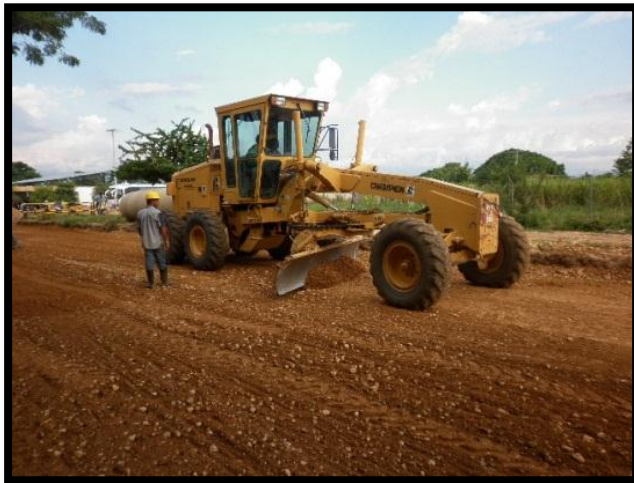
Fg1. Nivelación de la sub base con la motoniveladora
