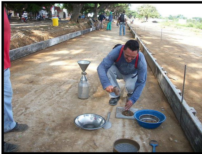
Fg4. Toma de densidades por un laboratorista de OM ingenieros
