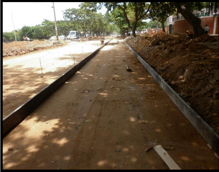
fg5.Instalación de formaleta para fundida de pavimento
