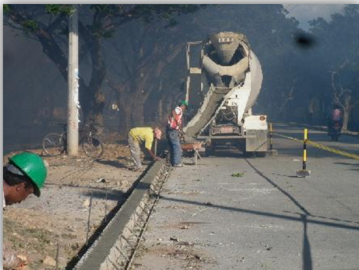
Fg33. Mixer descargando concreto para bordillo
