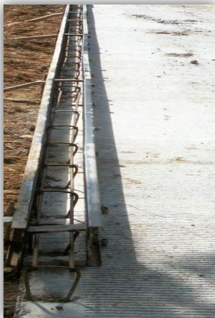
fg32. Instalación de formaleta para bordillo
