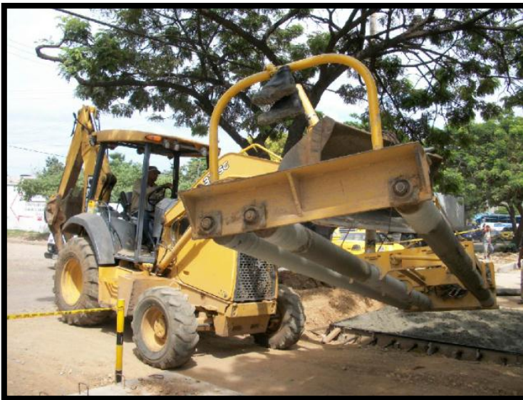
Fg14. Transporte del rodillo vibratorio por medio de la retroexcavadora
