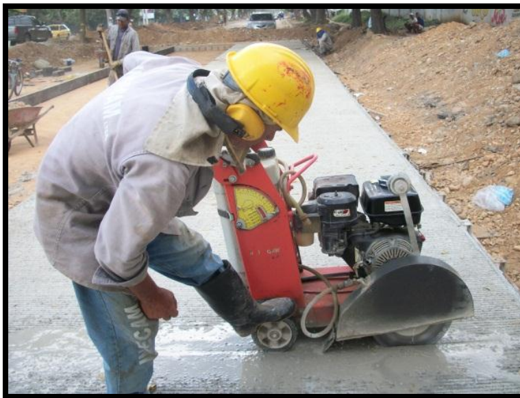
fg27. Se puede apreciar la lechada del concreto producida por el corte
