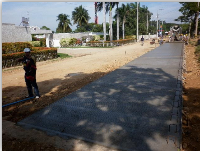
Fg25. Losas moduladas cada 3,5 m longitudinalmente
