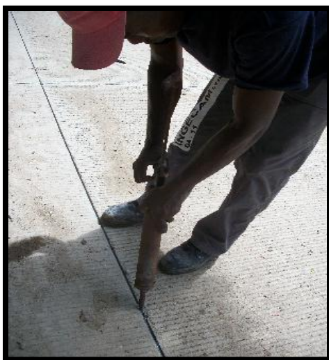
Fg31. Insertando el sellador con una pistola de silicona
