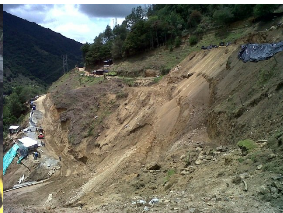
Imagen 2. Construccion del tunel
