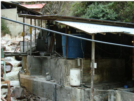
Imagen 10. Sistema de cianuración
