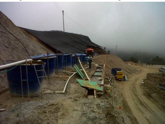
Imagen 6. Tratamiento de aguas acidas
