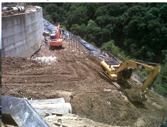
Imagen 4. Obras en túnel
