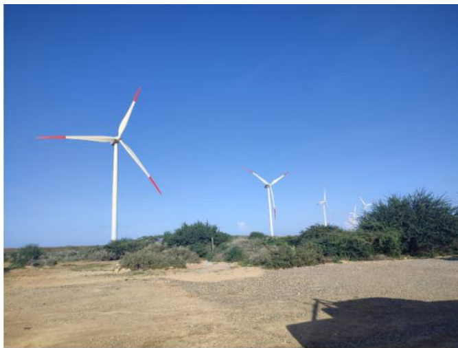
Figura 3. Aerogeneradores en un parque eólico de La Guajira.
