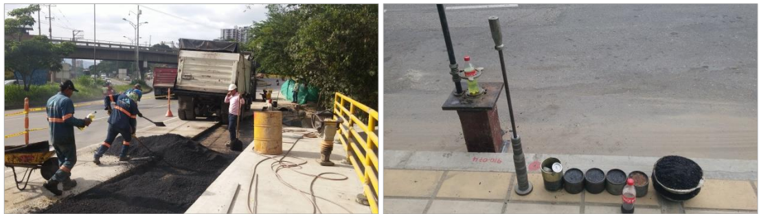
Fig. 10: Toma de muestra y briquetas (asfalto).
