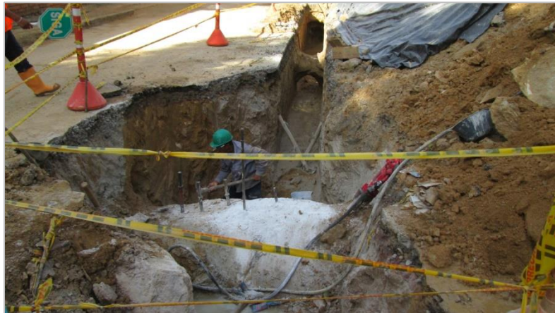
Fig. 12: Roca en excavación de alcantarillado.
