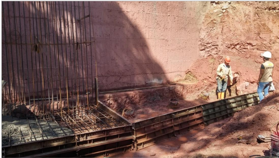
Fig. 11: Elaboración de micropilotes y zapatas.
