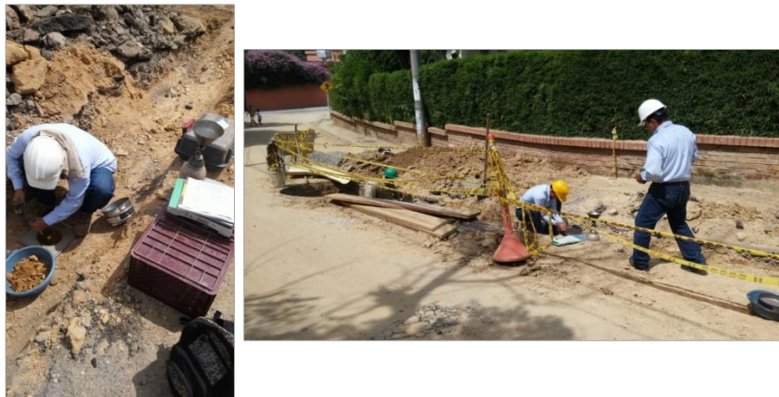
Fig. 9: Toma de densidades a material de relleno.
