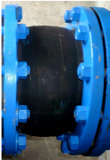
FIGURA 31: JUNTA ELÁSTICA BRIDADA
