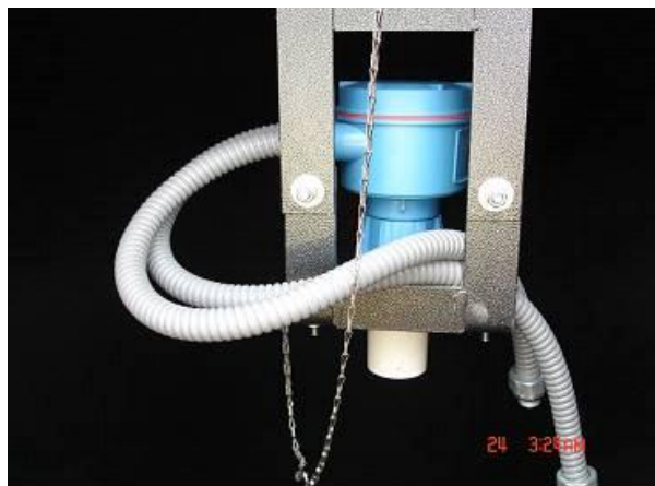
FIGURA 52: SENSOR DE NIVEL LA CUMBRE
