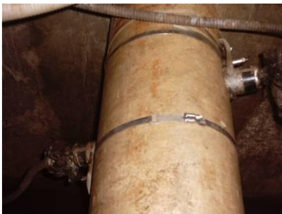
FIGURA 38: SONDAS DE CAUDAL
