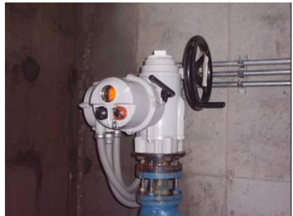
FIGURA 23: MONTAJE REAL VÁLVULA
