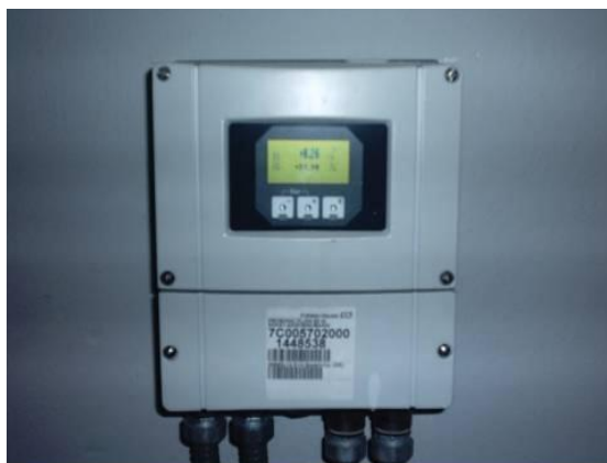
FIGURA39: TRANSMISOR DE CAUDAL
