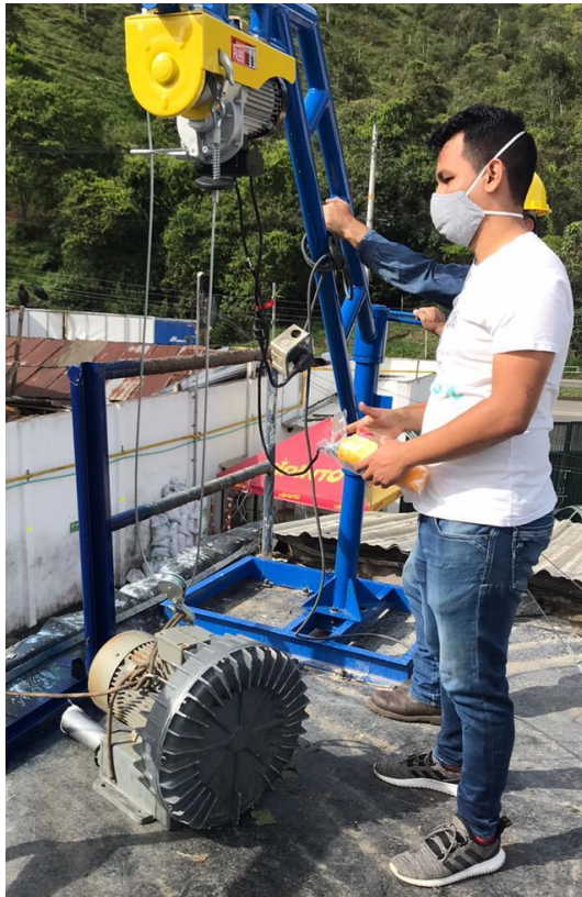
Figura 17. Prueba de carga para la grúa de AVINSA.
