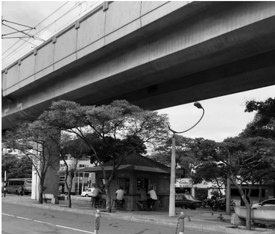
Figura 9. Av. Bolívar, Viaducto del Metro
