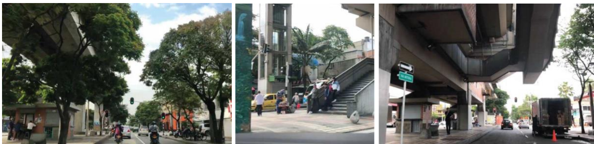
Figura 54. Viaducto del Metro
