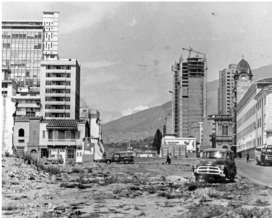
Figura 31. Avenida Oriental en construcción 1972
