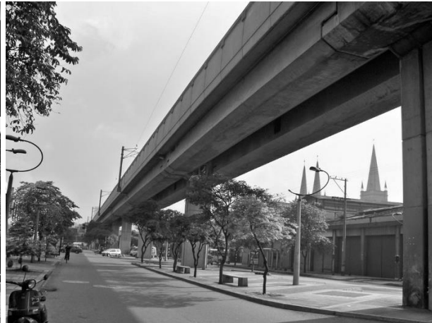
Figura 10. Av. Bolívar, Viaducto del Metro
