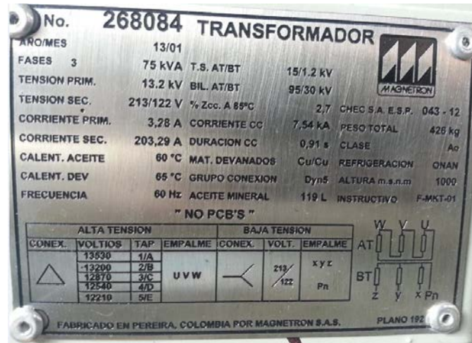
Figura 57 Datos de placa del transformador de tensión trifásico.
