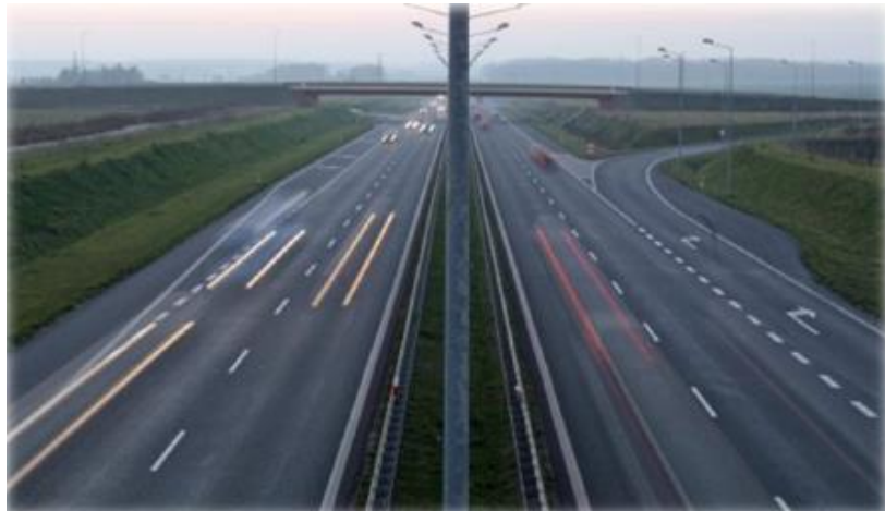
Figura 59 Eliminación de peligros-lado conductor.
