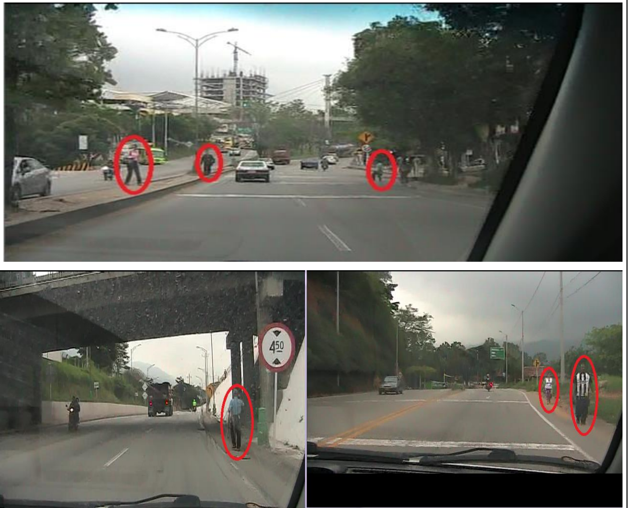
Figura 102 Deficiencia en zonas peatonales
