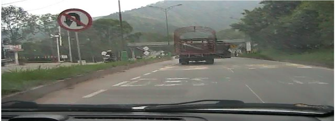
Figura 104 Inadecuada señalización horizontal - deficiente demarcación en el pavimento.
