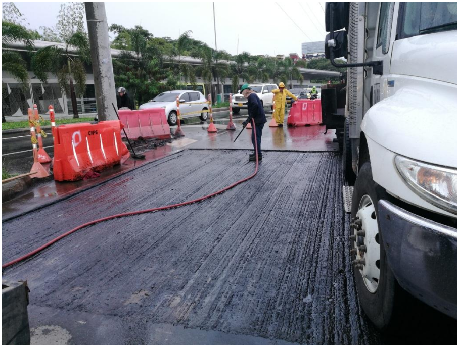
Figura 30. Secado de superficie mojada. Elaboración propia
