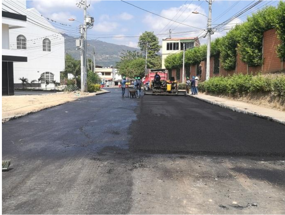
Figura 8. Extensión de la mezcla tipo MDC-10 (San Jorge). Elaboración propia.
