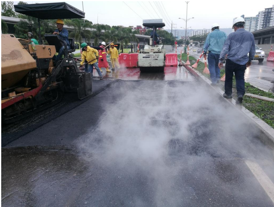
Figura 29. Extensión de la mezcla bajo lluvia. Elaboración propia.
