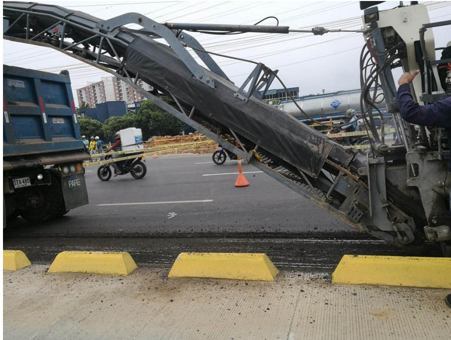
Figura 43. Fresado de pavimento asfáltico. Elaboración propia.
