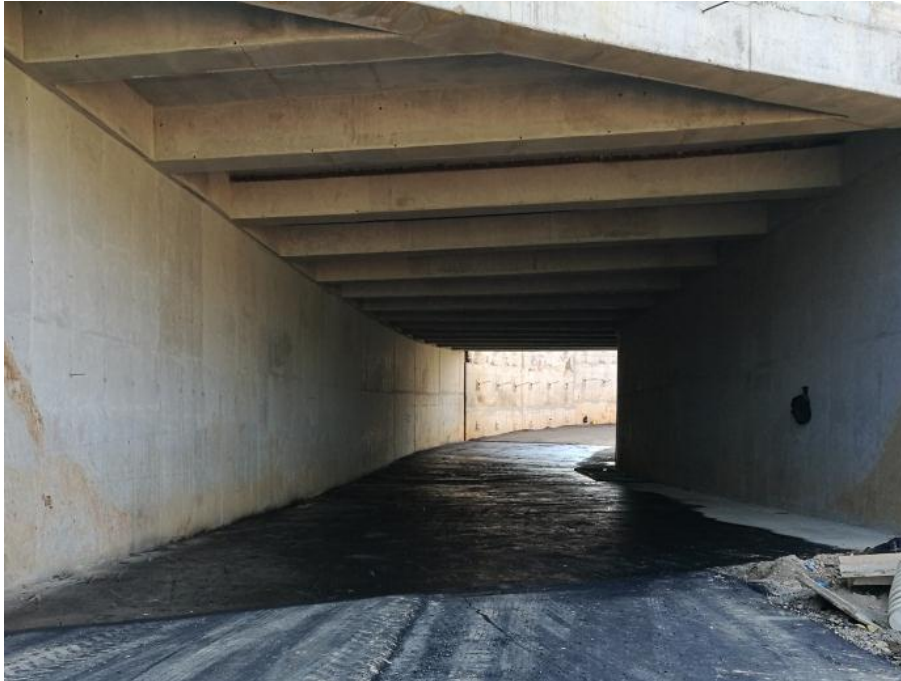
Figura 16. Superficie con riego de liga en deprimido (Tercer Carril). Elaboración propia.
