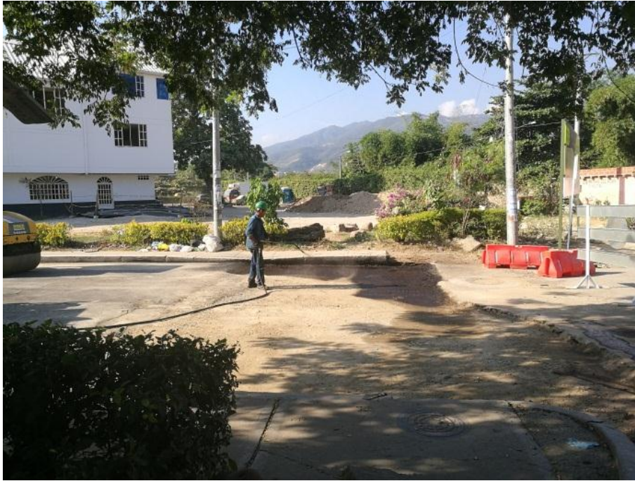
Figura 6. Riego de imprimación asfáltica (San Jorge). Elaboración propia.
