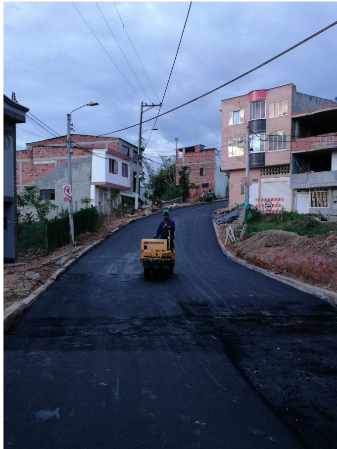
Figura 41. Compactación con compactador de neumáticos. Elaboración propia.
