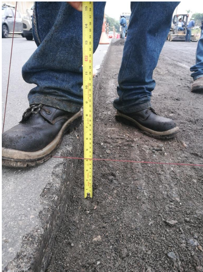
Figura 45. Medición de espesores de fresado. Elaboración propia.
