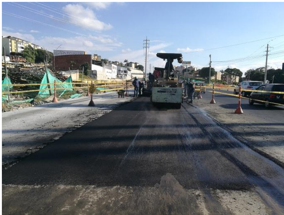
Figura 14. Compactación de la mezcla en Autopista Bucaramanga-Floridablanca (Tercer Carril). Elaboración propia.
