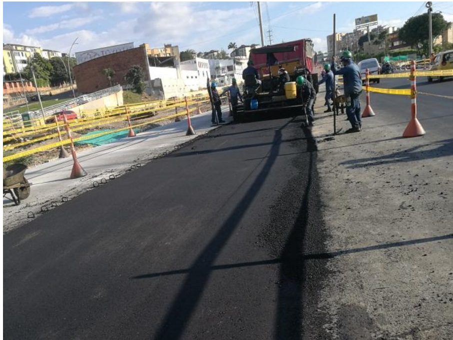
Figura 13. Extensión de la mezcla MDC-2 con asfalto modificado en Autopista Bucaramanga-Floridablanca (Tercer Carril). Elaboración propia.
