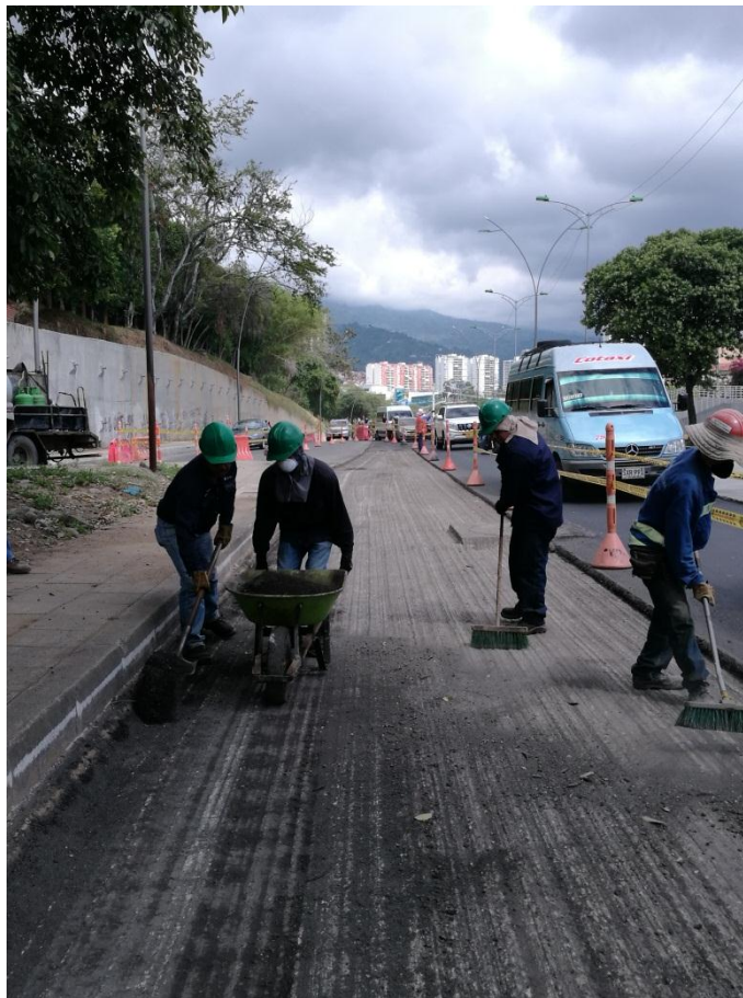
Figura 32. Limpieza de la superficie. Elaboración propia.
