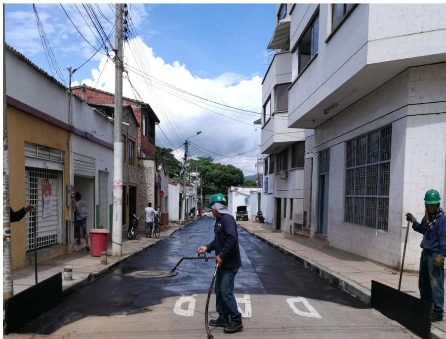
Figura 33. Riego de liga. Elaboración propia.
