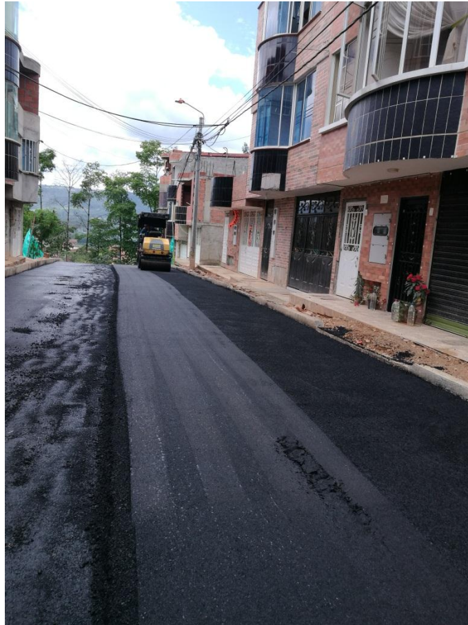
Figura 39. Mezcla desplazada por el compactador vibratorio. Elaboración propia.
