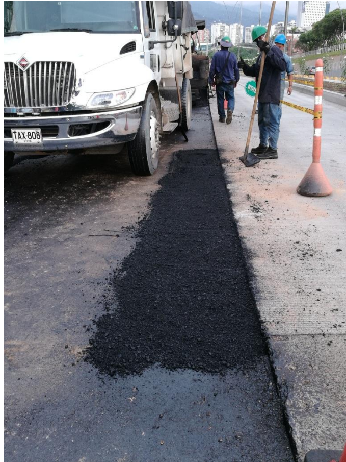
Figura 38. Extensión manual de la mezcla. Elaboración propia.
