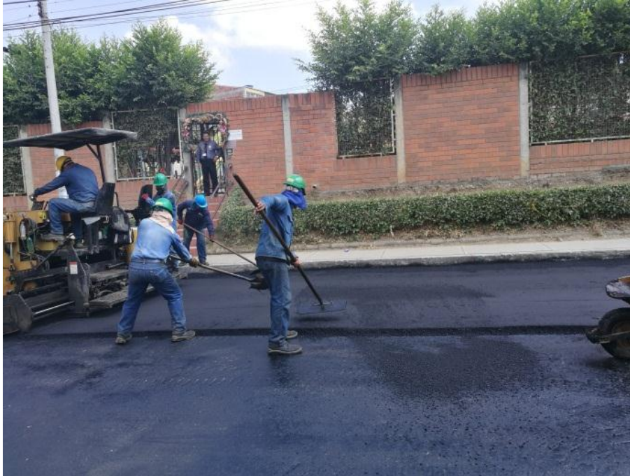
Figura 36. Extensión de la mezcla. Elaboración propia.
