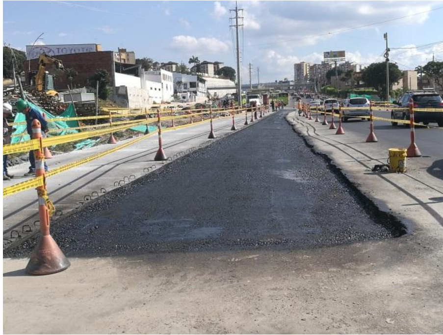
Figura 12. Superficie imprimada en Autopista Bucaramanga-Floridablanca (Tercer Carril).
