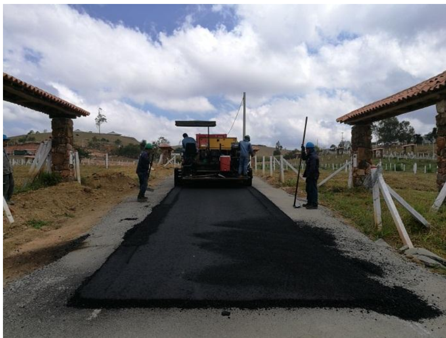
Figura 23. Extensión de la mezcla tipo MDC-2 (Incomesa). Elaboración propia.
