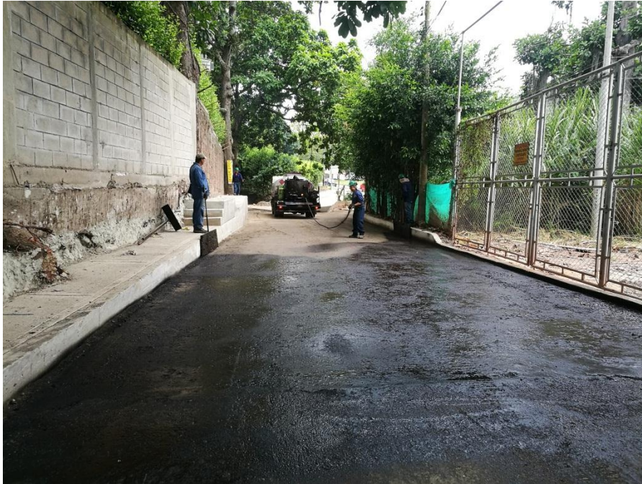
Figura 34. Riego de imprimación. Elaboración propia.
