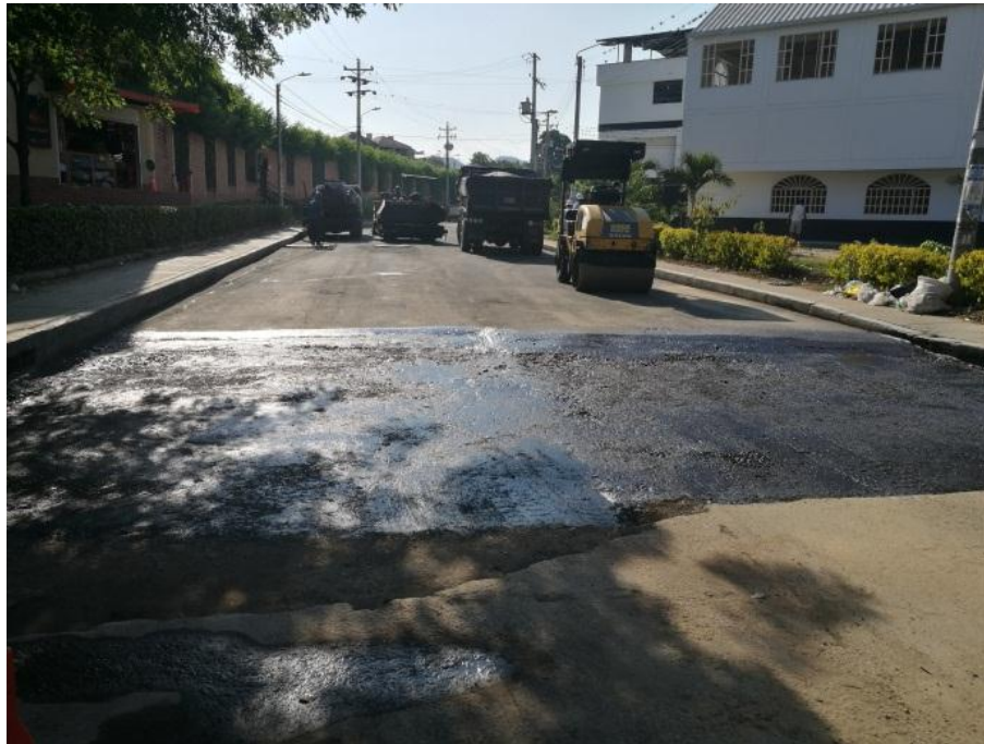
Figura 7. Superficie imprimada (San Jorge). Elaboración propia.
