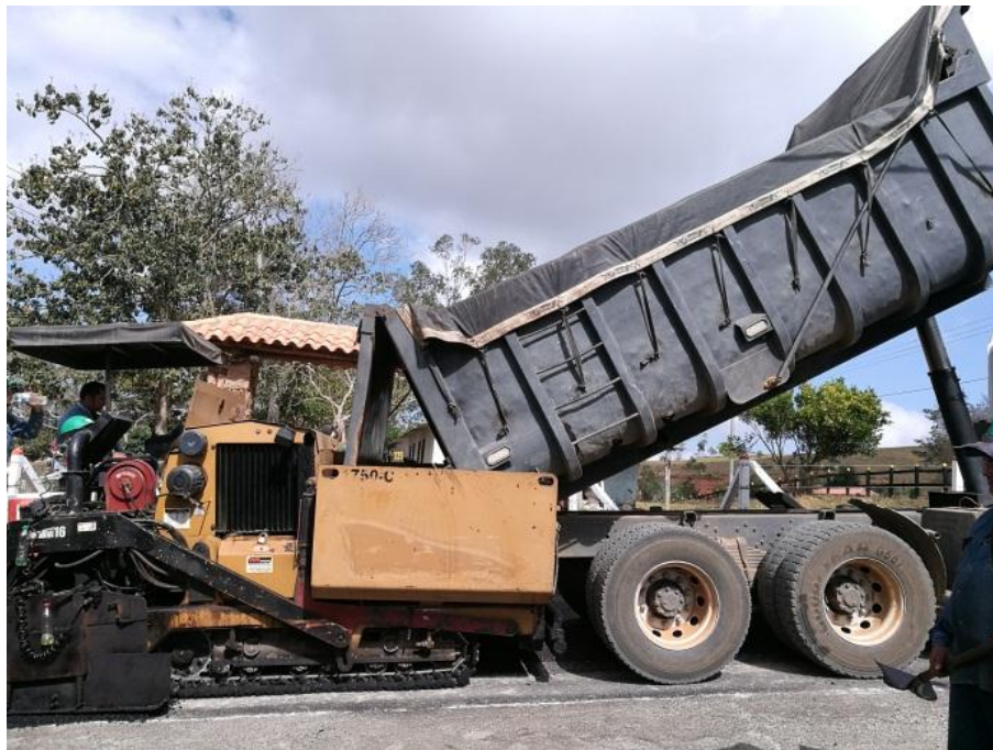
Figura 35. Vertido de mezcla en la tolva pavimentadora. Elaboración propia.
