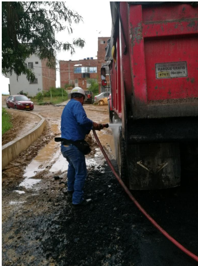
Figura 31. Lavado de las ruedas de volqueta. Elaboración propia
