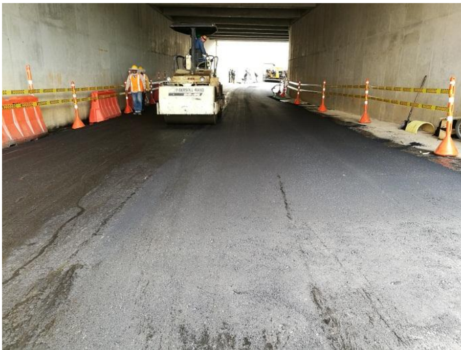
Figura 18. Compactación en depresido (Tercer Carril). Elaboración propia.
