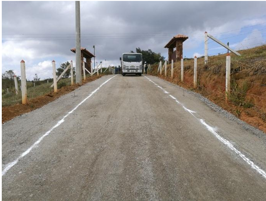
Figura 21. Marcación de la superficie (Incomesa). Elaboración propia.
