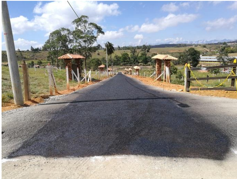
Figura 22 .Superficie imprimada (Incomesa). Elaboración propia.
