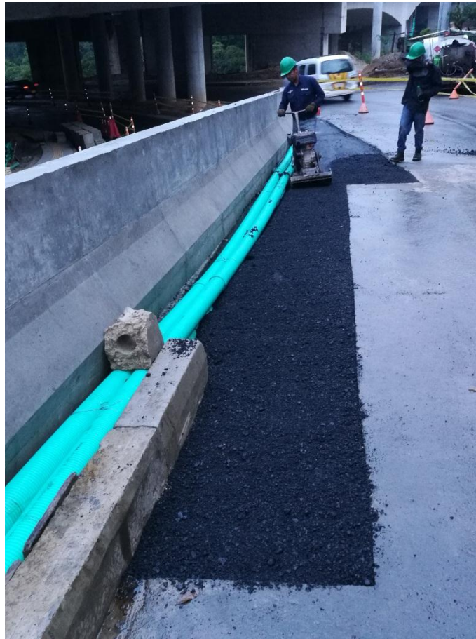
Figura 42. Compactación con “rana”. Elaboración propia.
