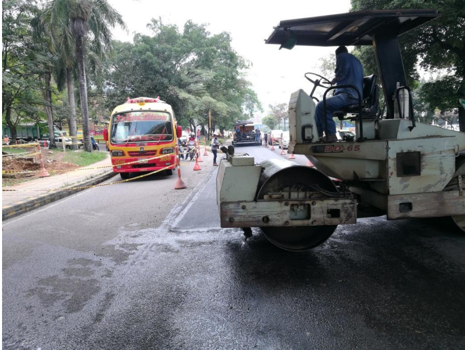
Figura 40. Compactación de junta transversal con compactador vibratorio. Elaboración propia.
