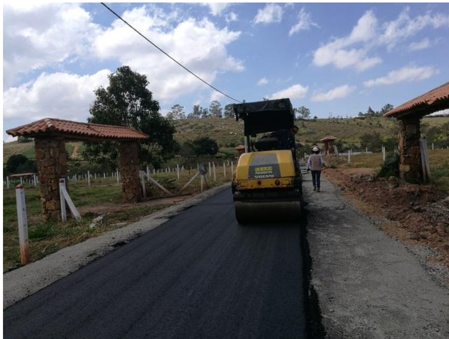
Figura 25 .Compactación de la mezcla (Incomesa). Elaboración propia.
