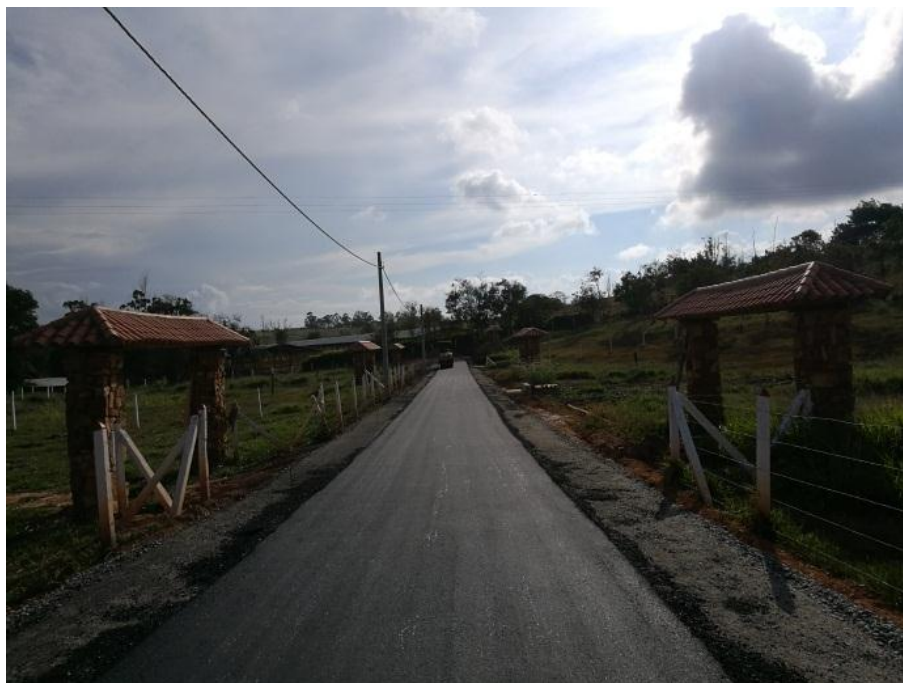
Figura 26. Calle pavimentada (Incomesa). Elaboración propia.
