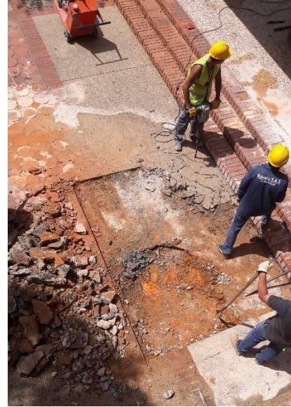
Ilustración 13 - Comienzo de la demolición para el foso del ascensor
