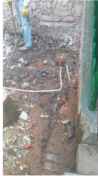
Ilustración 60 - Excavación con encuentro de red hidráulica y red eléctrica
