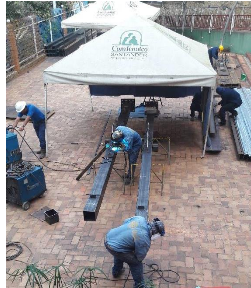
Ilustración 16 - Labores en estructura metálica
