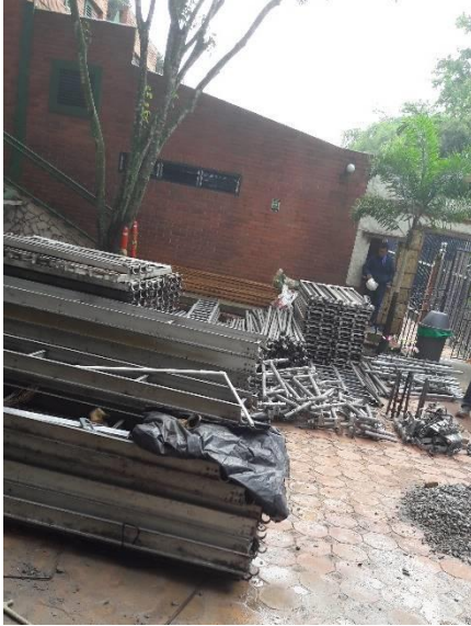
Ilustración 33 - Partes para el armado de andamios
