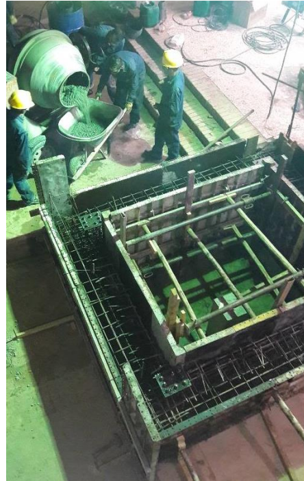
Ilustración 38 - Fundida viga cimentación
