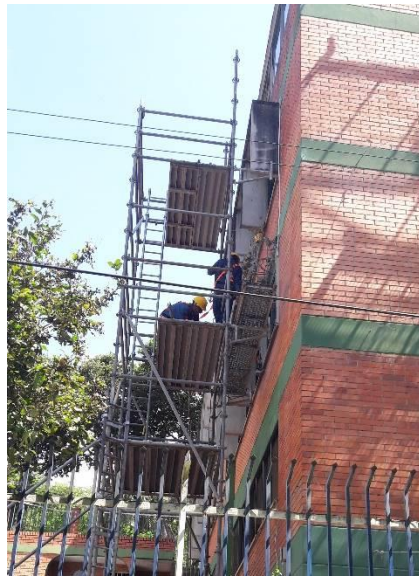
Ilustración 45 - Demolición de corta soles
