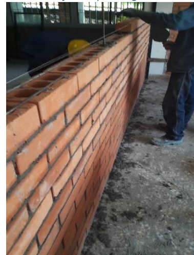
Ilustración 42 - Muro en mampostería reforzada
