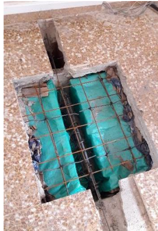
Ilustración 44 - Formaleta para vigueta
