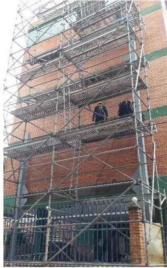
Ilustración 47 - Instalación columnas pórtico
