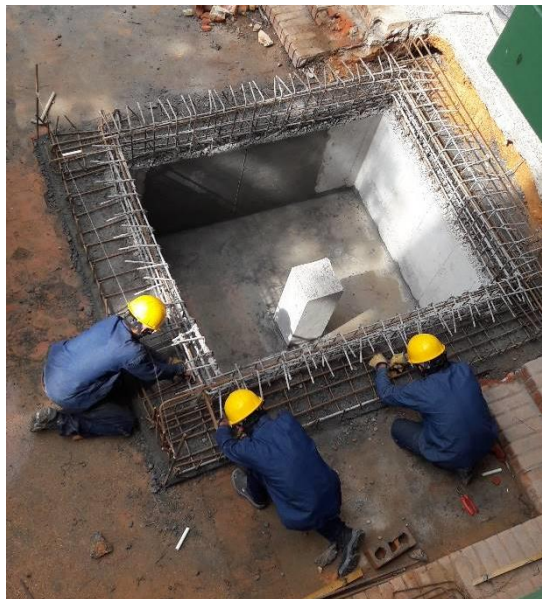
Ilustración 35 - Refuerzo viga cimentación
