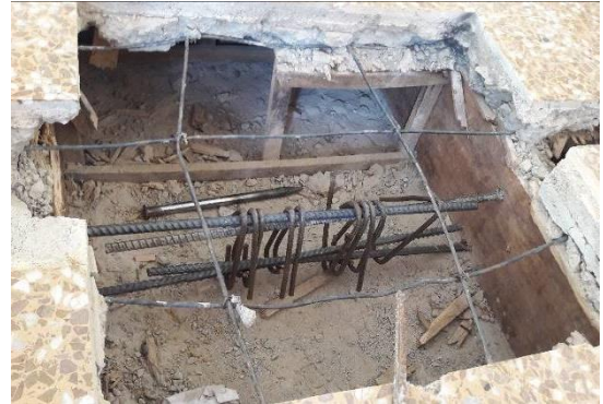
Ilustración 40 - Ubicación refuerzo para viguetas
