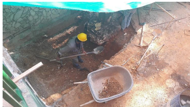
Ilustración 66 - Excavación para cimentación de escalera de emergencia
