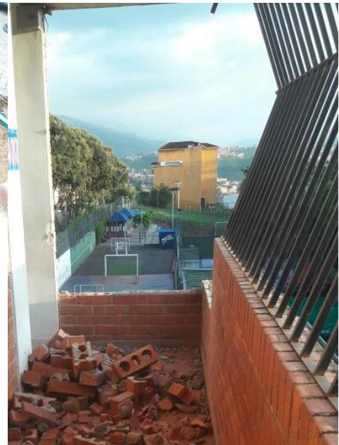
Ilustración 25 - Demolición antepecho para escalera
