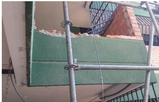
Ilustración 41 - Demolición reja y antepecho para acceso al ascensor
