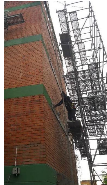
Ilustración 46 - Instalación de platinas
