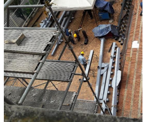
Ilustración 63 - Tubería estructural para pórtico del eje Z
