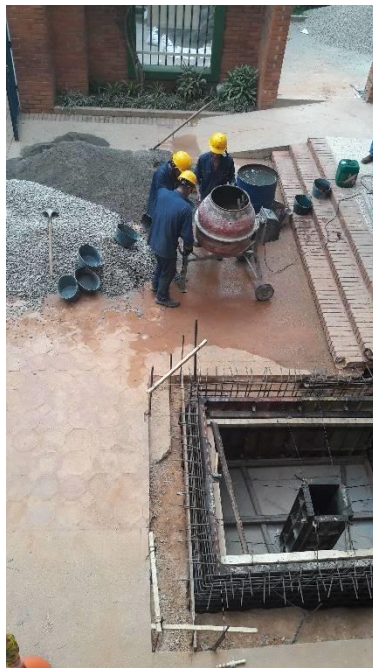
Ilustración 31 - Mezcla con trompo para muros del foso
