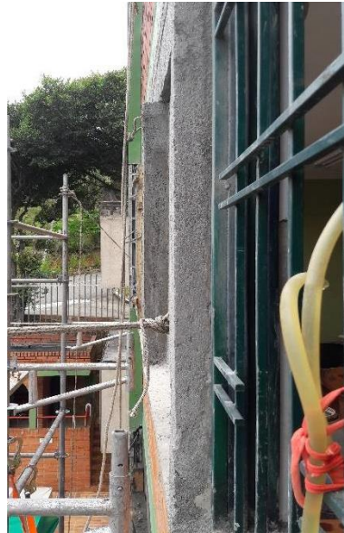
Ilustración 53 - Resanes demolición cortasoles
