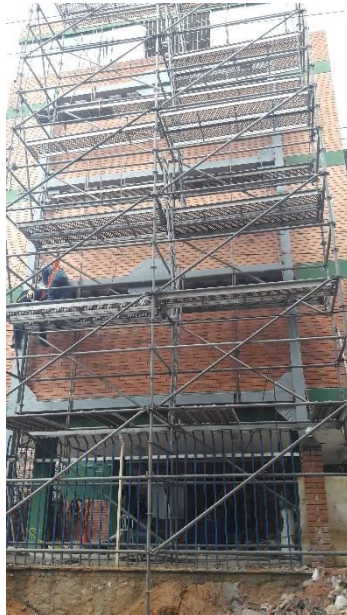
Ilustración 49 - Instalación vigas pórtico
