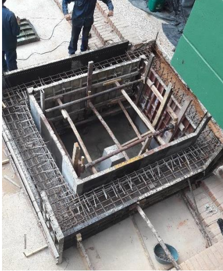
Ilustración 36 - Formaleta para la viga de cimentación
