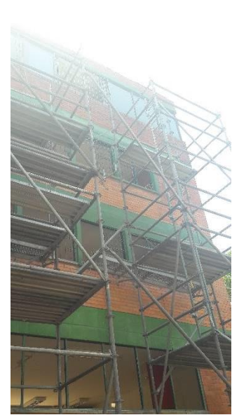
Ilustración 61 - Pintura fachada eje Z
