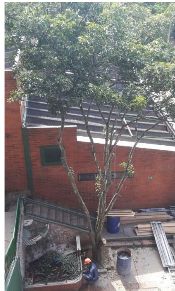
Ilustración 58 - Demolición muro y tala árbol
