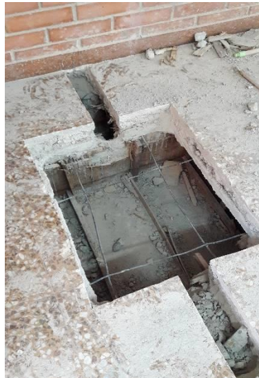
Ilustración 17 - Demolición placa entre piso.
