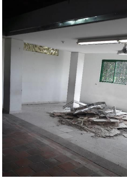
Ilustración 15- Desmante muros en drywall
