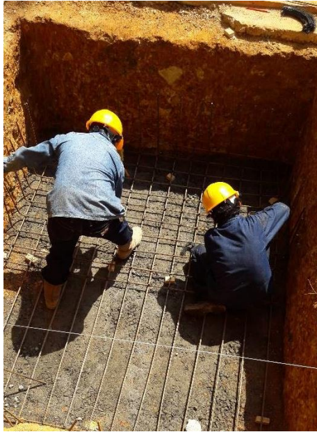
Ilustración 21 - Refuerzo de la placa
