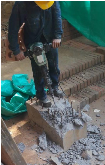
Ilustración 64 - Demolición pedestal
