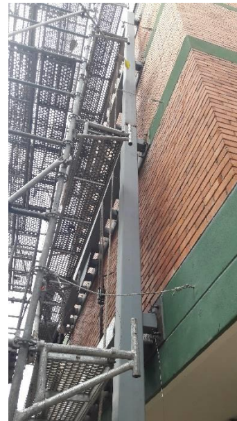
Ilustración 50 - Vigas provisionalmente sujetas con puntos de soldadura
