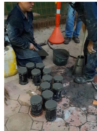
Ilustración 32 - Cilindros de concreto
