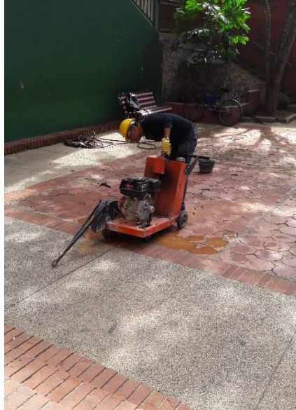
Ilustración 12 - Corte de la sección a escavar
