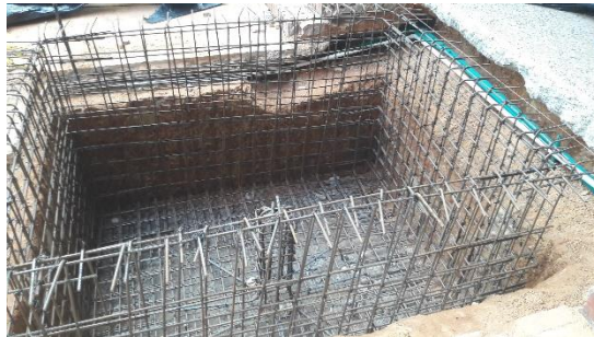
Ilustración 23 - Armado estructura de refuerzo
