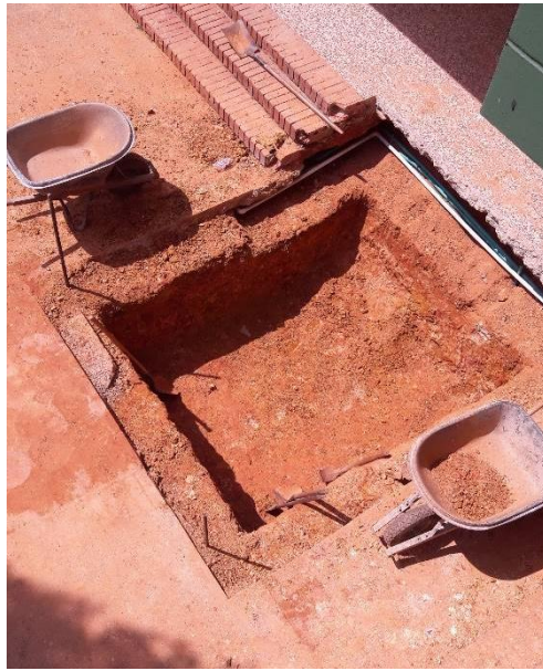
Ilustración 18 - Excavación final del foso
