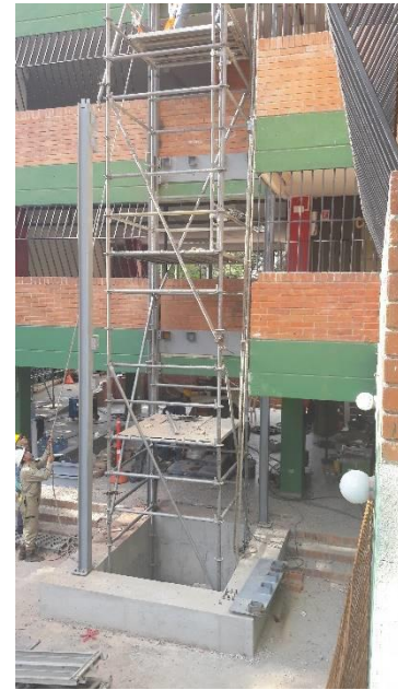
Ilustración 65 - Instalación estructura ascensor
