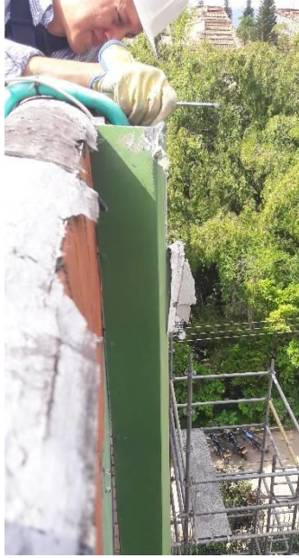
Ilustración 59 - Adecuación bajante red eléctrica
