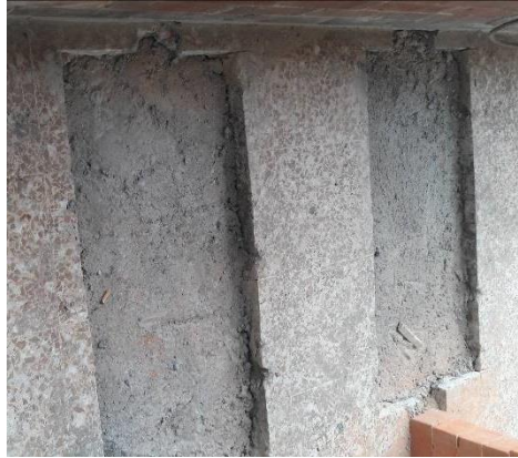
Ilustración 51 - Vigüeta ascensor
