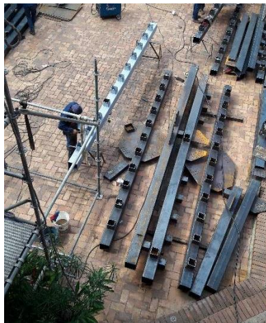
Ilustración 43- Aplicación anticorrosivo
