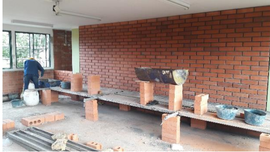
Ilustración 62 - Terminación de mampostería reforzada
