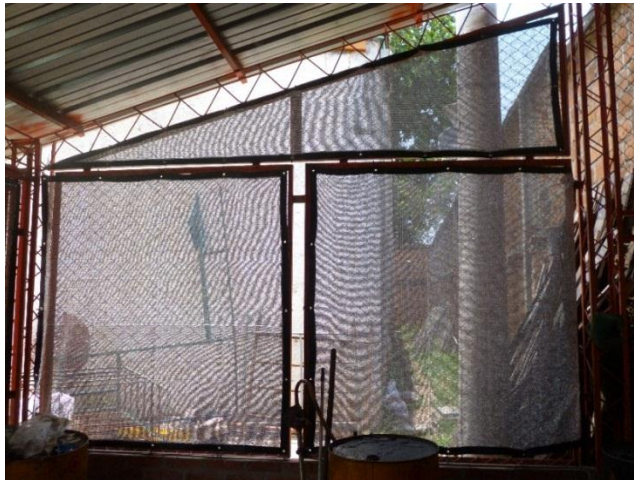
Figura 7. Estado actual de la bodega de RESPEL después de su adecuación.
