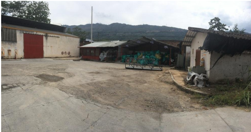
Figura 4. Estado del patio de maniobras posterior a la jornada de limpieza.
