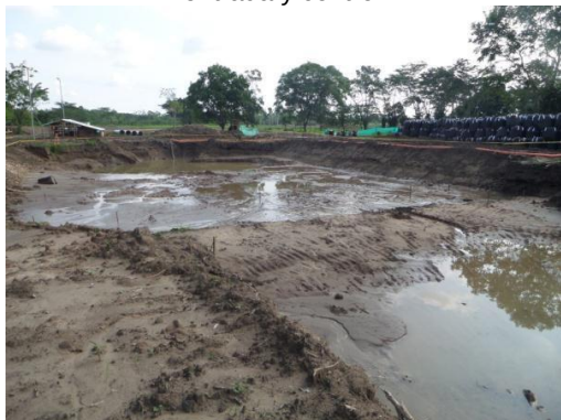
15/11/2014 Figura 30:excavación estructura de entrada y control
