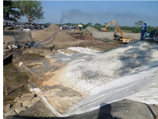
07/01/2014 Figura 35: flexocreto en proceso de curado.
