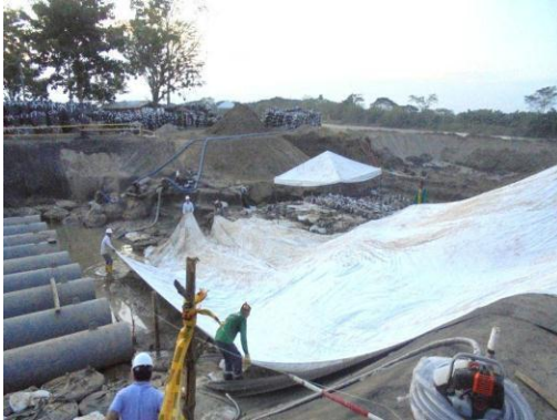
07/01/2014 Figura 34: extensión del flexocreto
