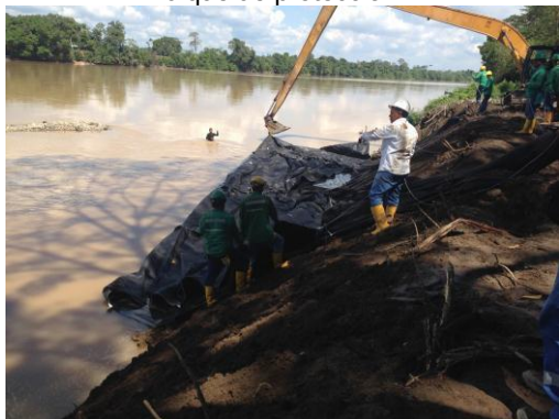
15/12/2014 Figura 19: Abscisas: K0+320/340. Reinician las actividades de excavación y llenado de geoestructuras.
