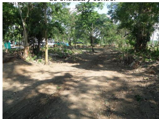
30/09/2014 Figura 27: Rocería estructura de entrada y control
