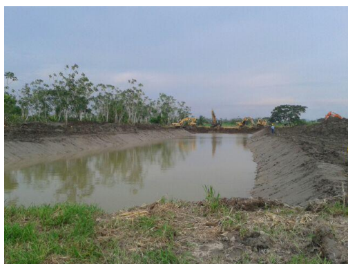
15/09/2014 Figura 42: excavación canal de conexión
