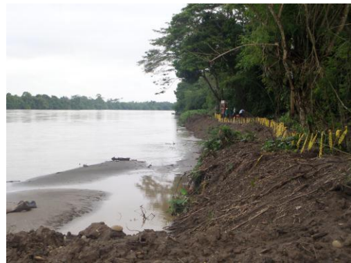
30/11/2014 Figura 18: Abscisas: K0+000/320. Maquinaria y equipos trasladados al frente de Bocatoma
