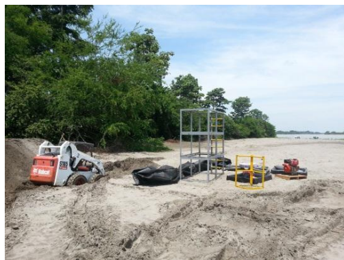
16/07/2014 Figura 9 pruebas de llenado geoestructuras
