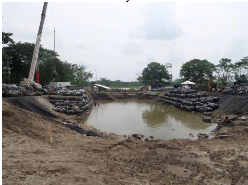
15/12/2014 Figura 32:instalación geobolsas en el fondo de la estructura de entrada y control.
