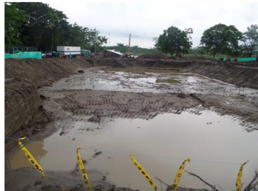
30/10/2014 Figura 29:excavación estructura de entrada y control
