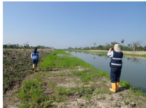
30/12/2014 Figura 49: Jarillón con regeneración vegetal
