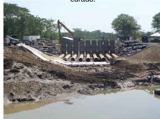
07/01/2014 Figura 37: estructura de entrada y control
