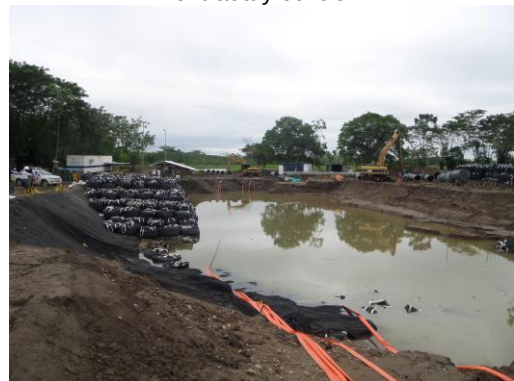
30/11/2014 Figura 31:geobolsas instaladas en la estructura de control.
