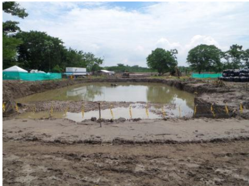
15/10/2014 Figura 28:excavación estructura de entrada y control.
