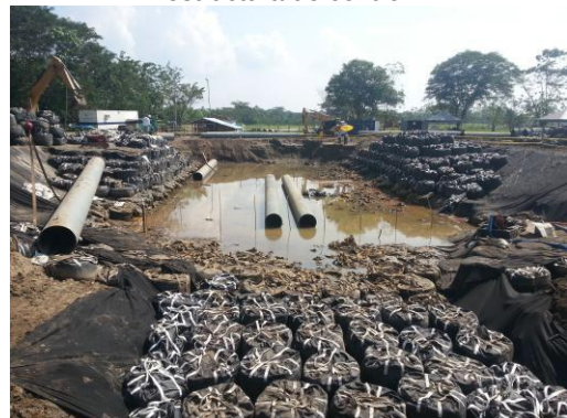
30/12/2014 Figura 33: ubicación de tubería metálica de la estructura de control
