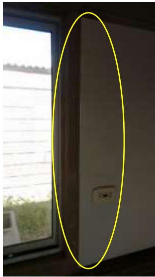
Figura N°23: Emboquillar Cocina casa de construvivienda la jagua, Tomado por ingeniero residente.
