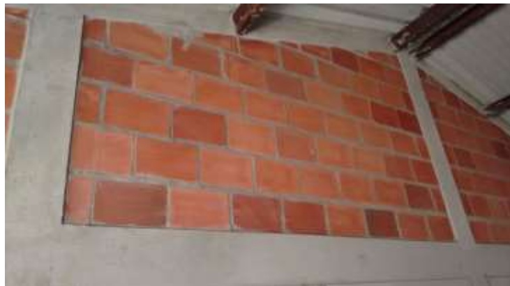
Figura N°25: Brecha de Mampostería en casa de construvivienda la jagua, Tomado por ingeniero residente.
