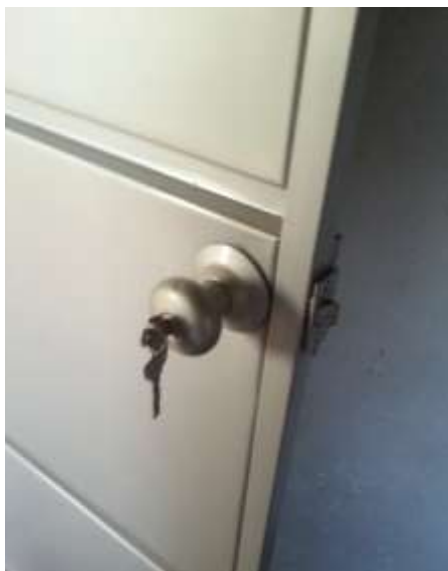
Figura N°26: Chapa de Puerta en casa de construvivienda la jagua, Tomado por autor.
