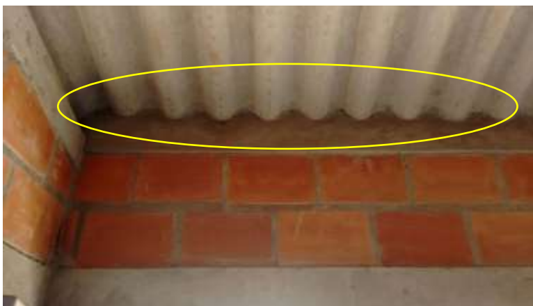
Figura N°22: Encoroce Viga Cinta de casa de construvivienda la jagua, Tomado por ingeniero residente.
