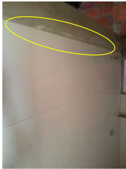
Figura N°24: Emboquillar Baño casa de construvivienda la jagua, Tomado por ingeniero residente.
