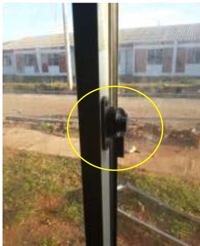
Figura N°21: Ventana de casa de construvivienda la jagua, Tomado por ingeniero residente.
