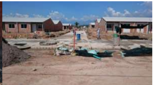
Figura N°16: Vista de construcción de viviendas y urbanismo.
