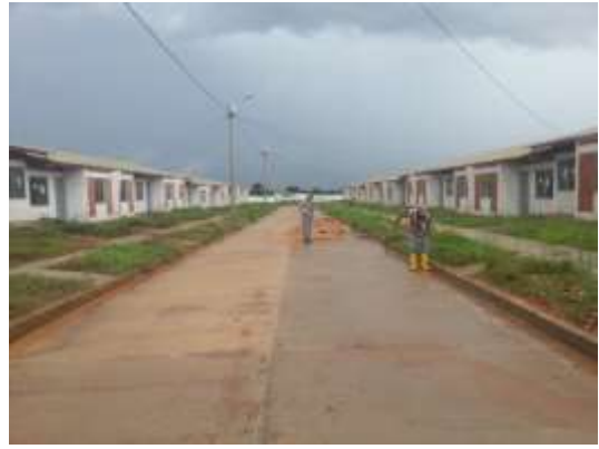
Figura N°34: vía de la manzana 4 jornadas de limpieza, tomada por autor.
