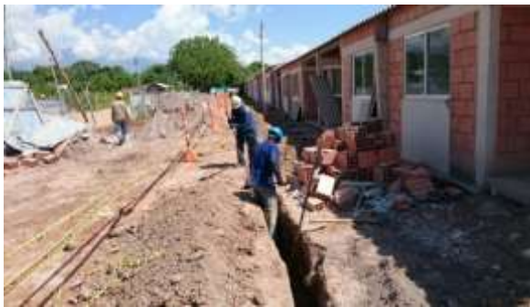
Figura N°15: Instalación de redes, inicios de obra
