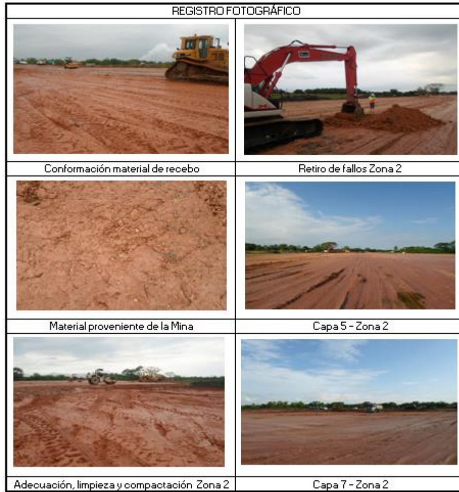
Figura 17. Registro fotográfico de actividades en obra Fuente: Informe Semanal de Actividades
