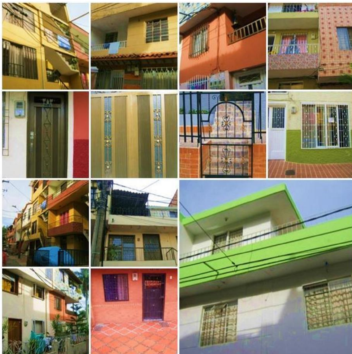
Modernización de las viviendas expresadas en las Fachadas- Fuente: collage elaborado por Luz Adriana Bermúdez C, Enero 26 de 2013
