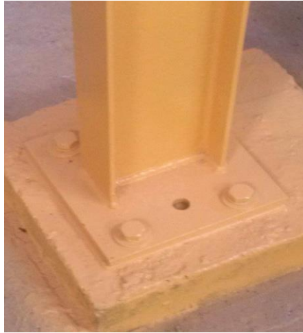
11) Empotramiento de la columna. Fuente autor.
