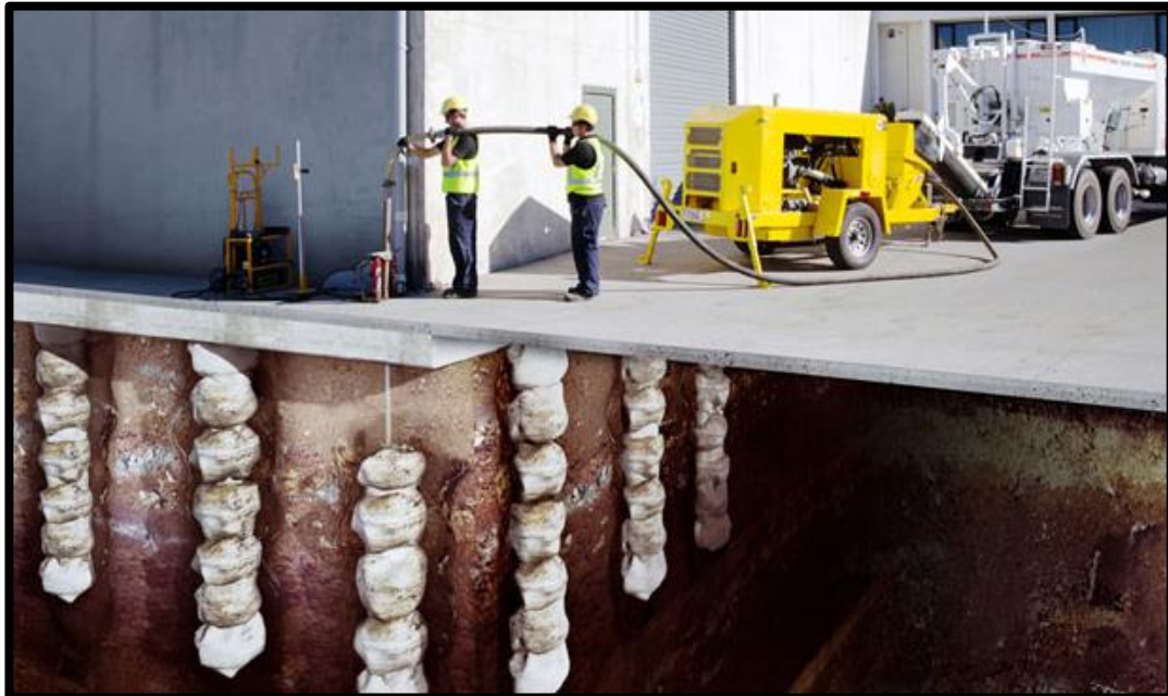
Gráfica 8. Proceso de construcción de Inyecciones con Mortero Duro
