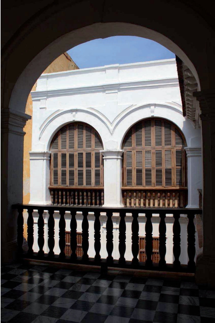
Balcones en construcción colonial. Foto: María Cecilia Pérez B.
