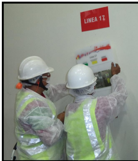
Figura. 82 Instalación Bolsillo Línea 17 Agua Brisa
