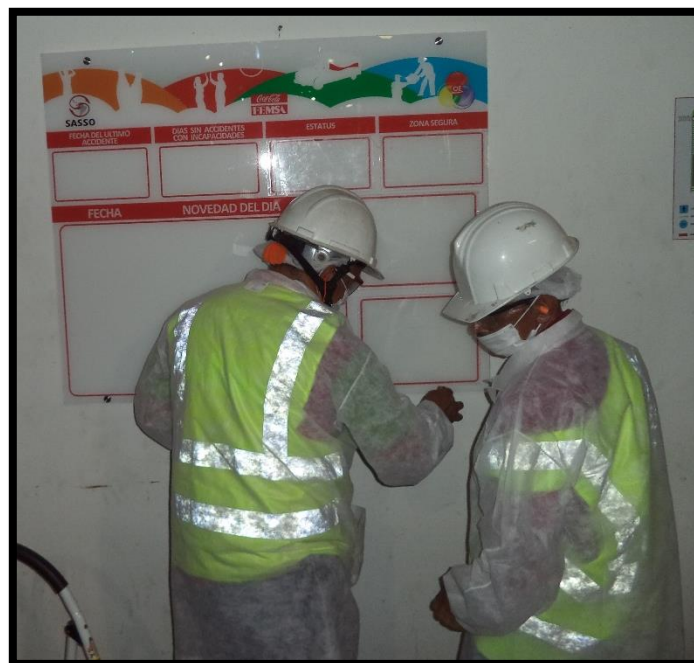
Figura. 86 Instalación tablero de control área de limpieza línea dos Coca Cola FEMSA Bucaramanga
