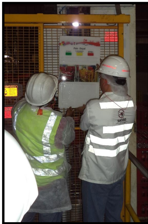
Figura. 76 Instalación bolsillo Pale-Depaletizado línea 2 embotellado
