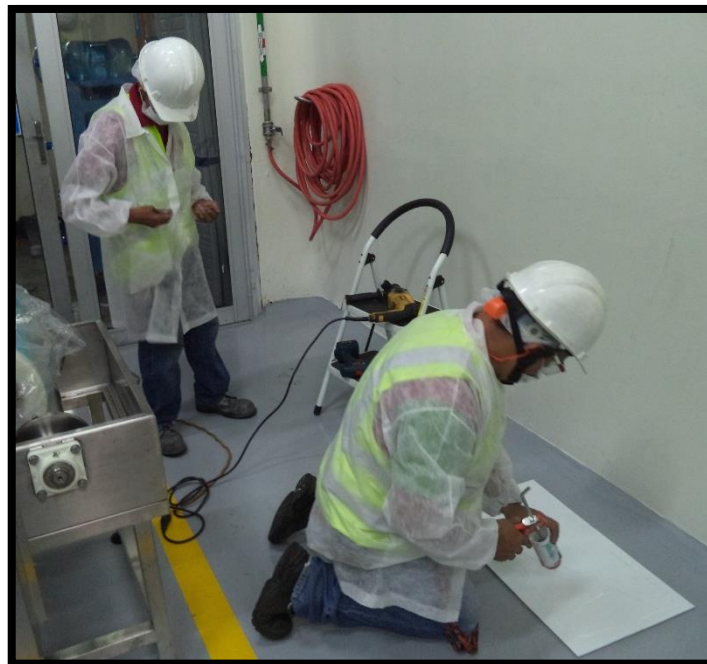
Figura. 80 Instalación Bolsillo Línea 14 Agua Brisa
