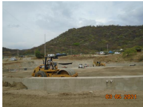
Figura 10 - Relleno y compactación Fuente: Elaboración propia
