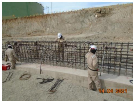
Figura 8 – Armado acero pedestal
