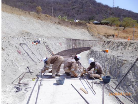
Figura 6 – Armado de acero zapata
