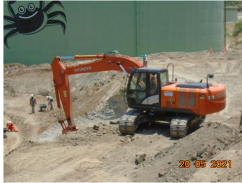
Figura 11 – Excavación para dique Fuente: Elaboración propia
