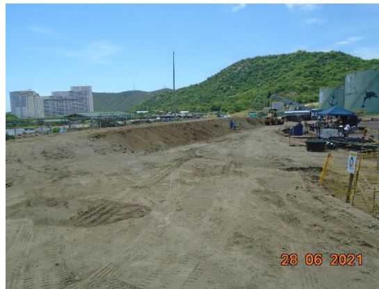
Figura 12 – Conformación de dique Fuente: Elaboración propia
