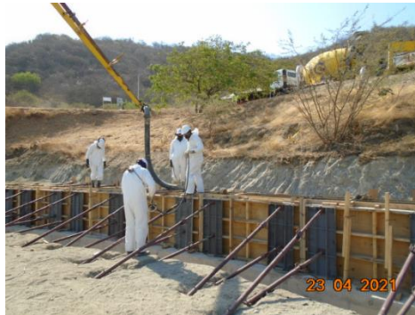
Figura 9 – Vaciado pedestal Fuente: Elaboración propia
