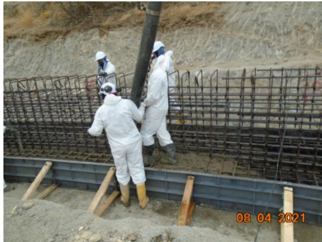
Figura 7 – Vaciado zapata
