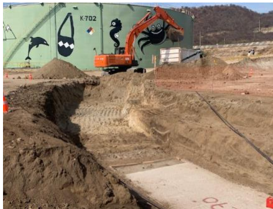
Figura 5 – Aplicación de solado
