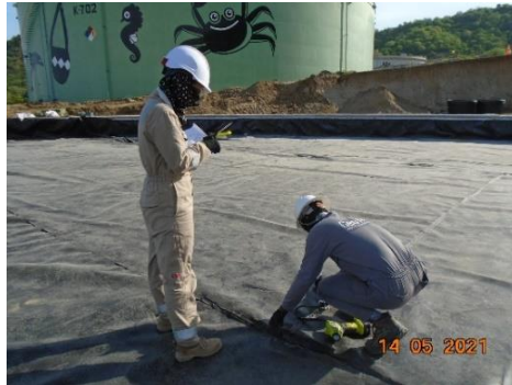
Figura 19 – Ensayo de aire y cámara
