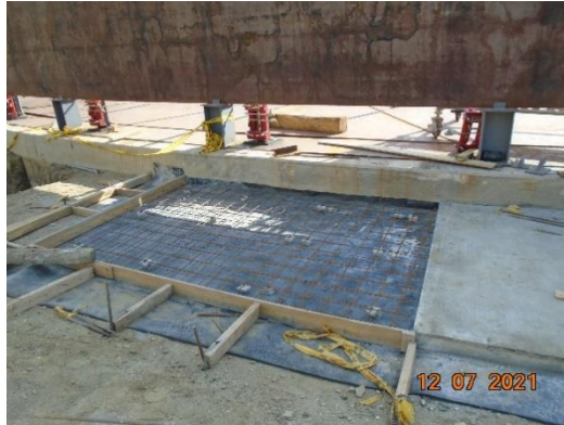
Figura 14 – construcción andén perimetral Fuente: Elaboración propia
