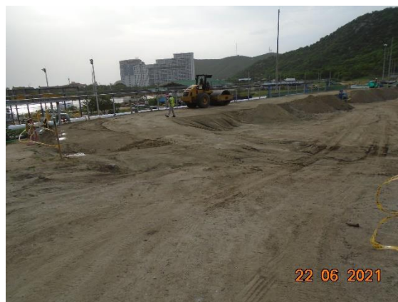
Figura 13 – Compactación del dique Fuente: Elaboración propia
