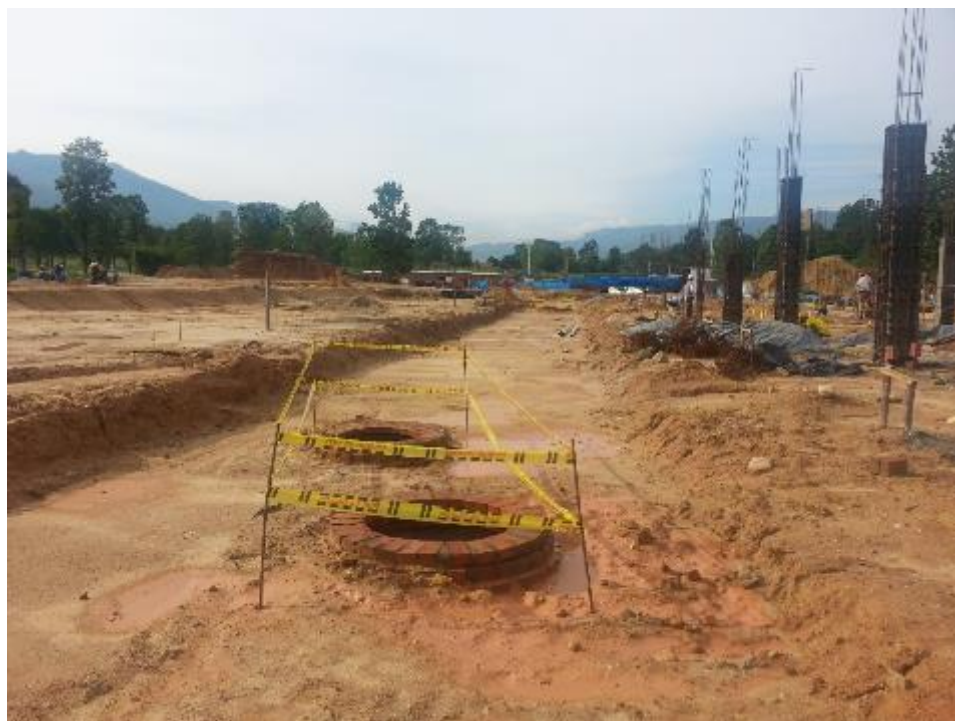
Imagen 10. Pozos de aguas negras y lluvias fundidos y con reducción en ladrillo T1.
