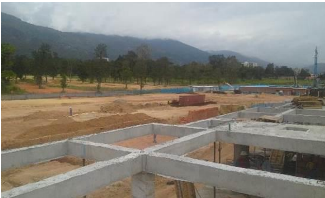
Imagen 52. Vigas y placa cubierta modulo A.
