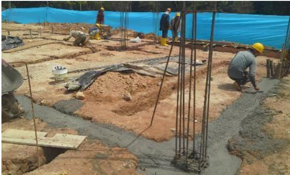
Imagen 14. Fundición de primer módulo de dos casas de cimentación
