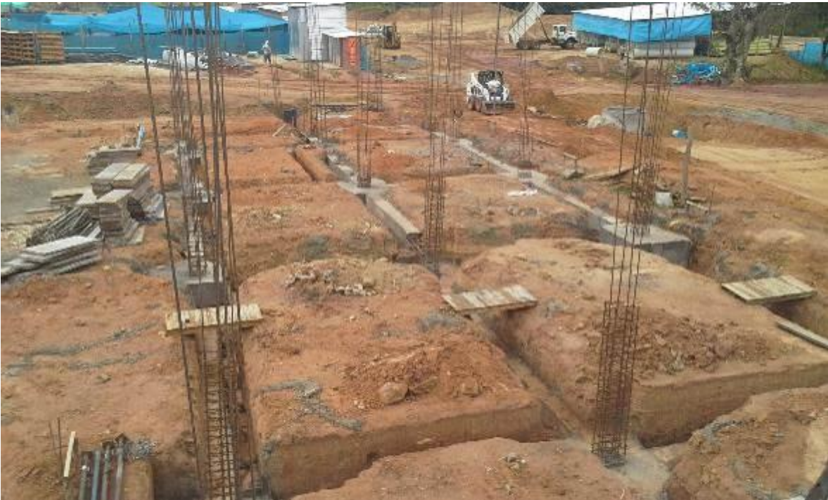
Imagen 55. Cimentación Club House
