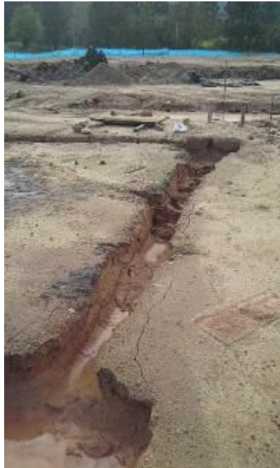
Imagen 12. Excavación de la cimentación.
