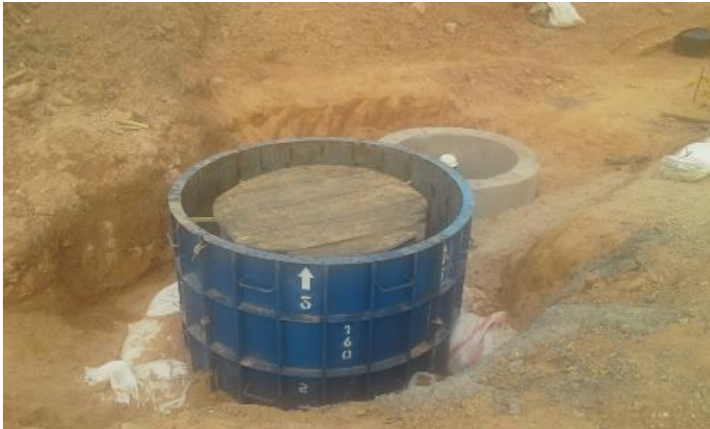
Imagen 9. Formaleta para pozo de aguas negras.
