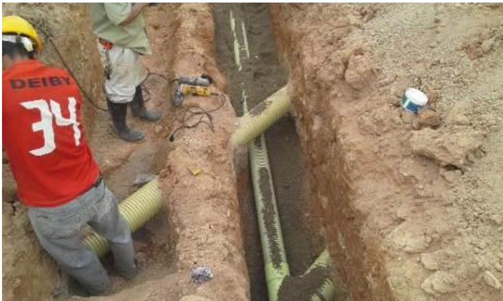
Imagen 47. Instalación de conexiones domiciliarias.
