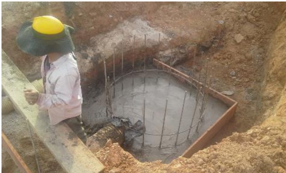
Imagen 8. Piso de pozo de aguas lluvias.
