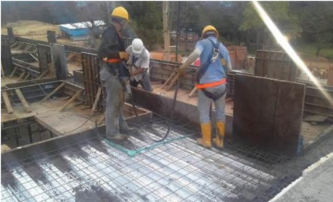
Imagen 53. Fundida placa vigas y placa cubierta
