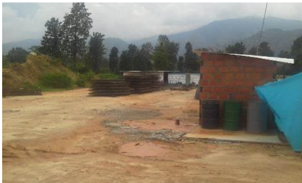
Imagen 7. Almacenamiento de formaleta y cambuche de contratistas.
