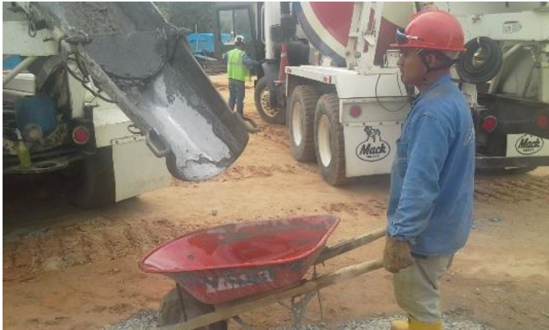
Imagen 42. Recepción de concreto en obra.
