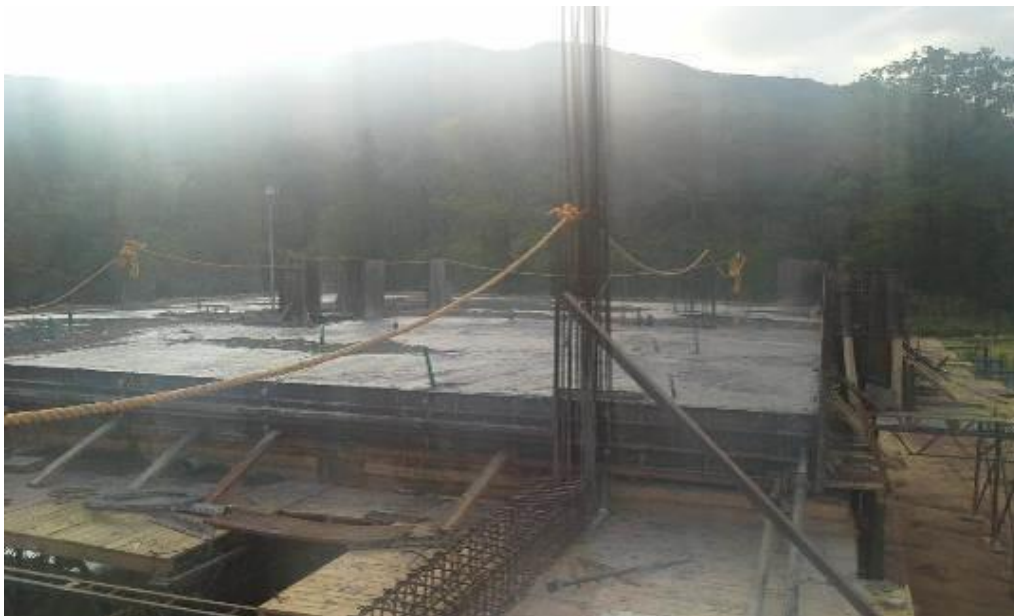
Imagen 44. Placa de modulo B manzana 1 fundida.
