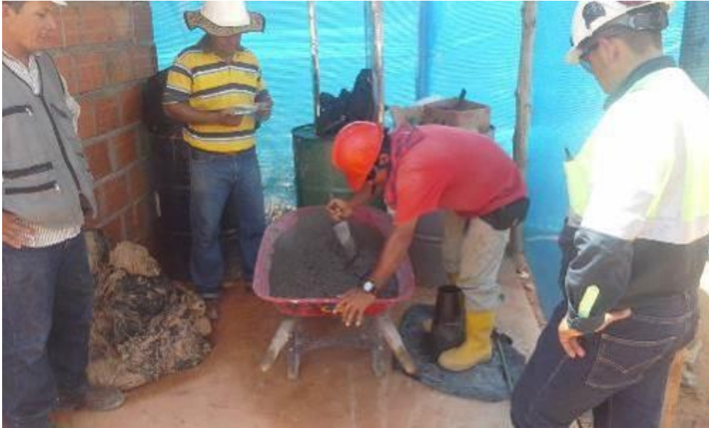
Imagen 20. Pruebas de recepción de concreto.
