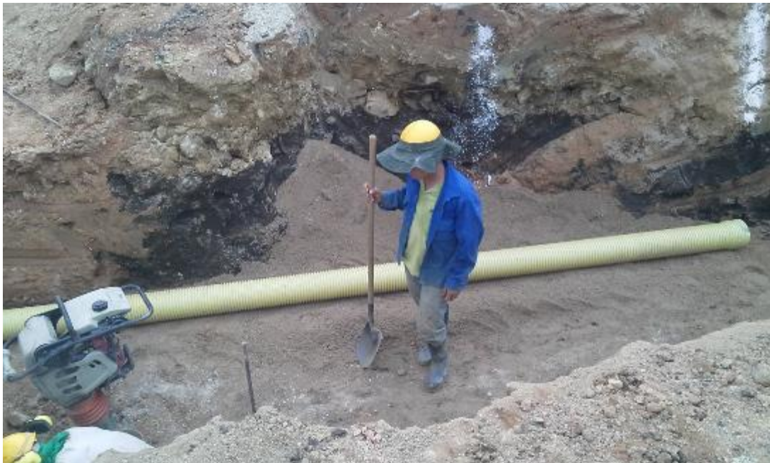
Imagen 25. Retranque de tubería sanitaria proyecto
