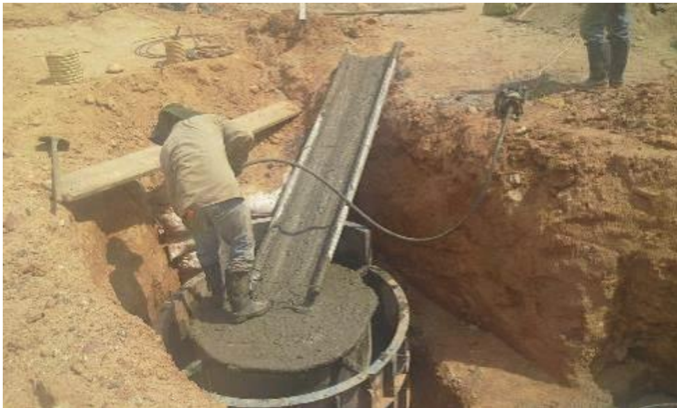
Imagen 39. Fundición de pozos.
