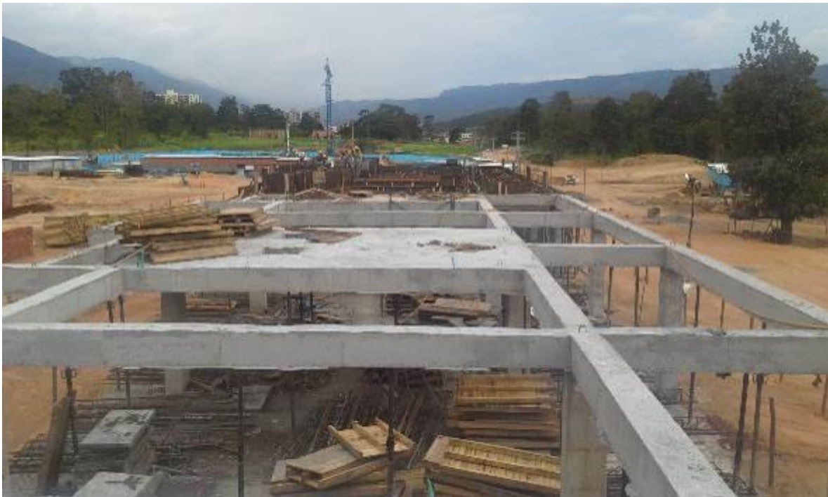
Imagen 51. Vigas y placa cubierta modulo A.
