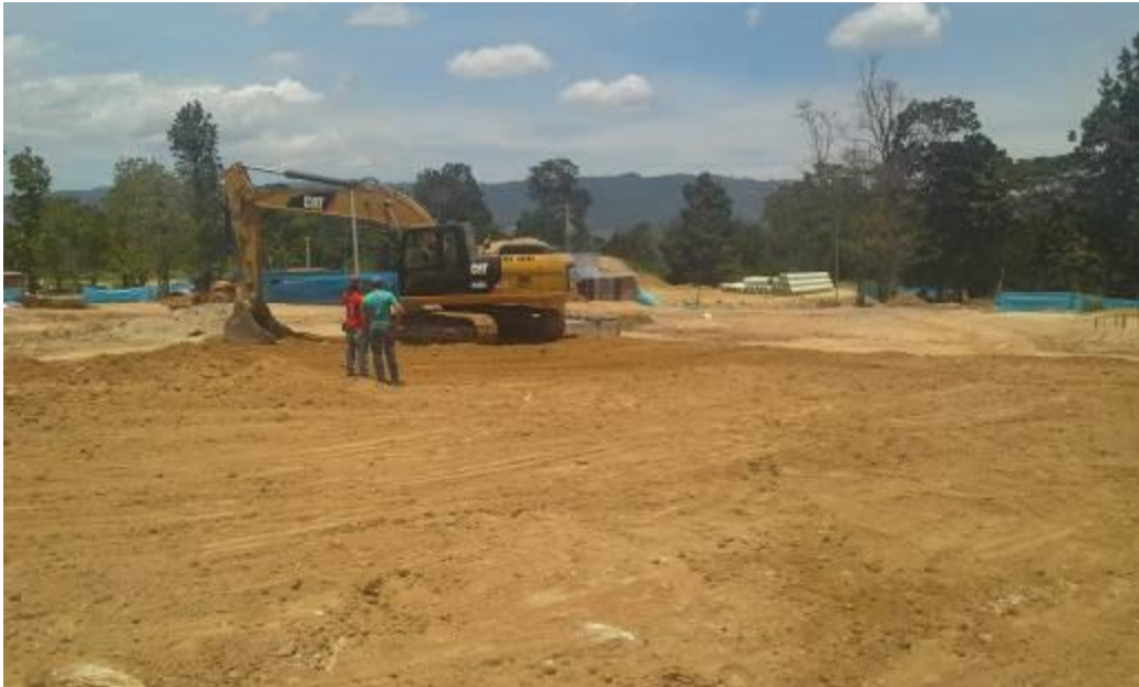
Imagen 34. Conformación de terrazas.
