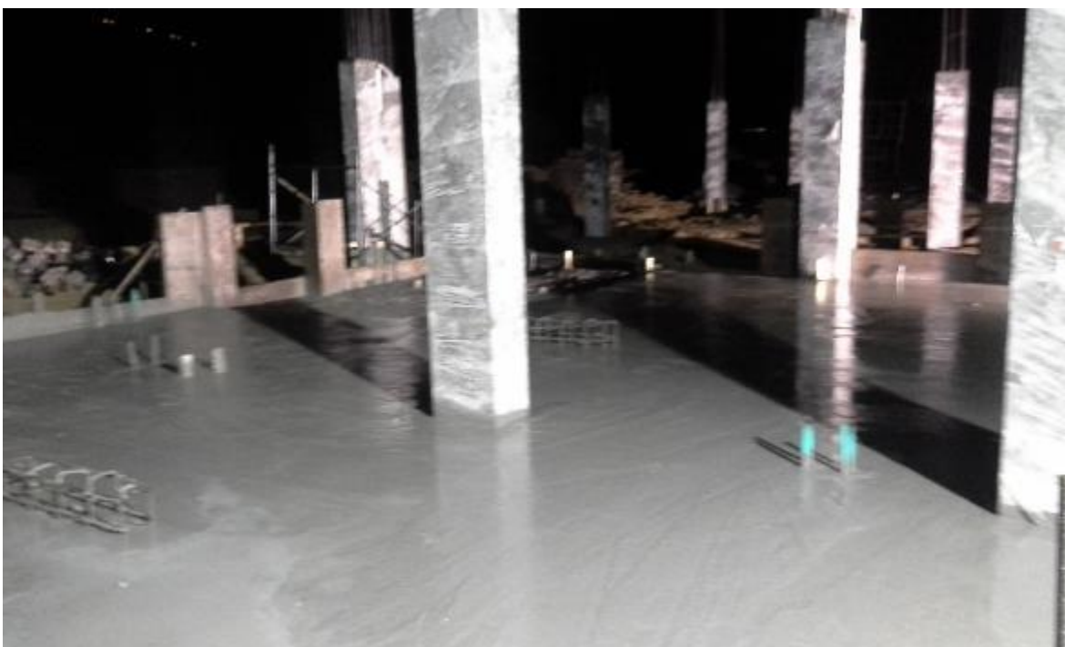
Imagen 28. Fundida de placa de antepiso de modulo A manzana 1.
