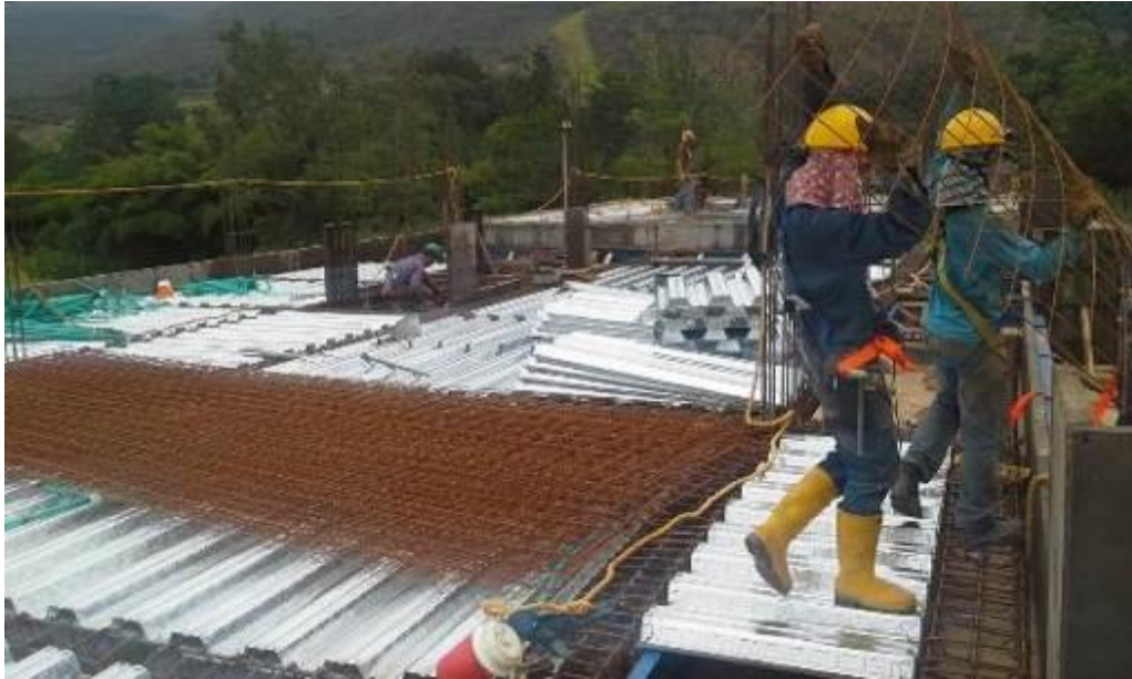
Imagen 38. Instalación de malla de refuerzo de 5.5mm.
