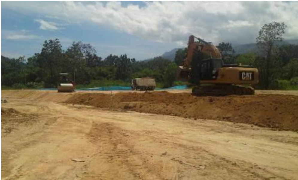
Imagen 35. Conformación de terrazas.
