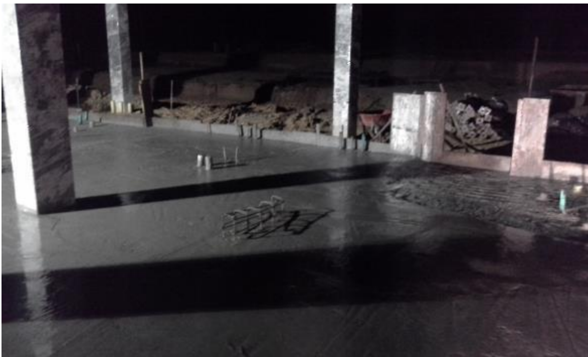
Imagen 27. Fundida de placa de antepiso de modulo A manzana 1.
