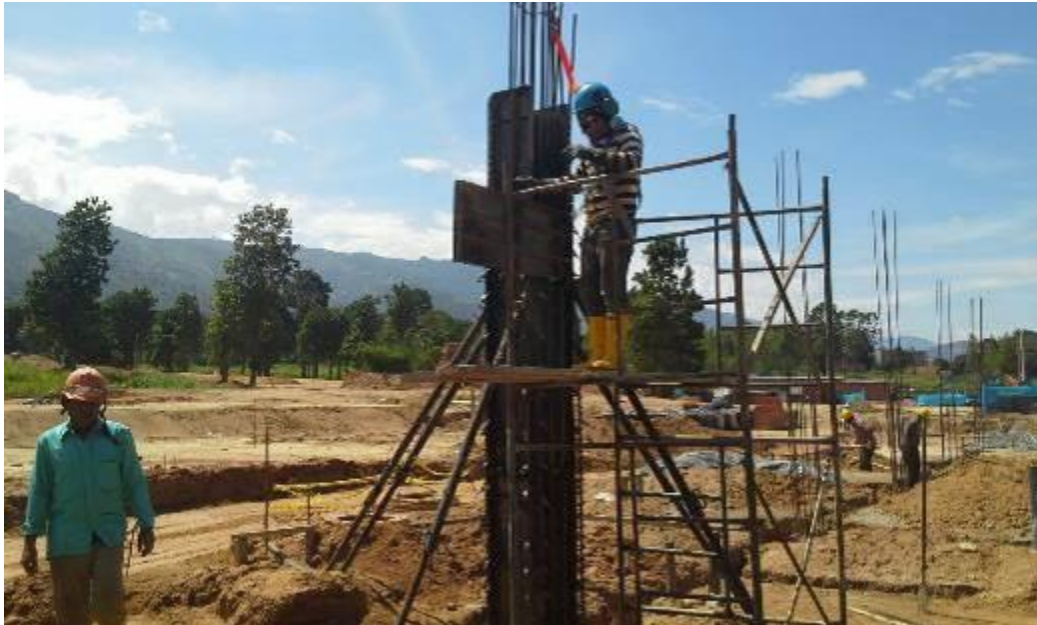
Imagen 16. Armado de formaleta para columnas de manzana 1.
