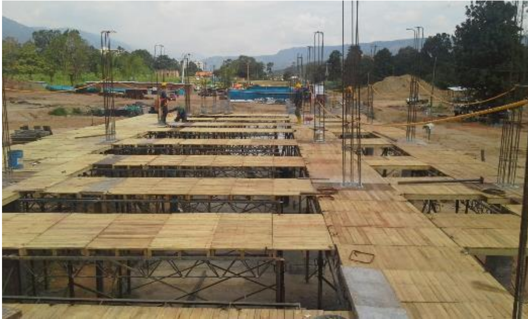
Imagen 30. Entablado de estructura segundo piso.
