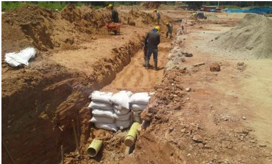
Imagen 18. Red sanitaria y pluvial del proyecto.
