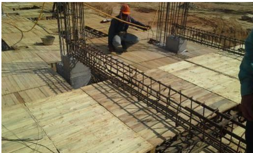
Imagen 33. Armado de estructura segundo piso modulo B.
