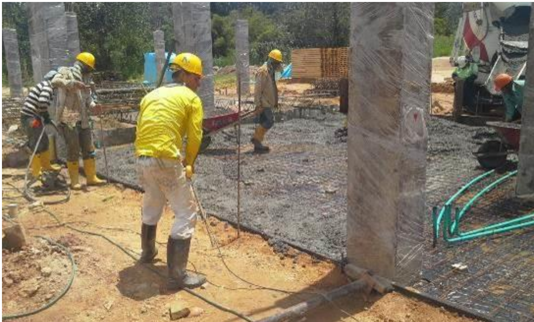
Imagen 22. Fundida de placa de antepiso, modulo A (4 casas) manzana 1.
