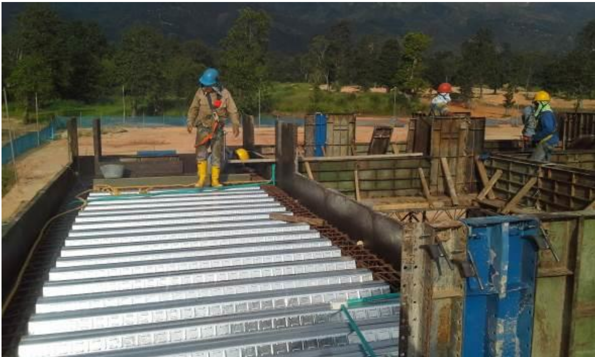
Imagen 45. Armado de placa cubierta modulo B
