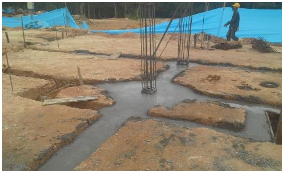
Imagen 15. Fundición de primer módulo de cuatro casas de cimentación.
