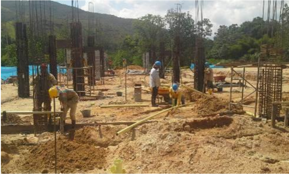
Imagen 17. Excavaciones red sanitaria y pluvial casas.
