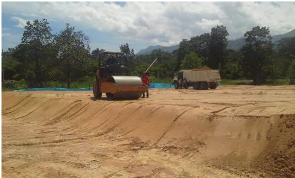
Imagen 36. Conformación de terrazas.
