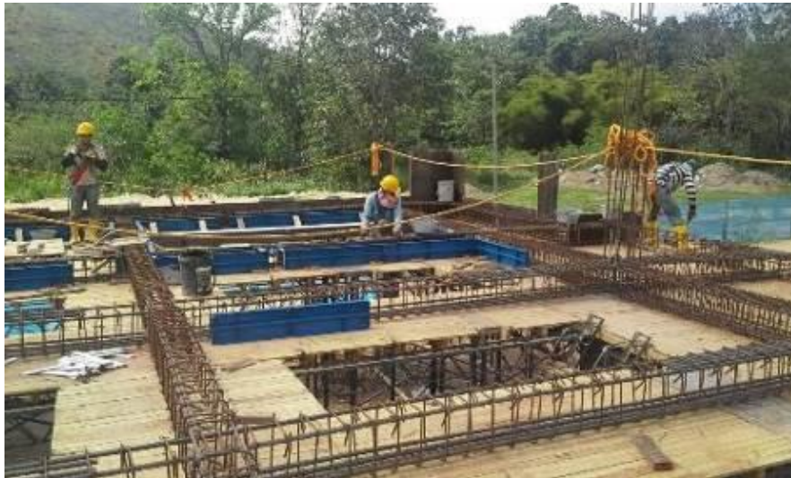
Imagen 32. Armado de estructura segundo piso modulo B.
