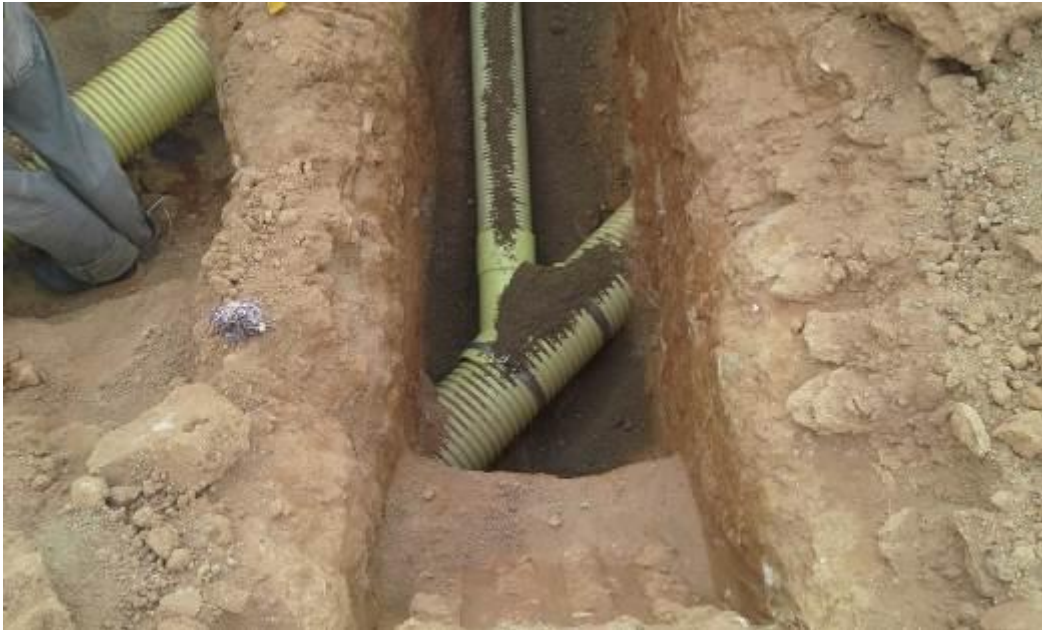
Imagen 49. Instalación de conexiones domiciliarias
