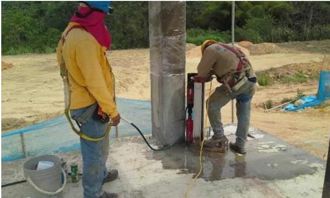
Imagen 58. Extracción de núcleos.
