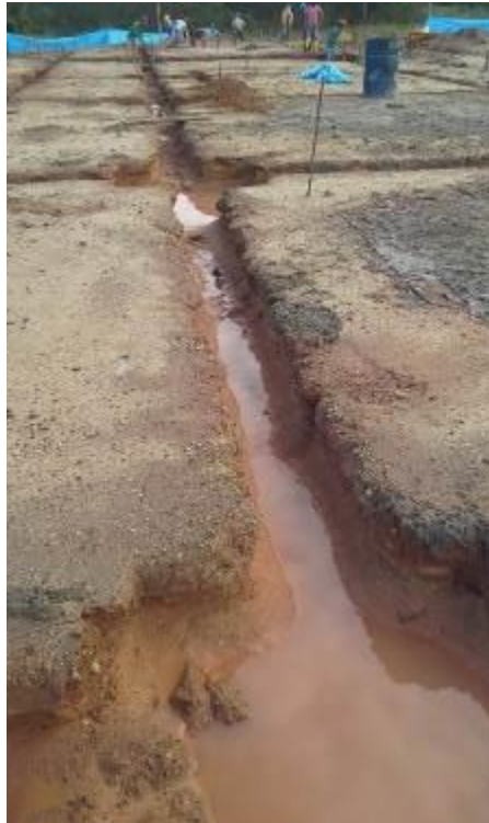
Imagen 11. Excavación de la cimentación para la manzana 1.
