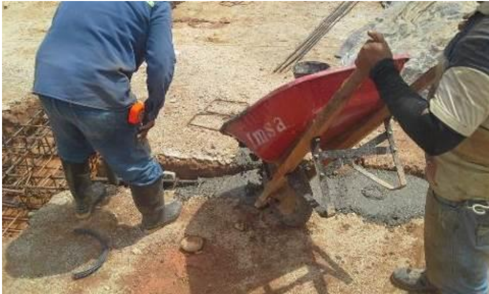
Imagen 13. Fundición de cimentación.
