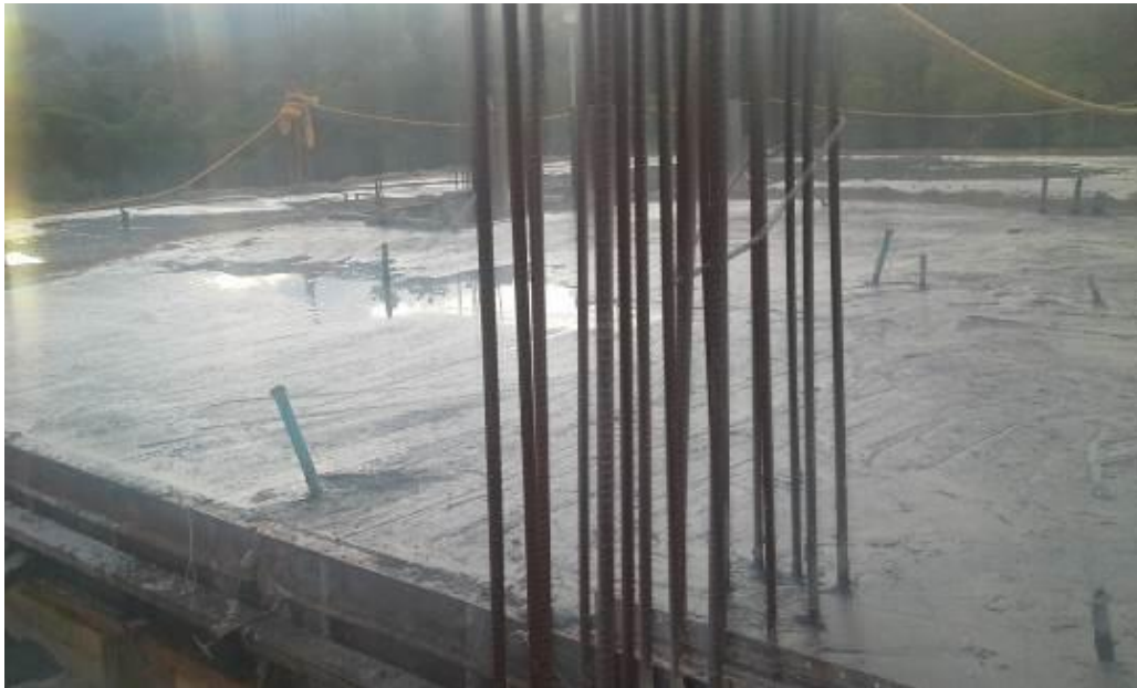
Imagen 43. Placa de modulo B manzana 1 fundida.
