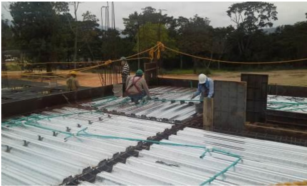
Imagen 37. Instalación de Steel deck en la placa.
