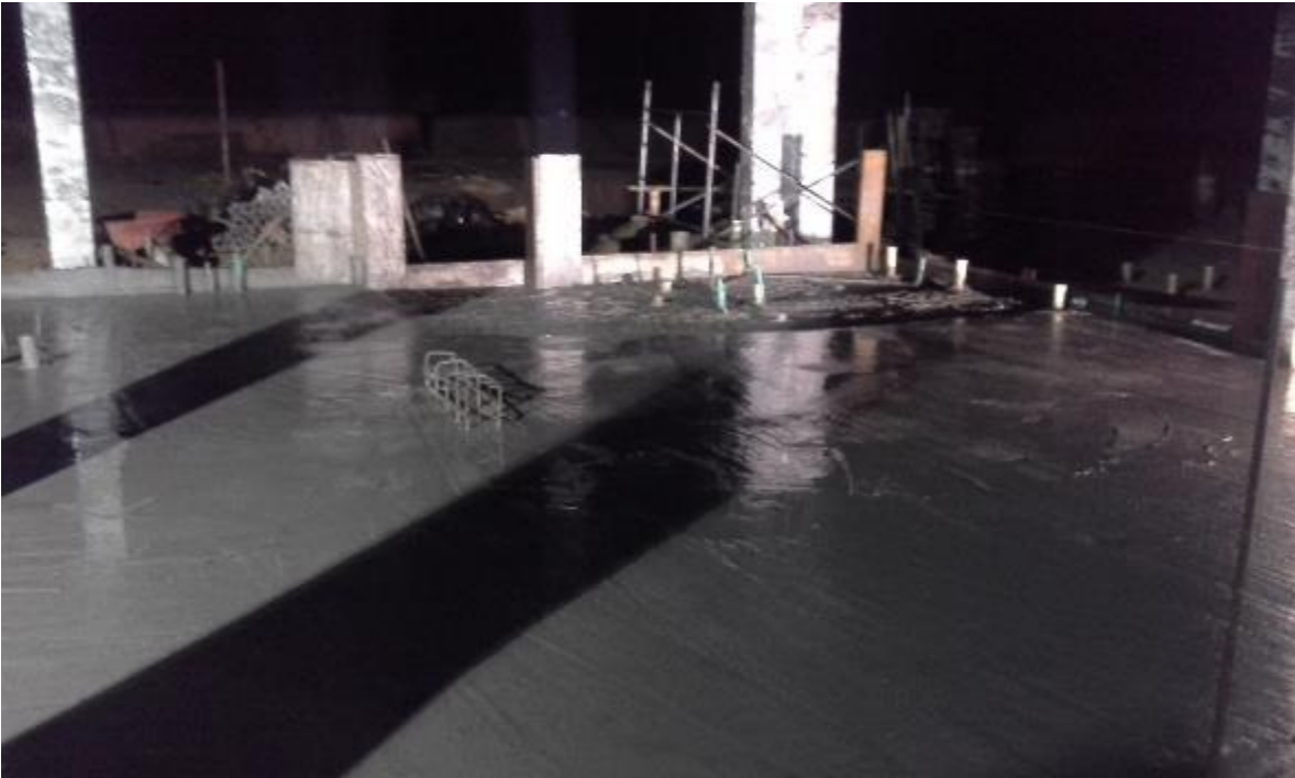
Imagen 26. Fundida de placa de antepiso de modulo A manzana 1.
