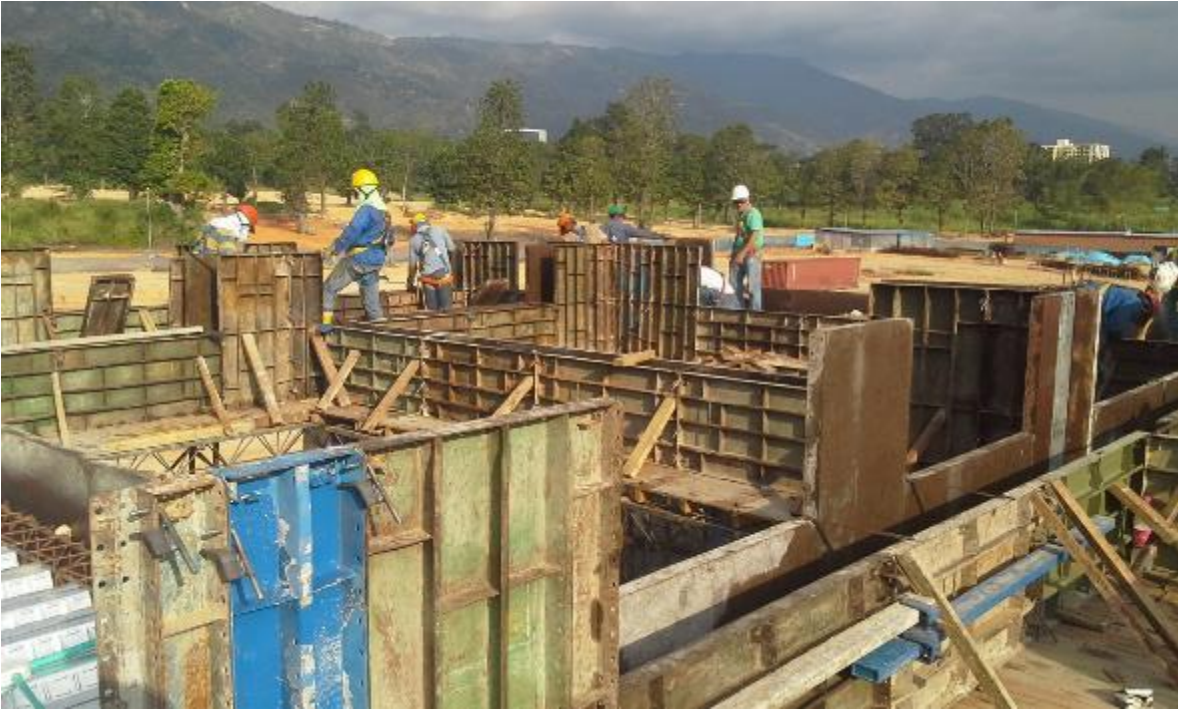
Imagen 46. Armado de formaleta para placa cubierta
