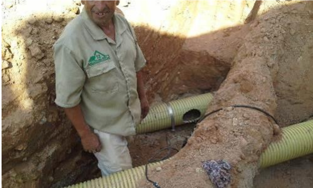
Imagen 48. Instalación de conexión domiciliaria.
