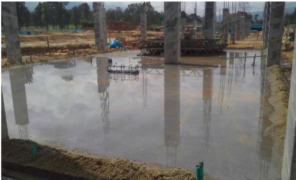
Imagen 19. Hidratación de losa de ante piso modulo B manzana 1.
