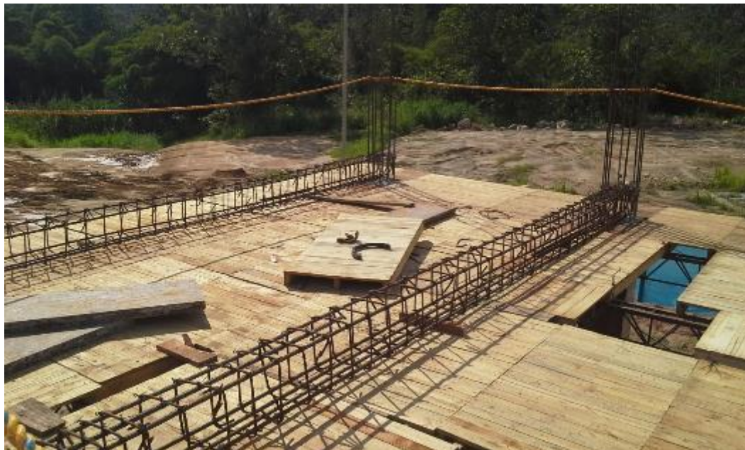
Imagen 31. Armado de vigas segundo piso modulo B.
