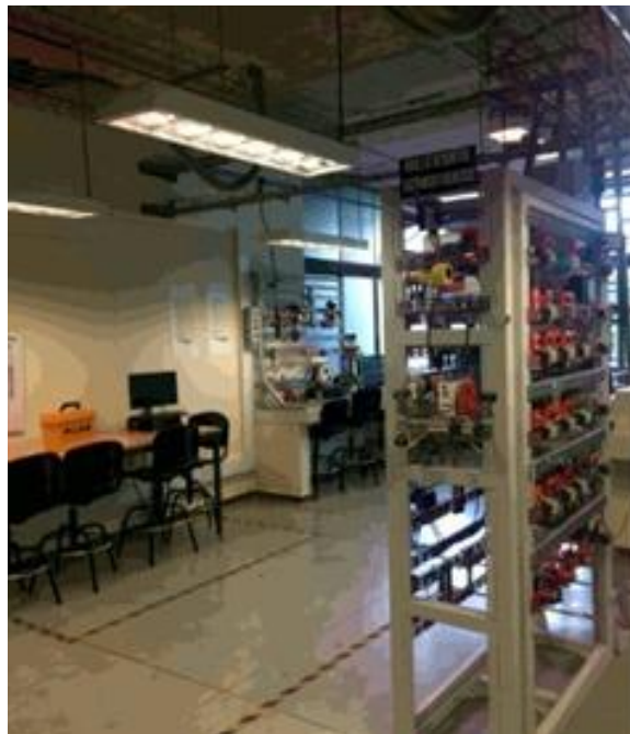
Figura 22. Zona de trabajo para cámara termográfica 22
