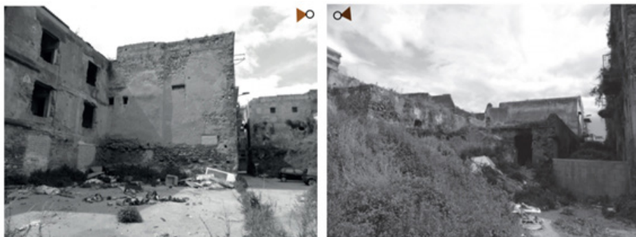
Figura 35. Fotos tomadas en el barrio que ejemplifican edificaciones con daños muy graves y de destrucción total respectivamente
