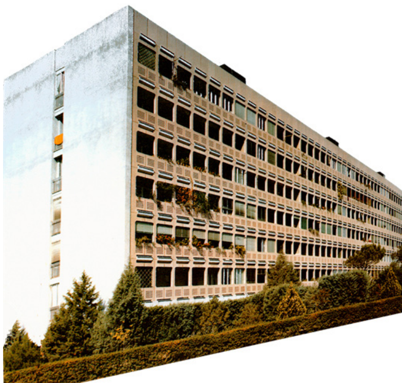
Figura 71. Serialidad y prefabricación en viviendas públicas
