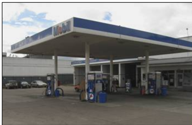
Figura 6 Vista panorámica EDS MOBIL El Proveedor
