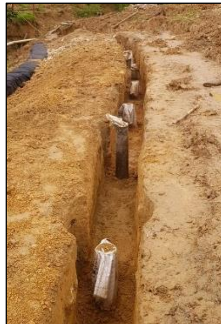
Fotografía 3. Micropilotes Pre – excavados
