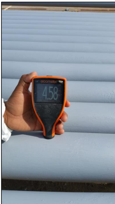
Fotografía 33. Medición de espesor de capa de pintura seca.
