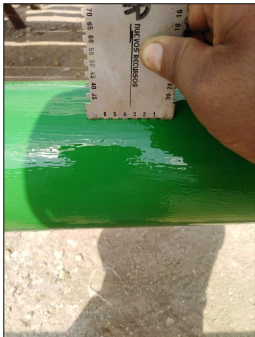
Fotografía 35. Medición de espesor de capa de pintura húmeda.
