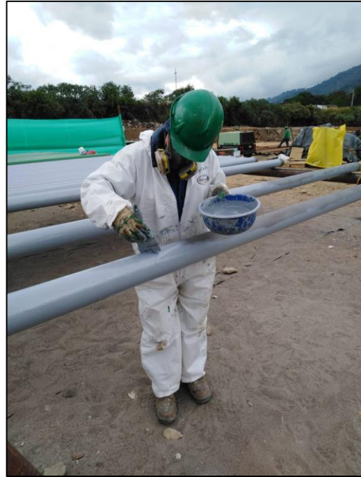
Fotografía 30. Aplicación de base sigmacover 280.
