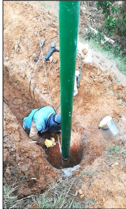
Fotografía 18. Se sueldan los demás paraleles.
