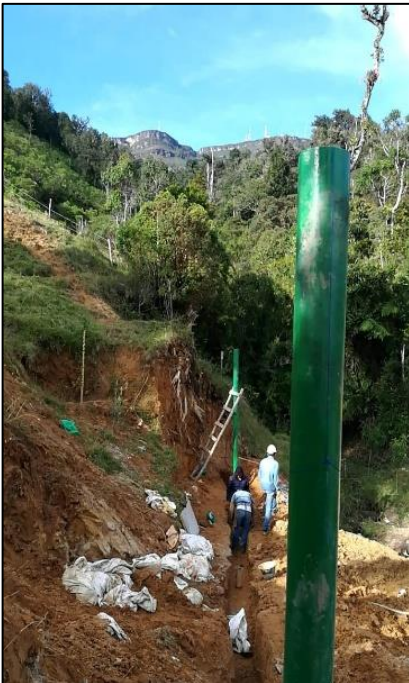
Fotografía 17. Se nivela altura de todo el trincho.
