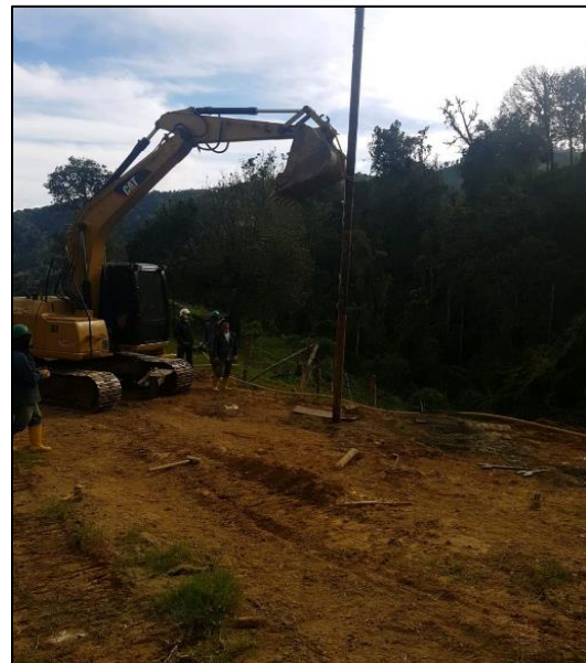
Fotografía 25. Se realiza izaje de la tubería.
