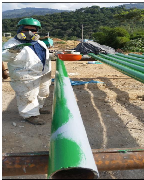
Fotografía 36. Medición de espesor de capa de pintura húmeda.
