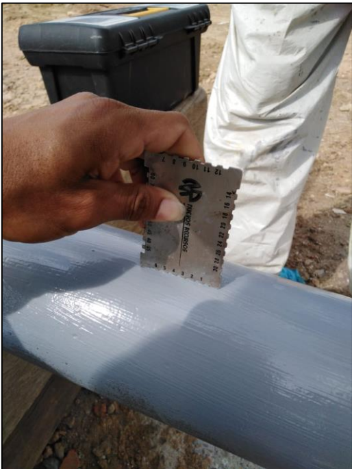
Fotografía 31. Medición del espesor de capa de pintura.
