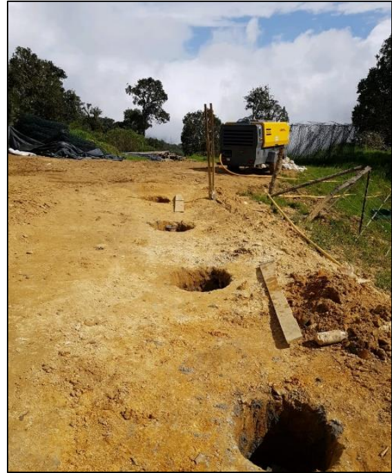
Fotografía 27. Vista general del sitio de obra.
