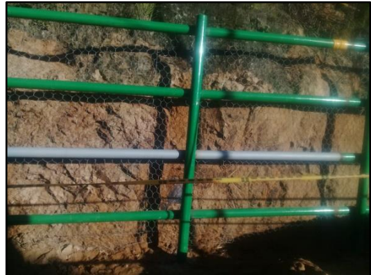
Fotografía 2. Trinchos tipo VIII
