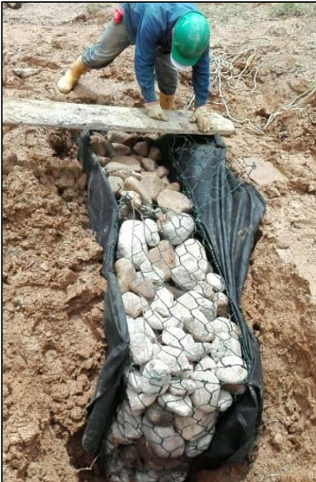
Fotografía 7. Se cierra la malla y se tapa con el geotextil.
