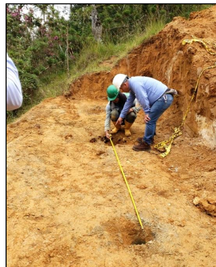
Fotografía 42. Interventoría corrobora separación de micropilotes y su diámetro.
