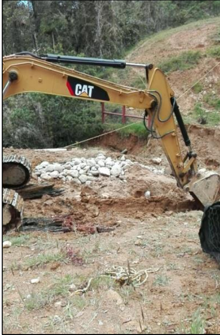
Fotografía 5. Se inicia excavación.
