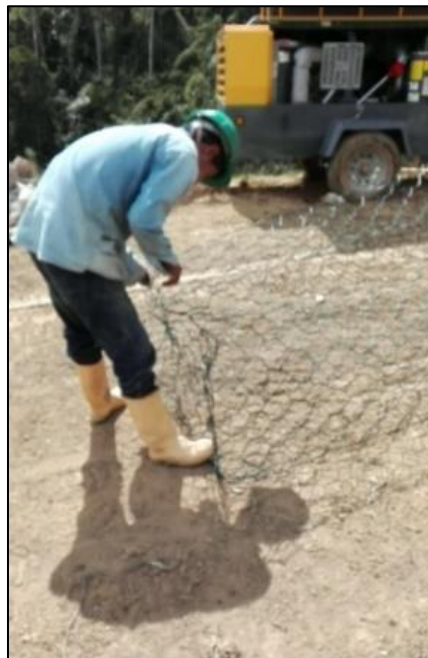
Fotografía 4. Se arma malla encauchetada.
