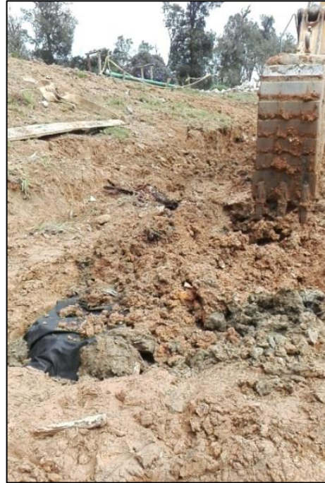
Fotografía 10. Se cubre el filtro con el mismo material de la excavación
