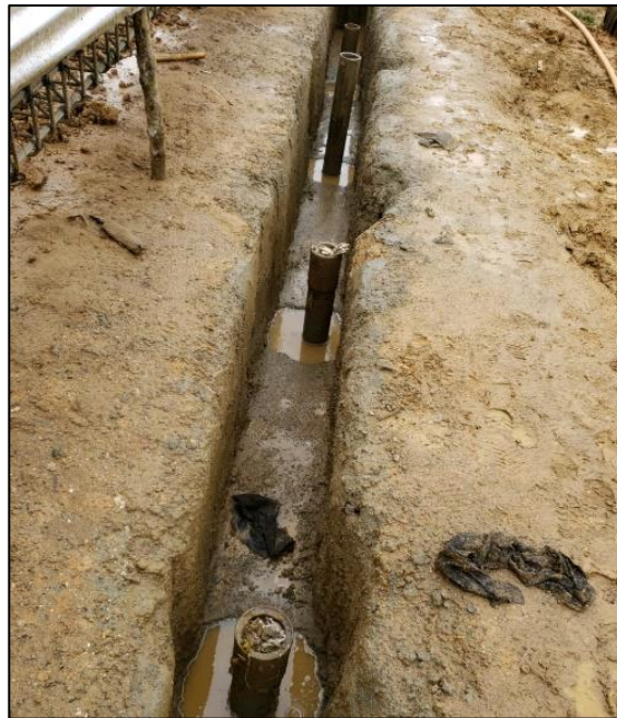
Fotografía 28. Vista general de obra.
