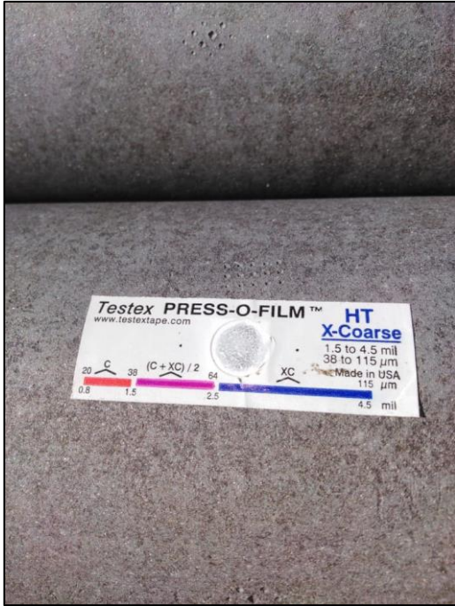
Fotografía 29. Medición de perfil de anclaje de tubería.
