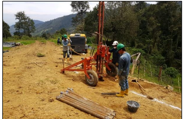
Fotografía 25. Se realiza izaje de la tubería.
