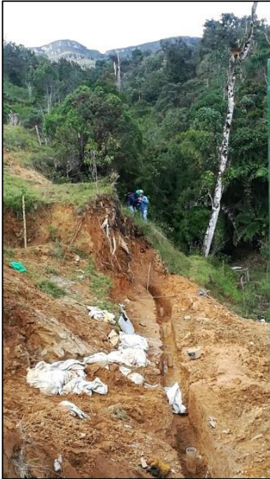
Fotografía 15. Se hace excavación para iniciar con proceso de soldar el trincho.
