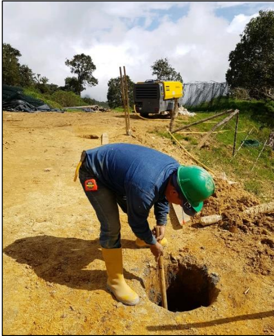
Fotografía 26. Se funde recubrimiento del micropilote
