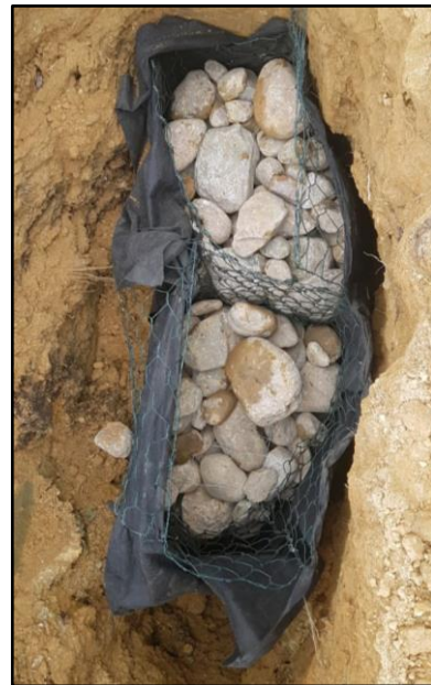
Fotografía 1. Filtro de llave cortante
