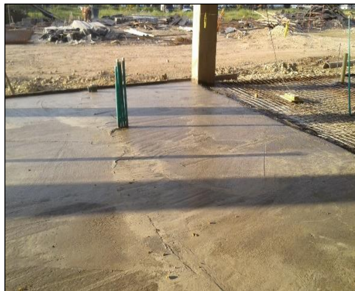
Figura 5 Placa de contrapiso SIPOL luego de su fundición
