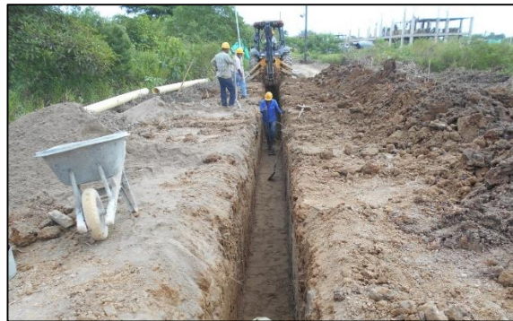
Figura 16 Instalación de alcantarillado pluvial externo
