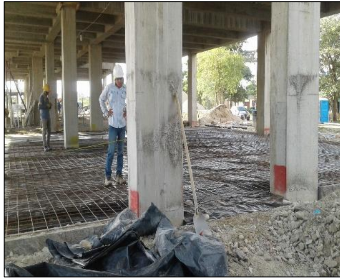
Figura 4 Placa de contrapiso SIPOL previa a su fundición
