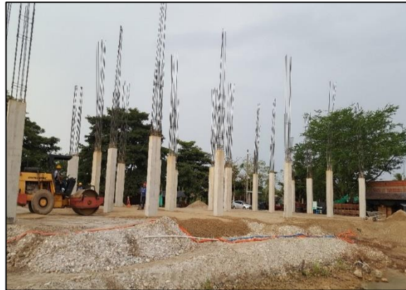
Figura 3 Columnas fundidas primer piso edificio SIPOL
