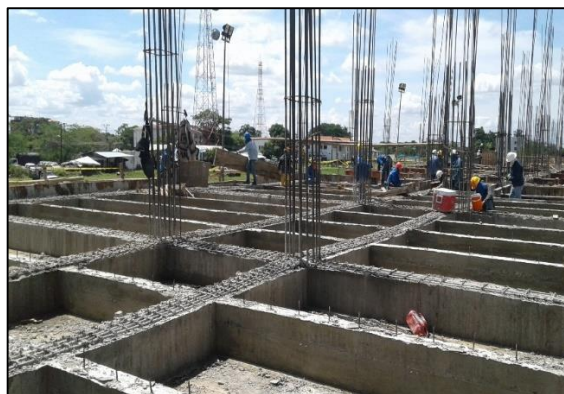
Figura 17 Personal operativo en trabajo de desencofrado de vigas y viguetas
