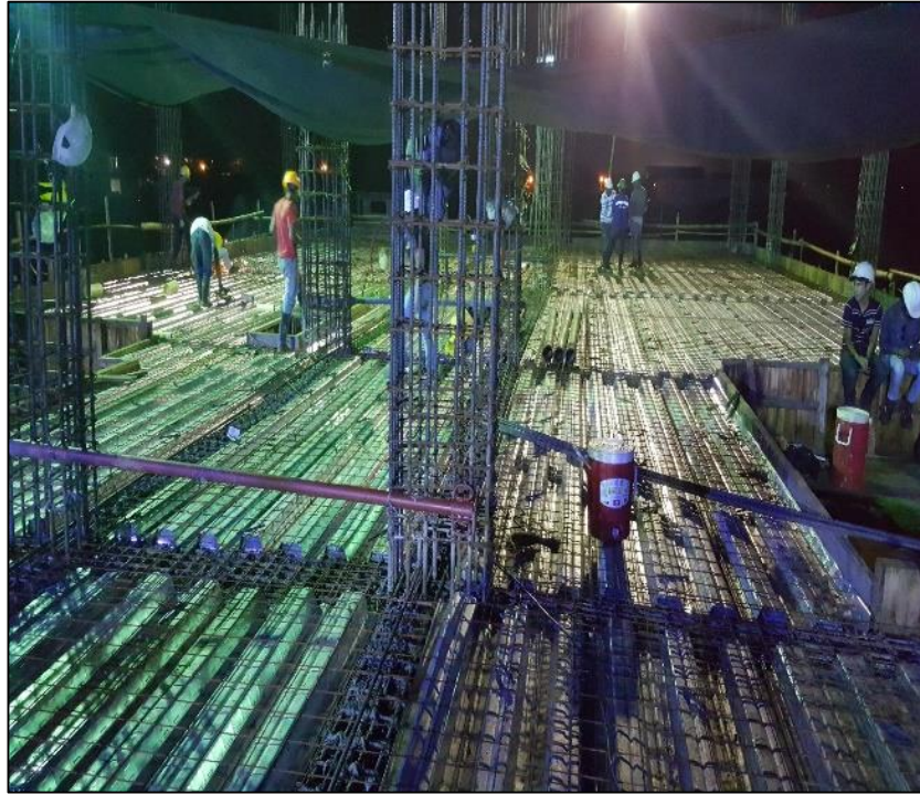
Figura 20 Personal operativo finaliza la instalación de steel deck y malla electrosoldada
