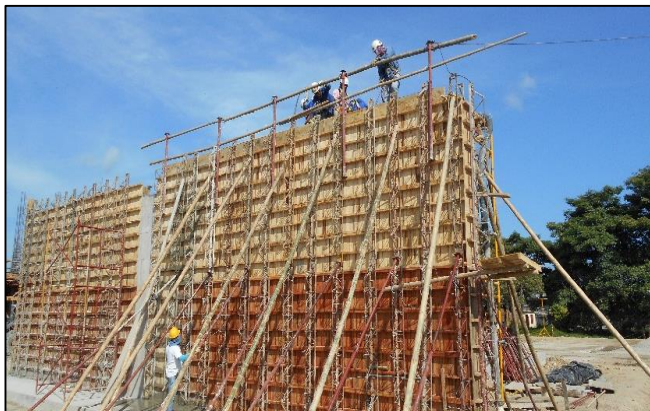
Figura 15 Muro pantalla en concreto de 3000 Psi
