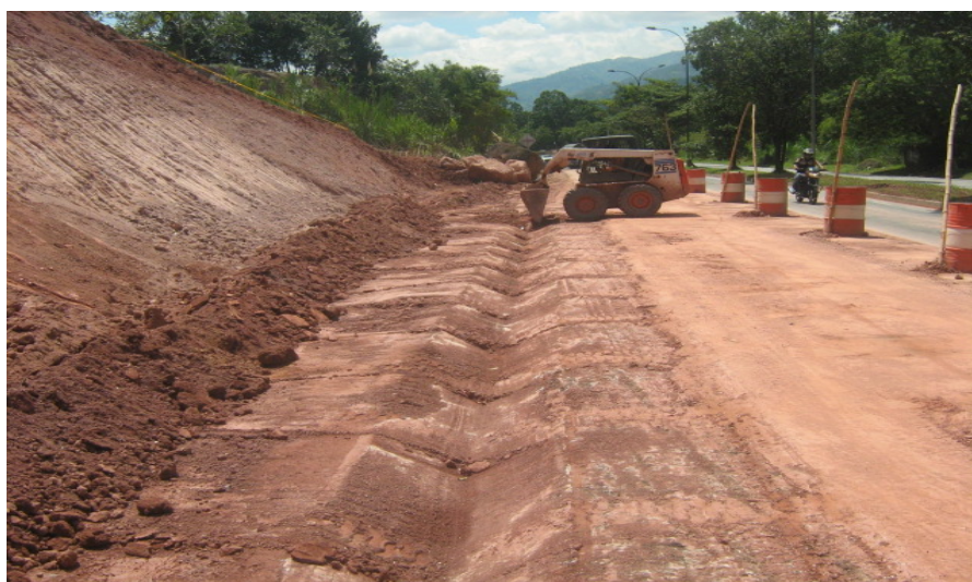
Figura 25. Inspección del predio intervenido verificando actividades de limpieza.
