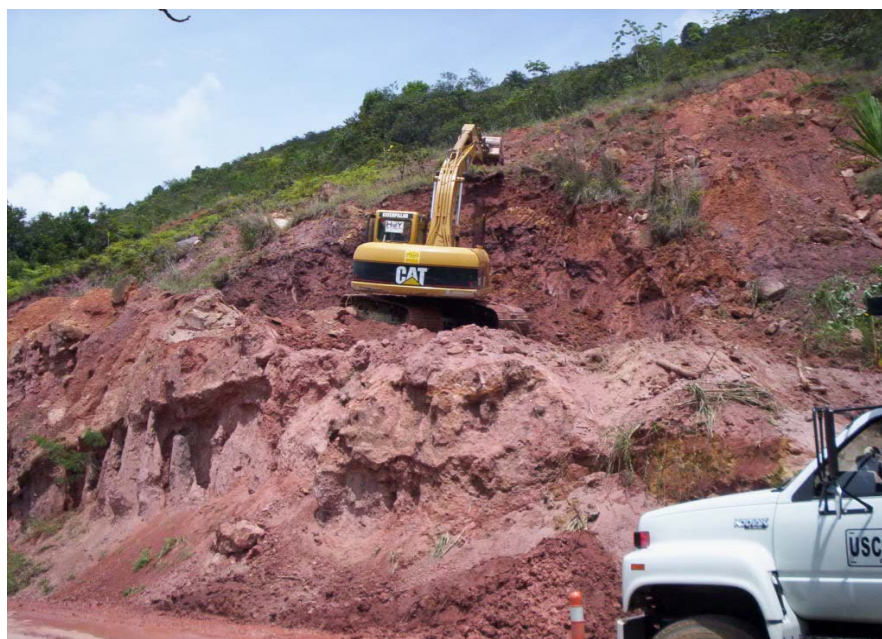
Figura 23. Inicio de Actividades de Corte de Taludes.
