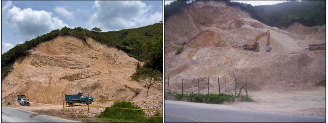
Figura 3. Vista de la Zona de Explotación a un Costado de la Vía Piedecuesta Curos
