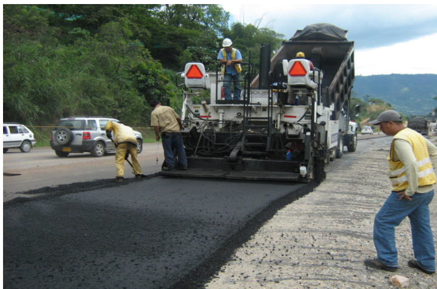
Figura 38. Actividad de Construcción de la Capa Asfáltica de la Estructura de Pavimento. Sector el Molino Localizado entre las Abscisas k14+290 a k14+578 en el Costado Occidental.
