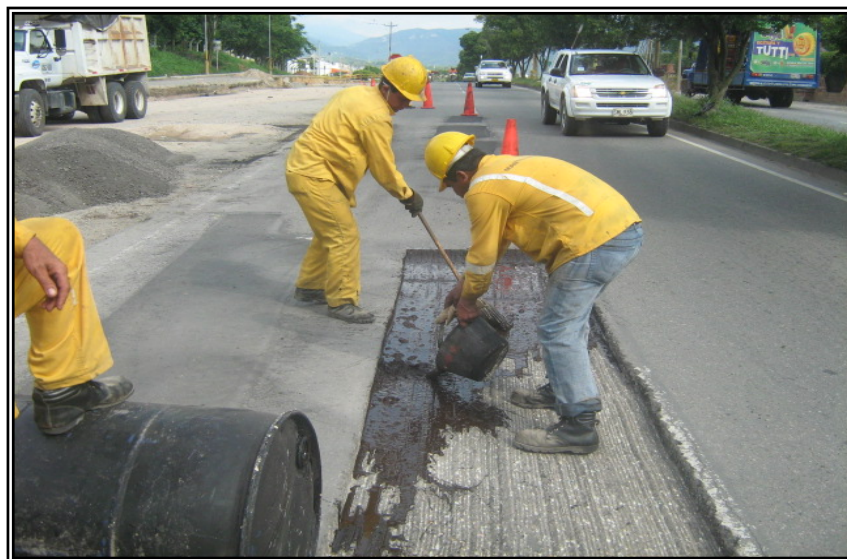
Figura 37. Impregnación de Emulsión Asfáltica Para Ligar el Asfalto Antiguo con el Nuevo.
