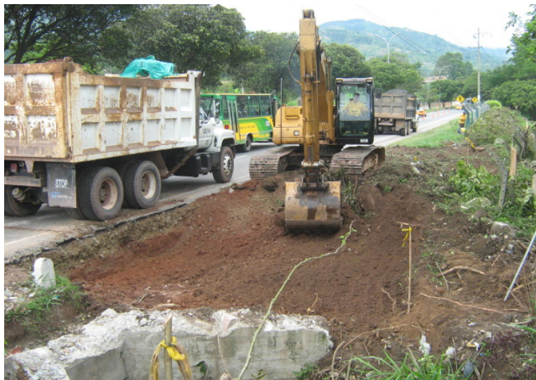
Figura 17. Inicio de labores de excavación.
