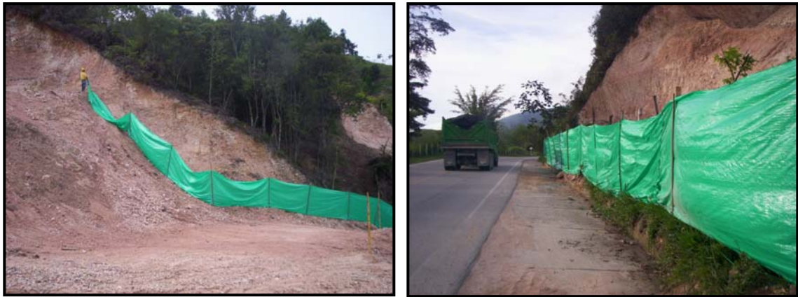
Figura 42. Aislamiento del área de explotación con malla verde.
