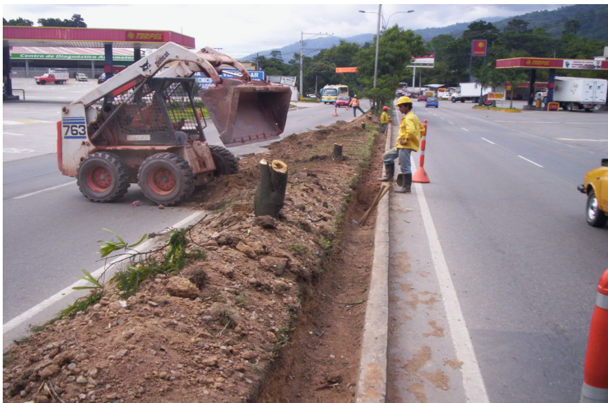
Figura 26. adecuación del separador en el sector de la Estación de Servicio San Pedro para inicio de Contra-flujo. Paso de línea telefónica y fibra Óptica.
