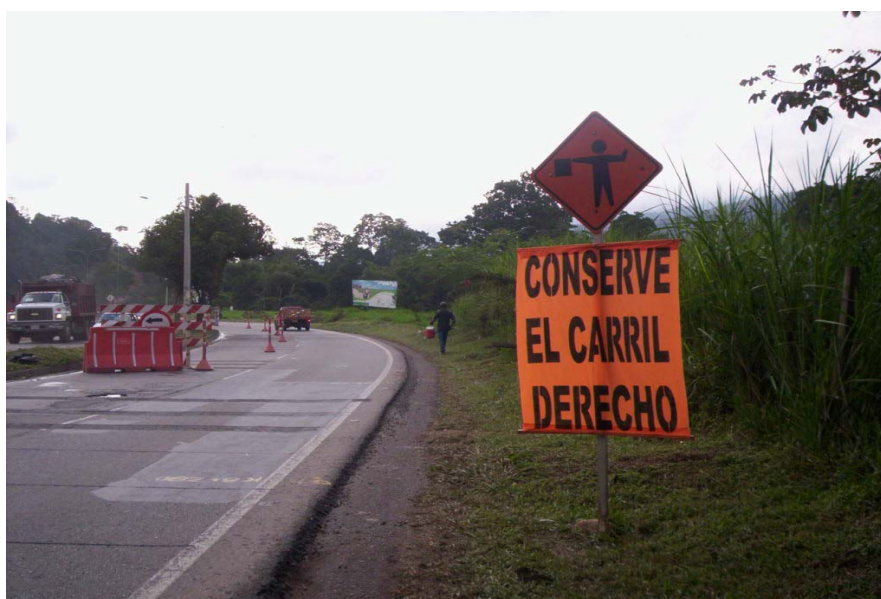
Figura 31. Verificación PMT. Señal Informativa. Señal Vertical.
