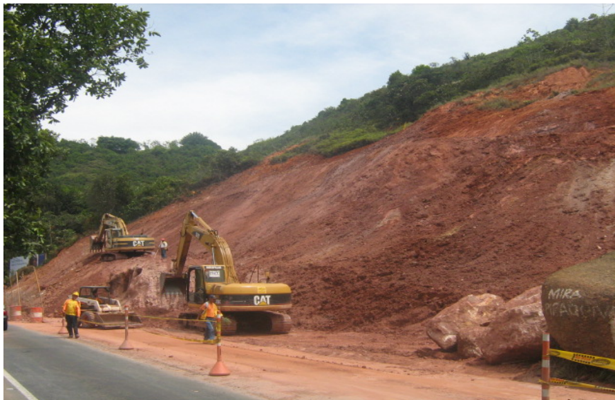
Figura 24. Inspección del Predio Intervenido Verificando Señalización de la Zona.
