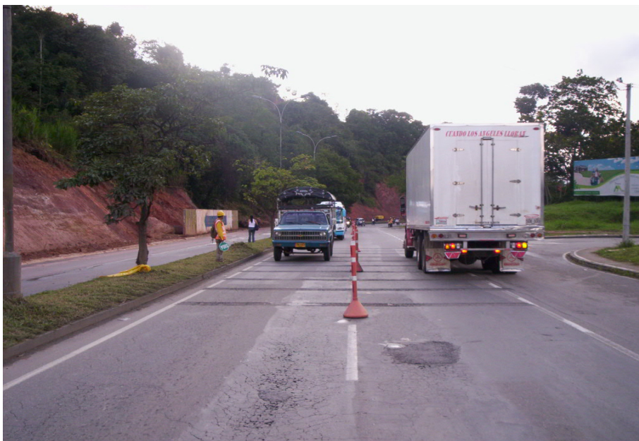
Figura 32. Verificación PMT. Delineadores Tubulares Delimitando Carriles de Contra-Flujo.
