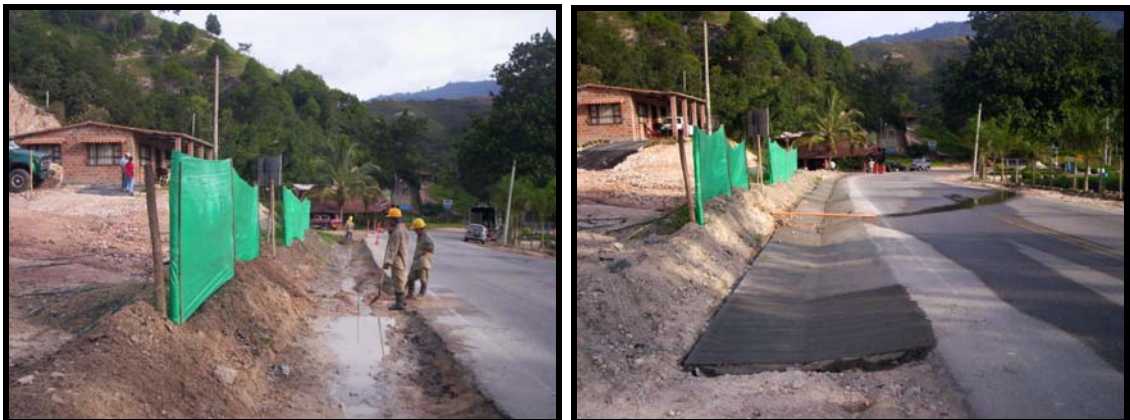
Figura 41. Construcción de Cuneta.
