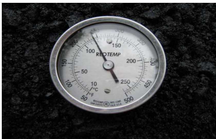
Figura 39. Medición Constante de Temperatura Para Iniciar su Compactación.
