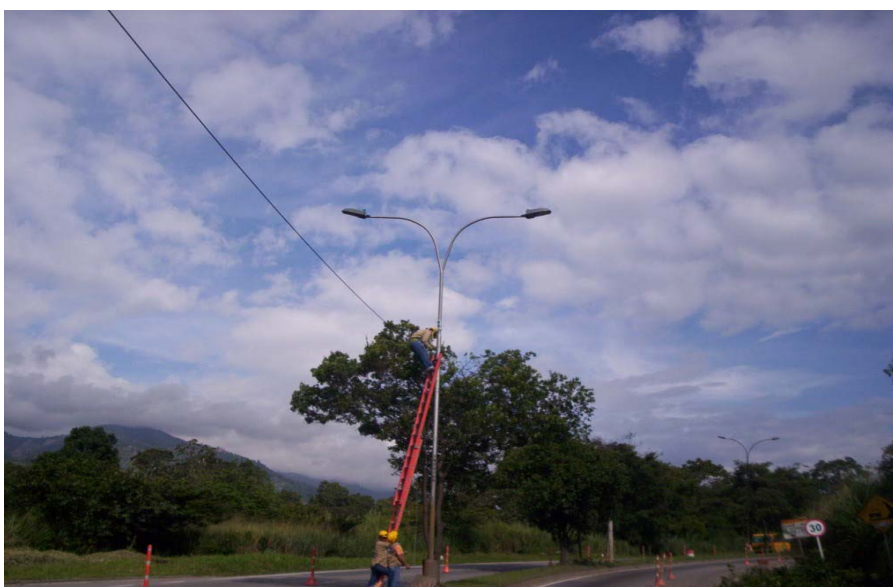
Figura 27. Adecuación de Línea de Alumbrado Público en el Sector de Mensuli.
