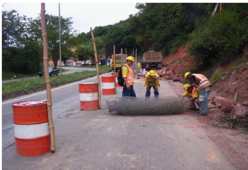
Figura 29. Instalación de Malla de Seguridad Eslabonada
