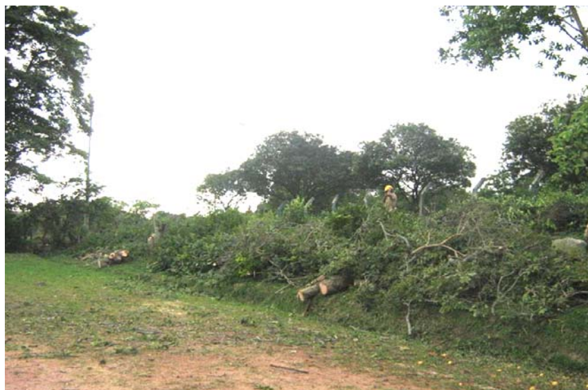
Figura 16. Inicio de Labores de Corte de Swinglia y Tala de Árboles.
