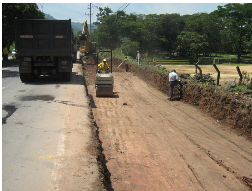
Figura 18. Inicio de Labores de Excavación. Lunes 29 de Abril.
