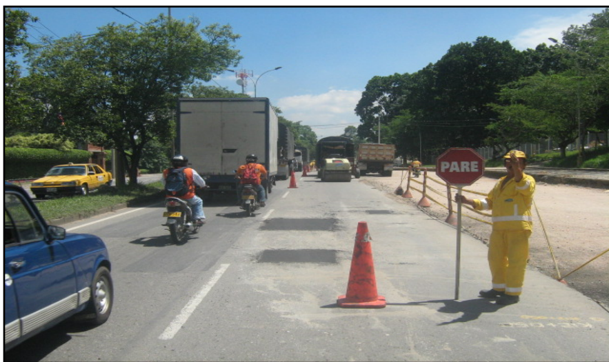
Figura 34. Verificación PMT. Actividades de Reparcheo.
