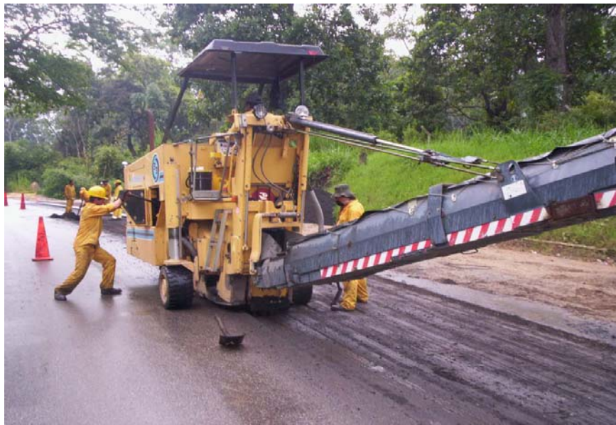
Figura 36. Remoción de Capa Asfáltica en Fallo Para su Respectiva Rehabilitación.
