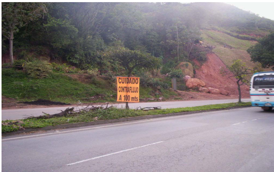
Figura 30. Verificación PMT. Señal Informativa Indicando la Proximidad de Contra-Flujo.
