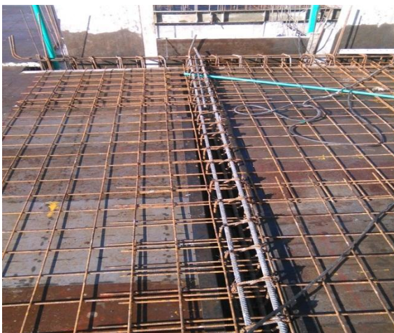
Figuras 7 y 8. Verificación refuerzo superior e inferior de placas y vigas.
