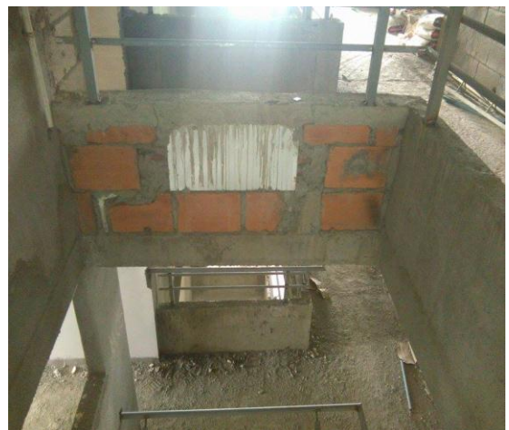
Figuras 73 y 74. Estructura con una hilada de bloque y antepecho con bloque de arcilla.
