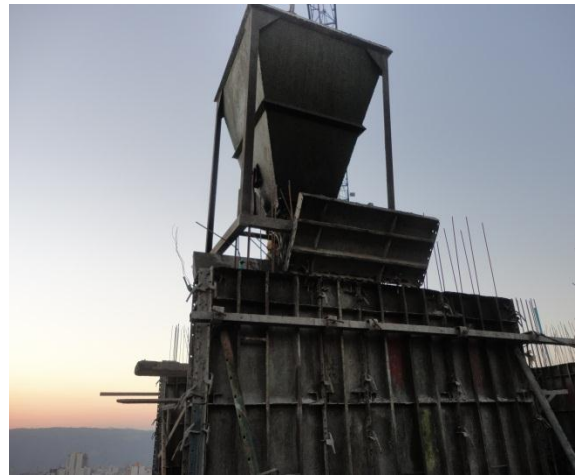
Figura 15. Vaciado y Vibrado del concreto.
