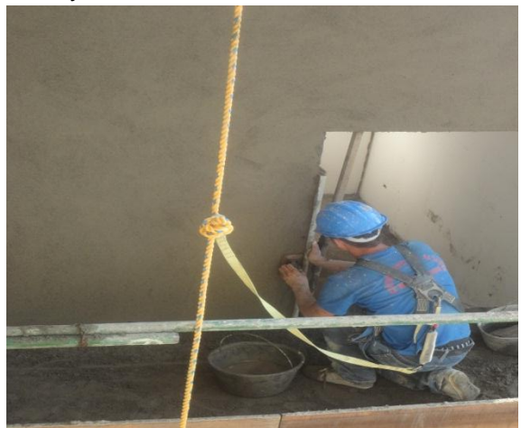
Figuras 34 y 35. Instalación de tablas para goteros y alisamiento de embones.
