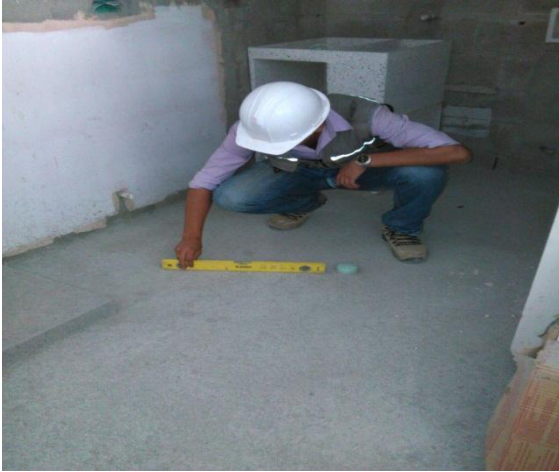
Figuras 48 y 49. Pruebas de nivel y desagüe de líquidos.
