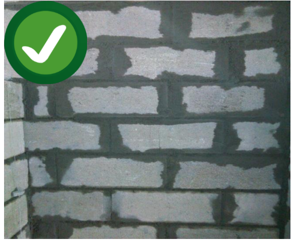
Figuras 23 y 24. Verificar unión completa de bloques con mezcla de mortero.
