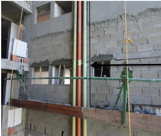
Figura 31. Verificación del calandro e instalación malla sin vena en la placa y tuberías.
