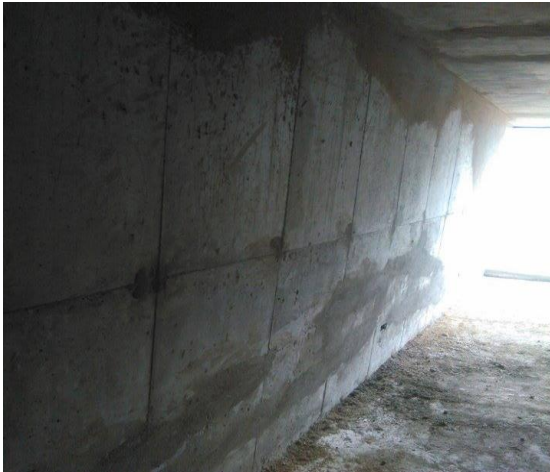
Figuras 63 y 64. Superficie completamente limpia libre de residuos.
