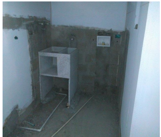
Figuras 59 y 60. Instalación de lavadero y delimitación de zona a enchapar.
