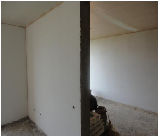
Figuras 67 y 68. Aplicación primera capa de pintura, fillos y dilataciones
