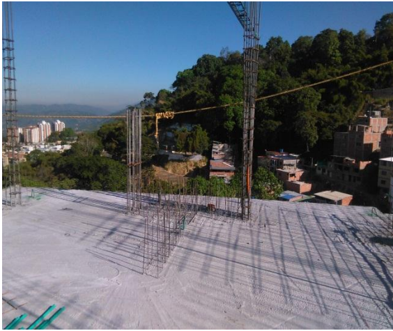
Figuras 12 y 13. Localización y verificación de refuerzo con malla electrosoldada.
