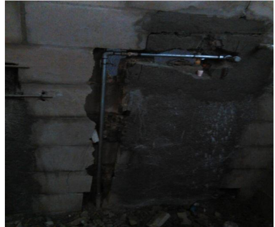
Figuras 89 y 90. Instalación de tuberías de gas por regata.
