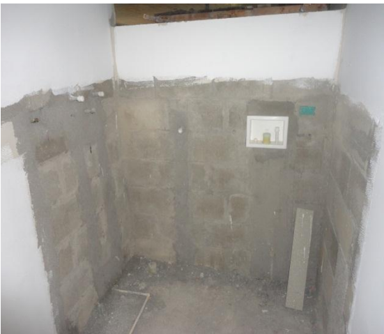
Figuras 59 y 60. Instalación de lavadero y delimitación de zona a enchapar.
