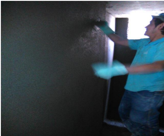
Figuras 29 y 30. Uso de la regla metálica y de llana para el acabado final de la superficie.
