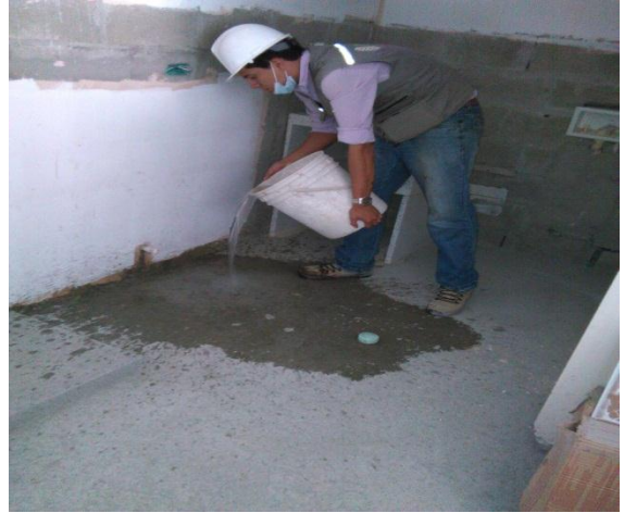
Figuras 50 y 51. Limpieza e impermeabilización de zonas húmedas.
