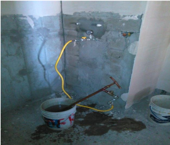
Figuras 85 y 86. Pruebas hidráulicas para sistema de tuberías hidráulicas.
