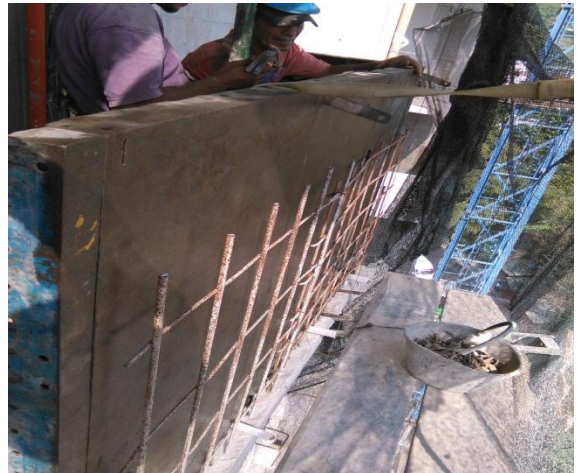
Figuras 18 y 19. Verificación refuerzo con malla electrosoldada.
