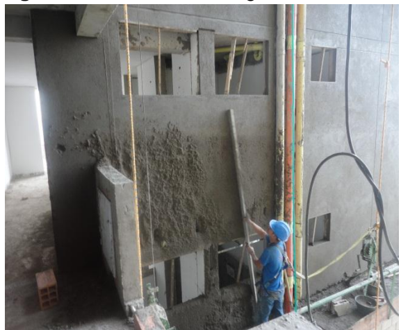
Figura 33. Acabado con regla.
