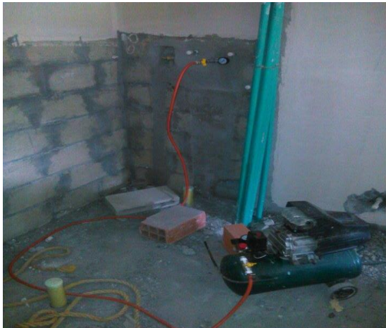
Figuras 91 y 92. Pruebas de gas natural.
