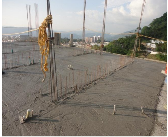
Figuras 9 y 10. Vaciado, vibración y alisado de la superficie.
