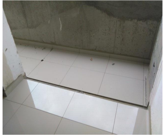
Figuras 44 y 45. Instalación de hiladas completas y chazos ajustados al área solicitada.
