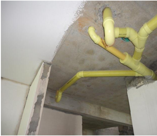
Figuras 83 y 84. Instalación de tuberías descolgadas y bajantes.
