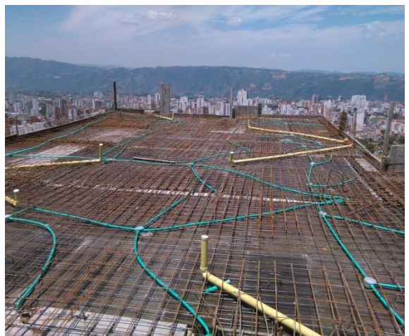
Figuras 7 y 8. Verificación refuerzo superior e inferior de placas y vigas.
