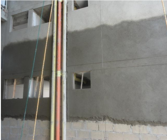
Figura 36. Verificación de acabados de las dilataciones, embones y goteros.
