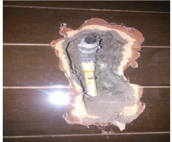
Figuras 87 y 88. Posibles daños generados por las pruebas que deben ser reparadas.
