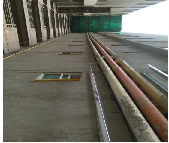
Figuras 83 y 84. Instalación de tuberías descolgadas y bajantes.
