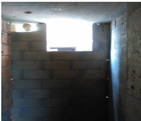
Figuras 97 y 98. Revoque de vanos de ventanas.
