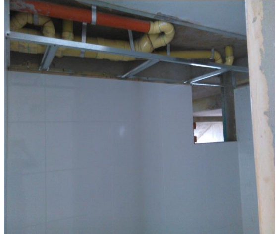
Figuras 75 y 76. Instalación perfiles y ángulos en zonas húmedas y sala.
