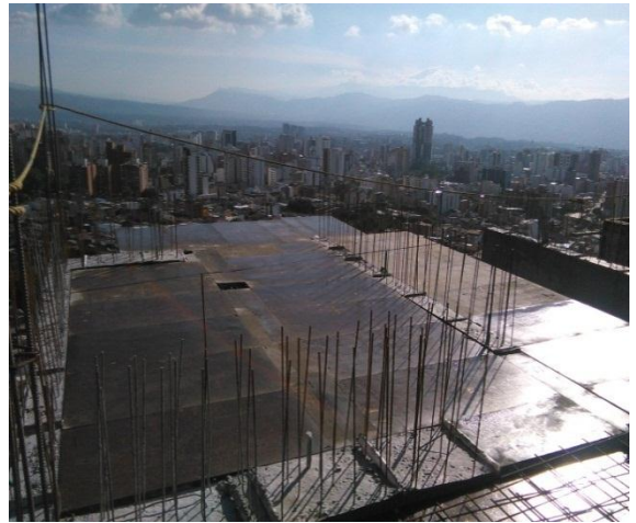
Figuras 5 y 6. Instalación elementos verticales para soporte del concreto.
