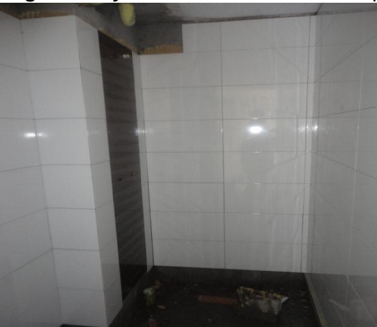
Figuras 61 y 62. Acabado final de enchape en baños y zona de ropas.
