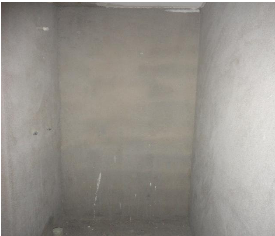
Figuras 55 y 56. Limpieza, alineamiento y nivelación para instalación del enchape.
