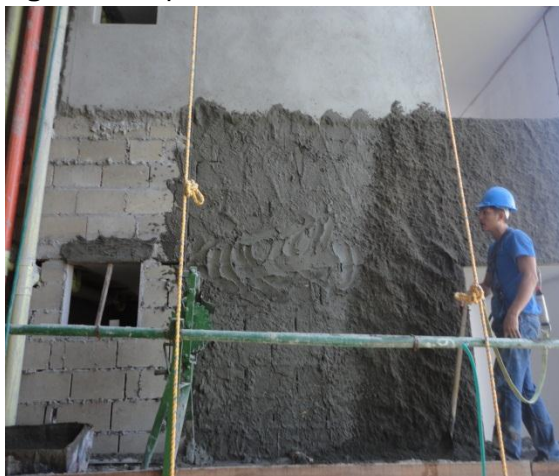
Figura 32. Aplicación del aditivo.
