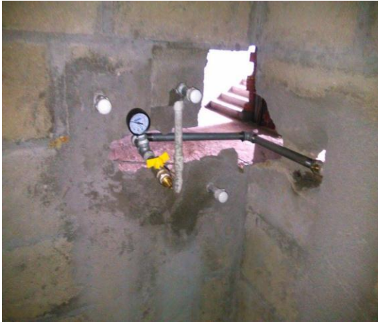
Figuras 93 y 94. Posibles daños generados por las pruebas de gas.
