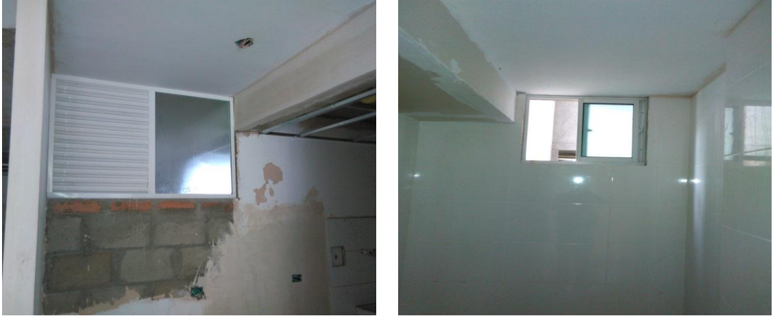
Figuras 99 y 100. Instalación ventanas ajustadas a las dimensiones de los diseños.
