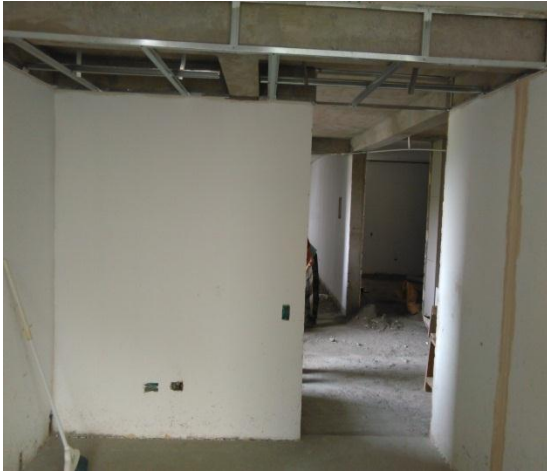
Figuras 77 y 78. Instalación Láminas de Drywall.
