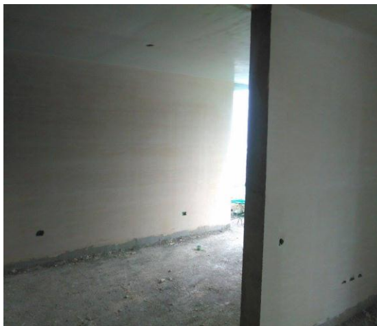
Figuras 65 y 66. Aplicación mezcla estuco y pulida de superficie.
