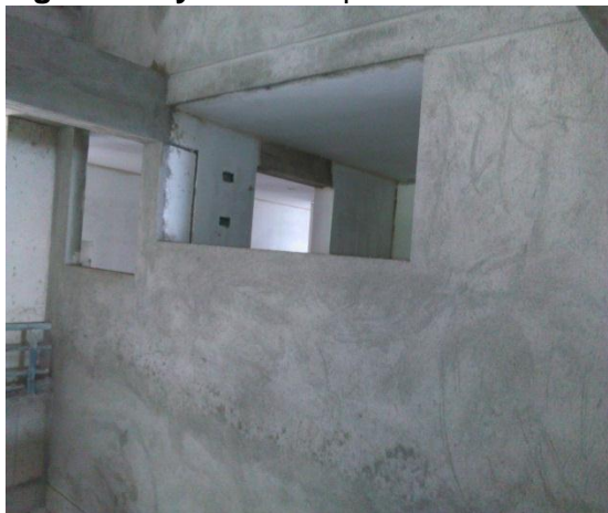
Figuras 97 y 98. Revoque de vanos de ventanas.
