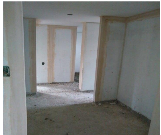
Figuras 67 y 68. Aplicación primera capa de pintura, fillos y dilataciones
