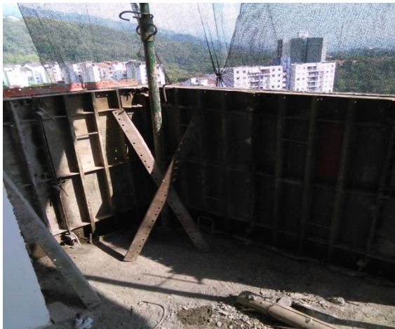
Figuras 20 y 21. Instalación de formaleta para los antepechos en concreto.
