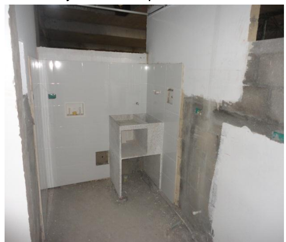
Figuras 61 y 62. Acabado final de enchape en baños y zona de ropas.
