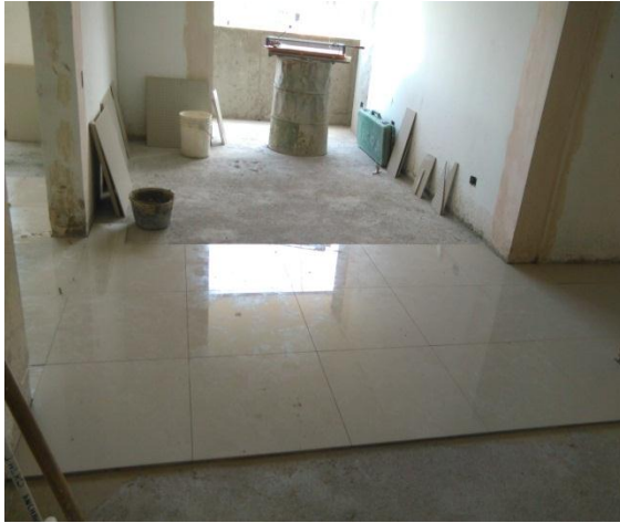
Figuras 44 y 45. Instalación de hiladas completas y chazos ajustados al área solicitada.
