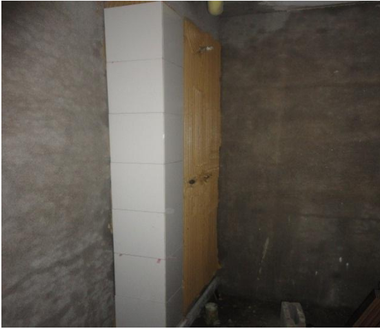
Figuras 57 y 58. Instalación de losas y pateras.
