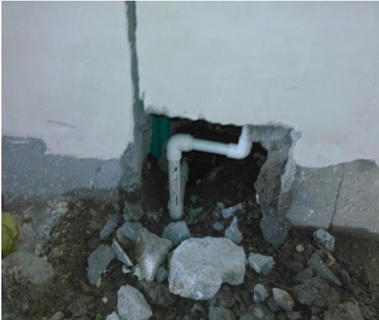
Figuras 87 y 88. Posibles daños generados por las pruebas que deben ser reparadas.
