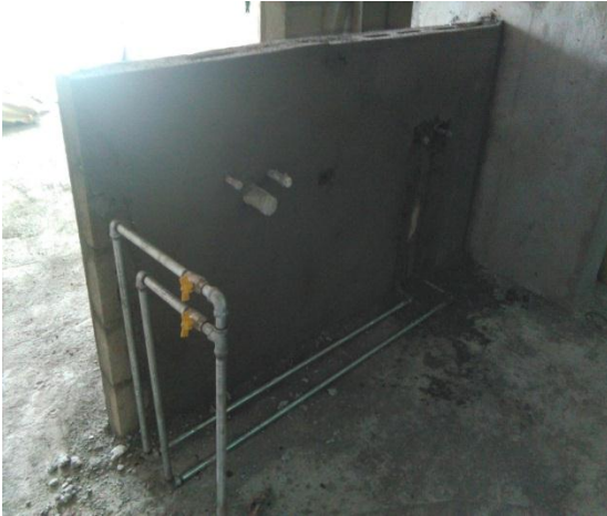
Figuras 89 y 90. Instalación de tuberías de gas por regata.
