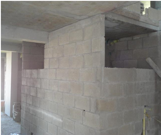
Figuras 25 y 26. Aprobación Muros por alineamiento y plomada.
