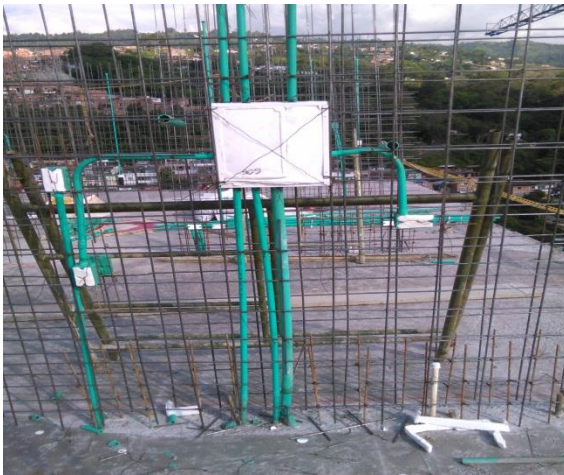
Figura 14. Verificar elementos embebidos.
