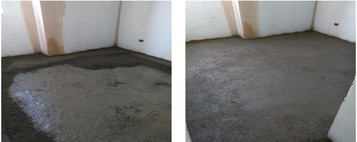
Figuras 39 y 40. Alistados de piso y acabado final con textura lisa.
