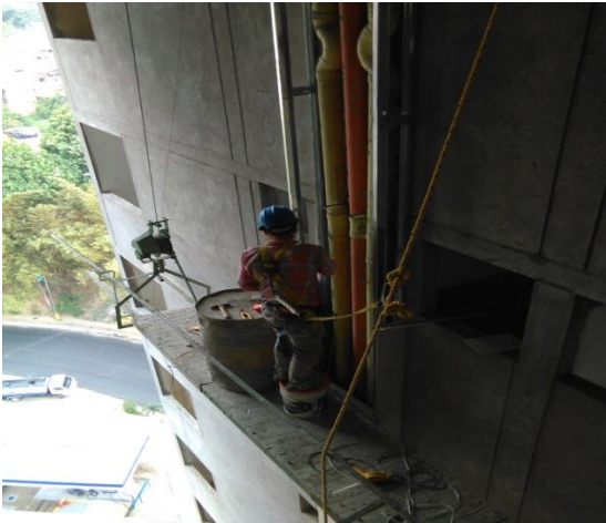
Figuras 79 y 80. Instalación y láminas de superboard.
