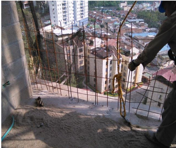
Figuras 18 y 19. Verificación refuerzo con malla electrosoldada.
