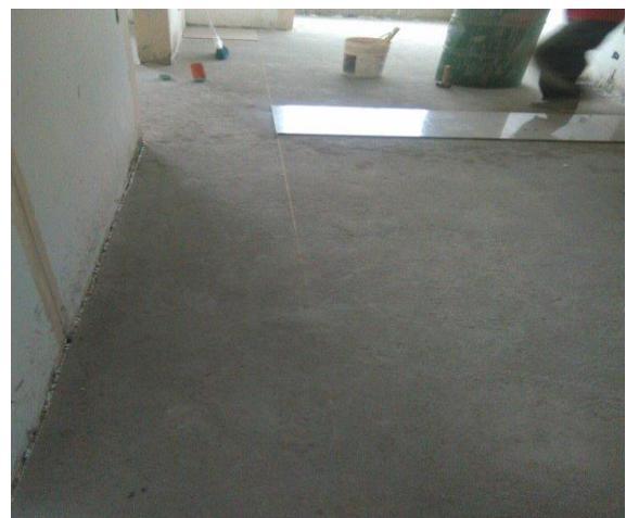
Figuras 42 y 43. Limpieza de la superficie y cuadro de la hilada de guía.
