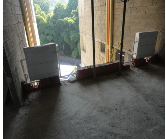
Figura 70. Instalación primera hilada.
