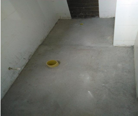
Figuras 50 y 51. Limpieza e impermeabilización de zonas húmedas.
