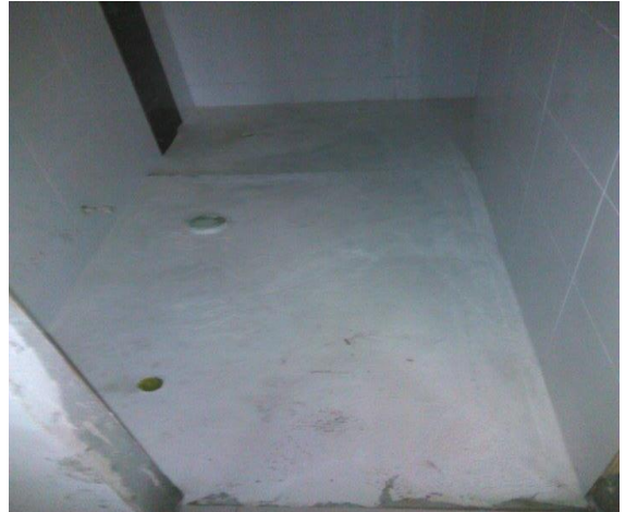
Figuras 50 y 51. Limpieza e impermeabilización de zonas húmedas.
