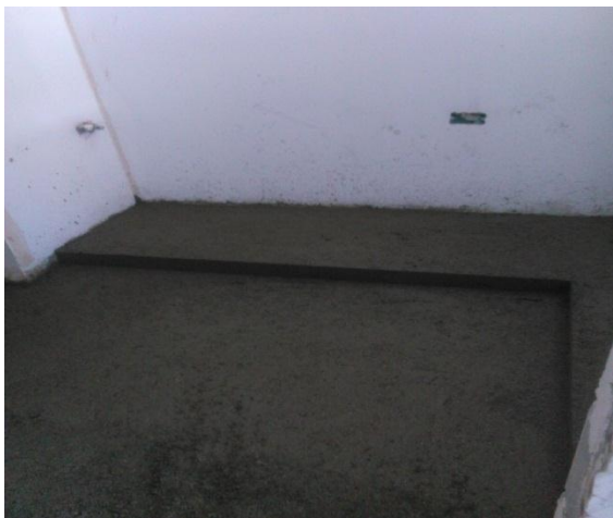
Figura 41. Elaboración de pollos o peldaños para apoyo de muebles de cocina.
