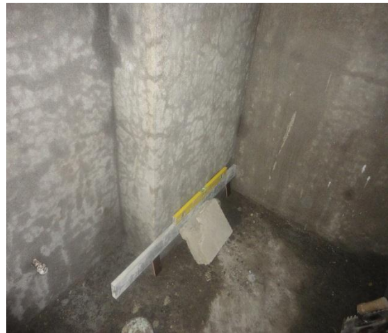
Figuras 55 y 56. Limpieza, alineamiento y nivelación para instalación del enchape.
