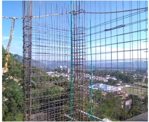
Figuras 12 y 13. Localización y verificación de refuerzo con malla electrosoldada.
