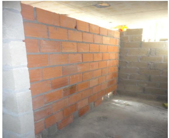
Figuras 25 y 26. Aprobación Muros por alineamiento y plomada.
