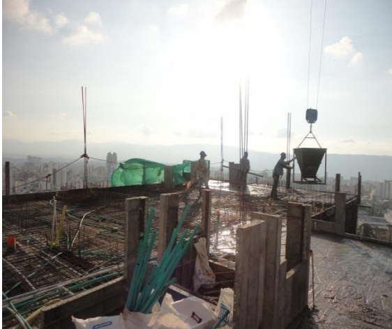
Figuras 9 y 10. Vaciado, vibración y alisado de la superficie.
