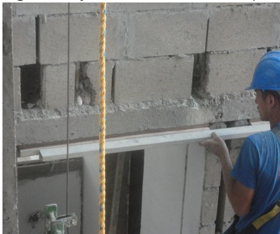
Figuras 34 y 35. Instalación de tablas para goteros y alisamiento de embones.
