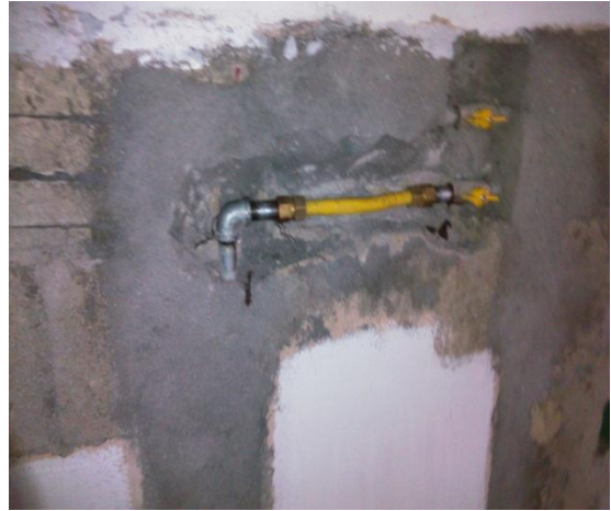
Figuras 93 y 94. Posibles daños generados por las pruebas de gas.
