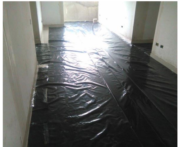
Figuras 46 y 47. Terminado final y forro de la superficie con plástico.
