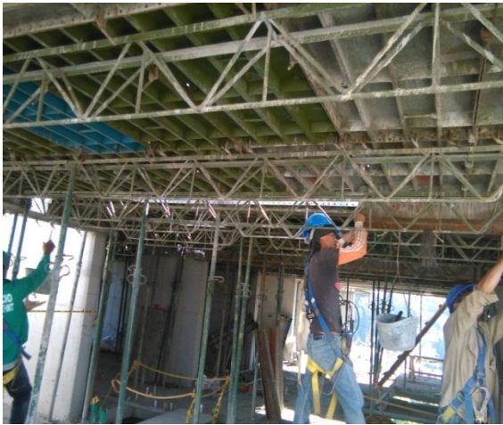
Figuras 5 y 6. Instalación elementos verticales para soporte del concreto.
