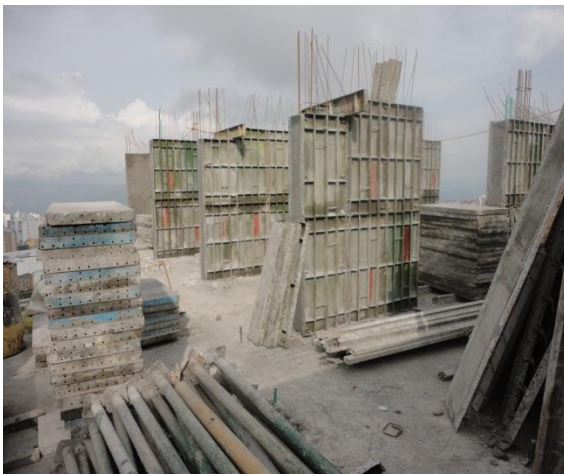
Figuras 16 y 17. Retiro de formaletas y adecuada ubicación para evitar accidentes.
