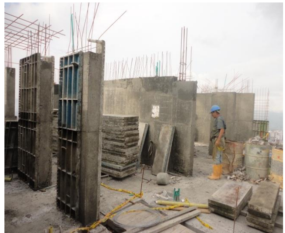
Figuras 16 y 17. Retiro de formaletas y adecuada ubicación para evitar accidentes.
