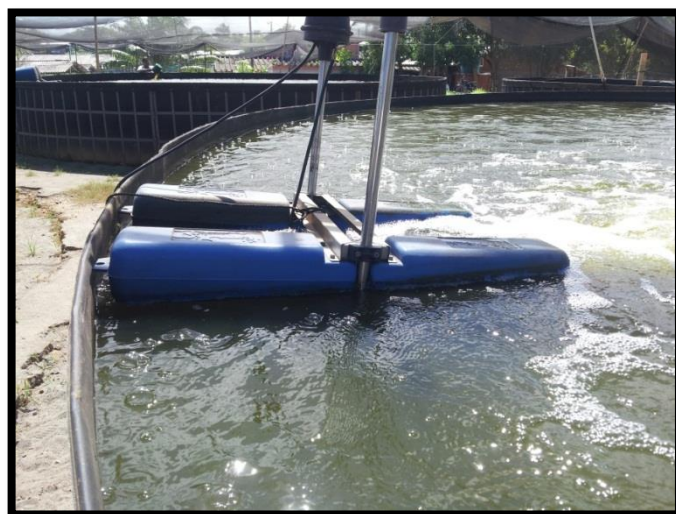
Figura 11: Estanque de geomembrana con aireación.
