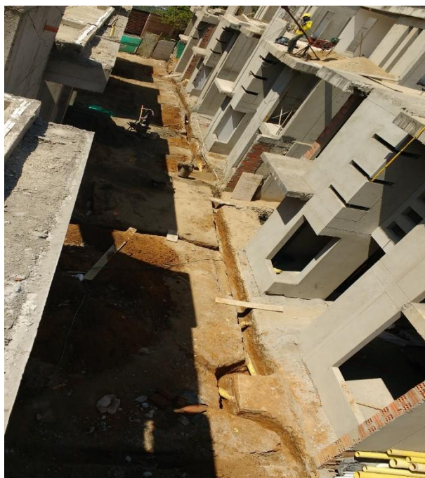
Imagen 22. Excavación de zanja, para la disposición de la red de alcantarillado.
