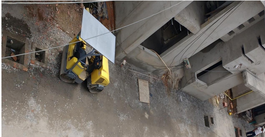
Imagen 23. Compactación del relleno para la zanja del sistema de alcantarillado.
