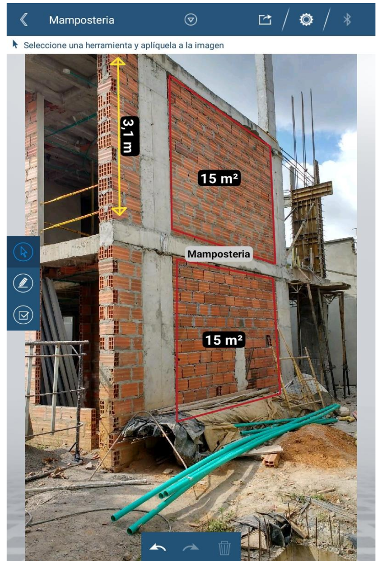
Imagen 21. Medición de los metros lineales y cuadrados de mampostería, mediante la aplicación MEASURING MASTER BOSCH.
