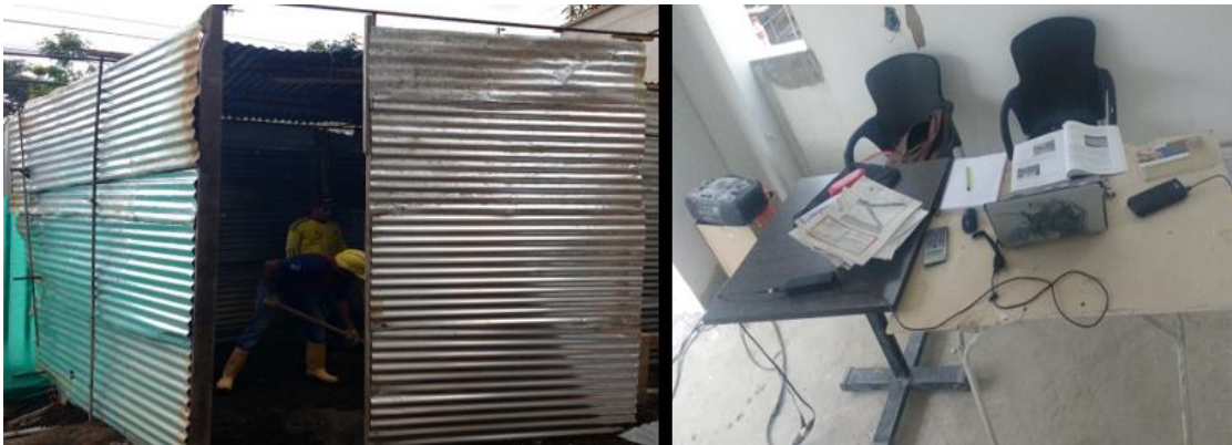
Imagen 13. Adecuación del almacén y oficina de obra.
