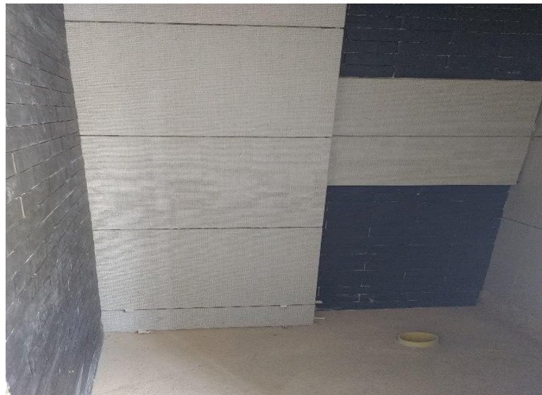
Imagen 25. Obra blanca con combinación de enchapes en pared de baño.
