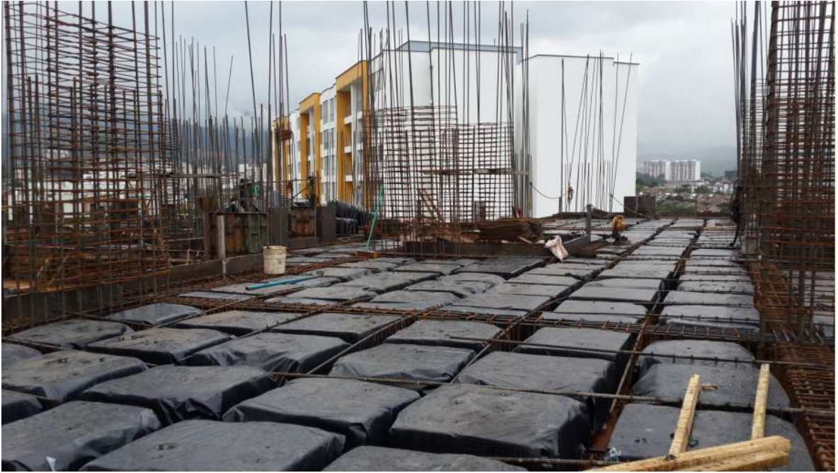
Imagen 25. Instalación de casetones en icopor
