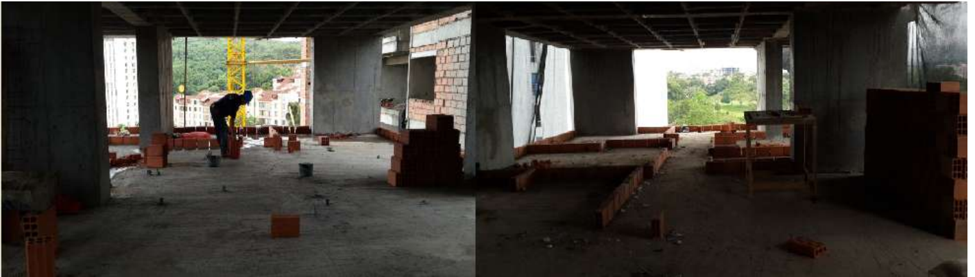
Imagen 26. Replanteo en Mampostería
