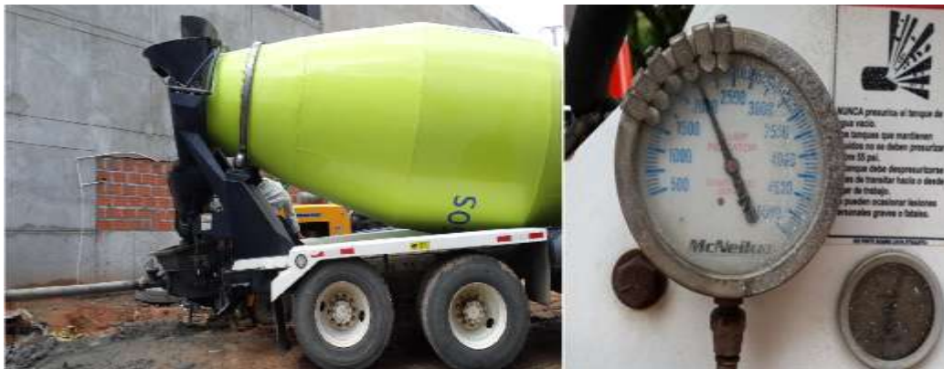
Imagen 5. Mixer e Indicador de Asentamiento
