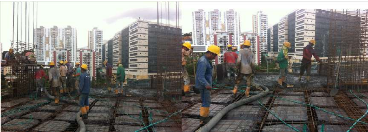
Imagen 30. Fundida de Placa Apartamento 01
