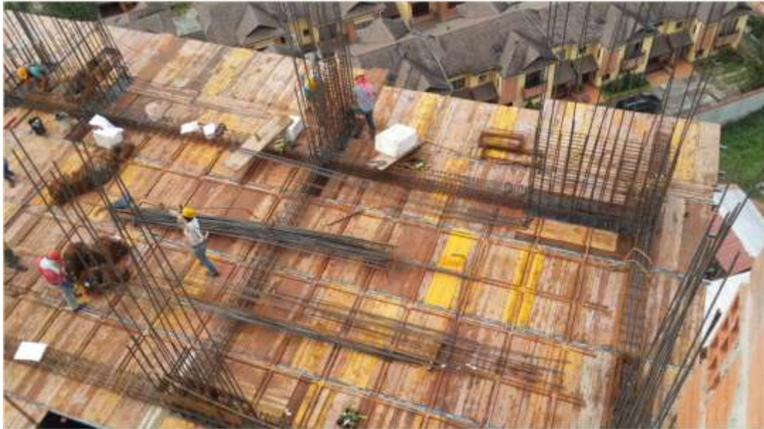
Imagen 23. Instalación de Estribos en Columnas
