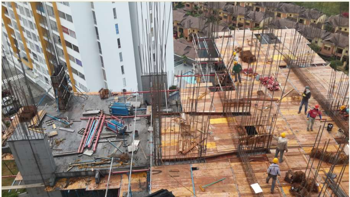
Imagen 24. Armado de vigas y entablado de Placa
