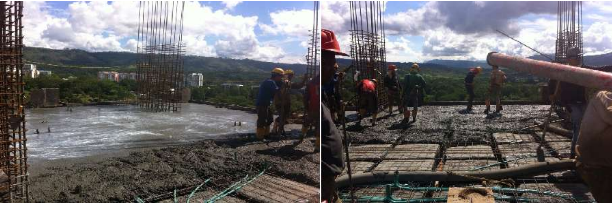
Imagen 29. Fundida de Placa Apartamento 02
