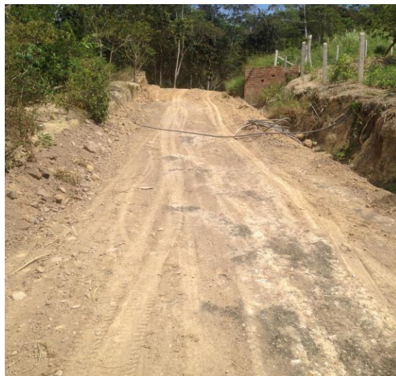
Figura 13. Replanteo del terreno
