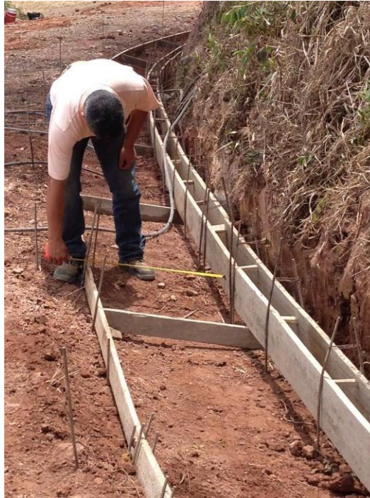
Figura 16. Construcción de la huella
