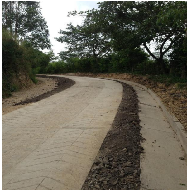
Figura 3. Vereda la puente 300ML ( terminado )
