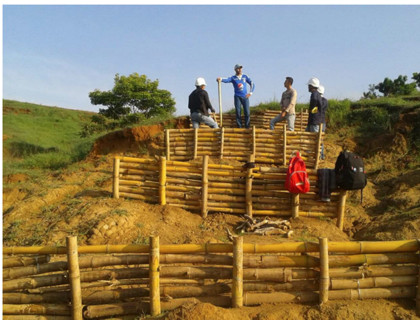
Figura 4. Estructura de trinchos
