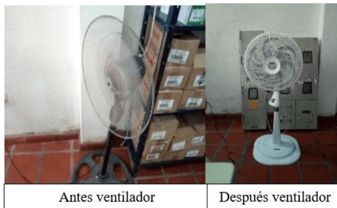
Figura 41. Antes y después ventilador
