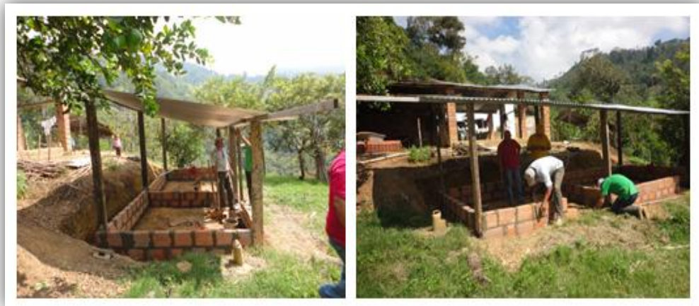
Fotografía 6. Construcción de galpones en la granja A
