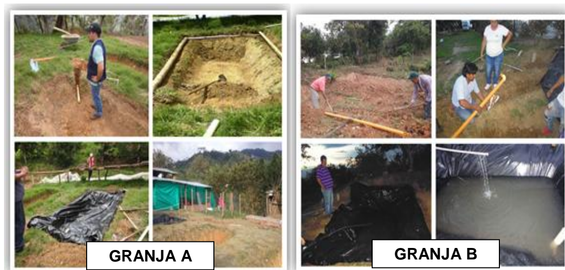
Fotografía 4. Construcción de los estanques piscícolas en las granjas A y B
