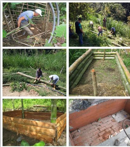
Fotografía 13. Construcción de composteras en diferentes materiales
