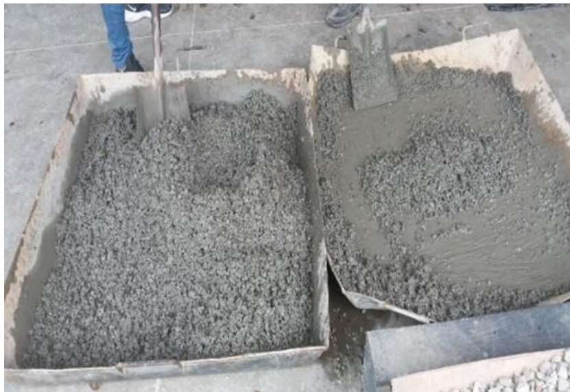
Figura 16. Preparación de la mezcla de concreto.
