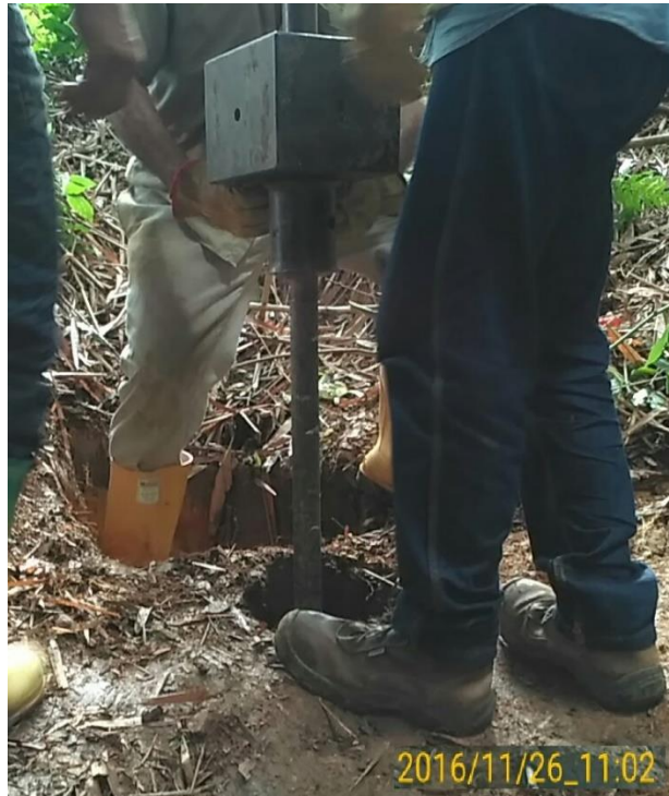
Figura 25. Enroscado del martinete a la tubería de perforación.
