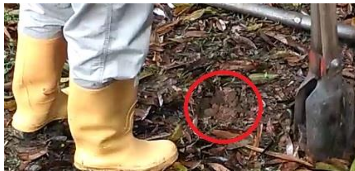
Figura 18. Retiro de capa vegetal.
