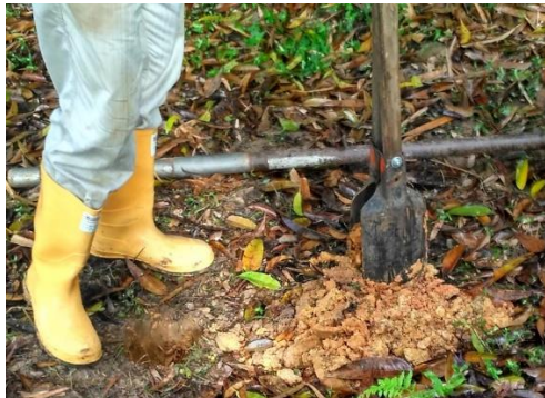
Figura 19. Excavación con herramienta manual posteadora.
