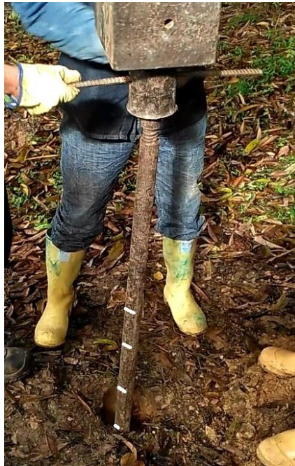
Figura 34. Unión martinete con tubería de perforación adicionada.
