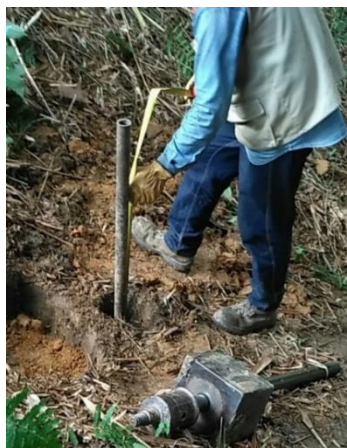
Figura 22. Hincado de muestreador y tubería de perforación.
