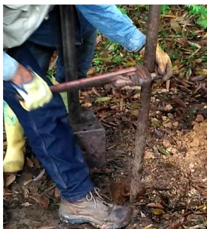
Figura 33. Adición de tubería de perforación.
