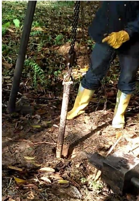
Figura 28. Retiro de la tubería de perforación enroscada al muestreador.
