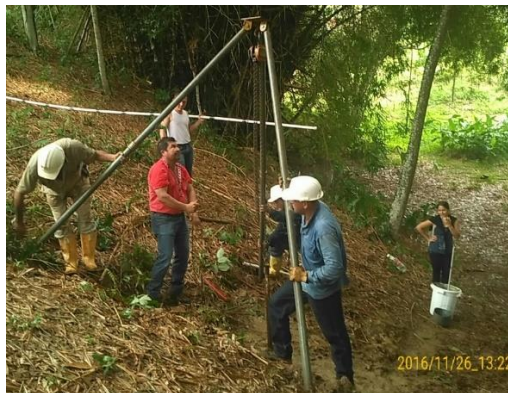
Figura 15. Montaje del trípode.
